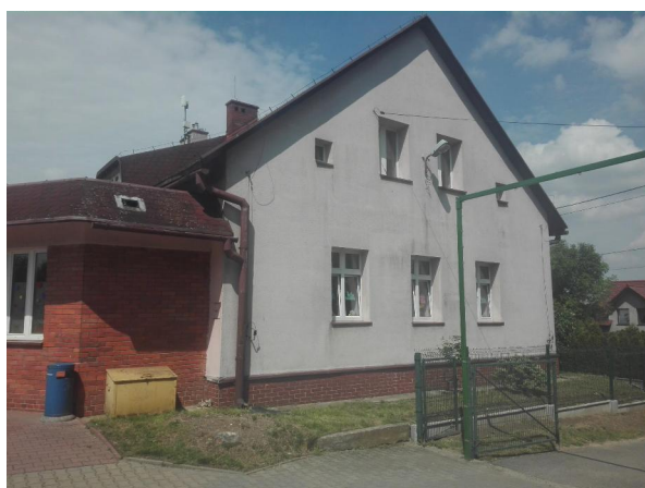
Fot.3 Elewacja wschodnia
