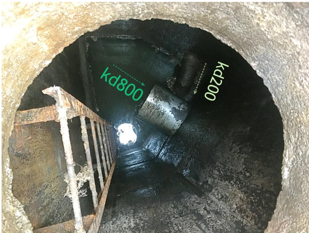
Zdjęcie 4. Widok do wnętrza drugiej komory w studni; dolot kanalizacji kd200 i odpływ kd800
