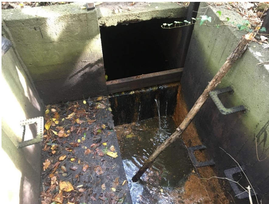
Zdjęcie 2. Widok w komorze otwartej [D6] na prostokątny kanał drenażowy kd600 z zastawką
