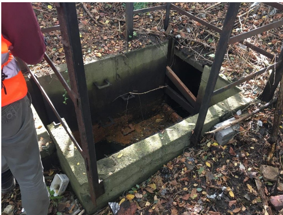
Zdjęcie 1. Otwarta komora zbiorcza [D6] na drenażowym kanale kd600 wzdłuż Czarnej Wody
