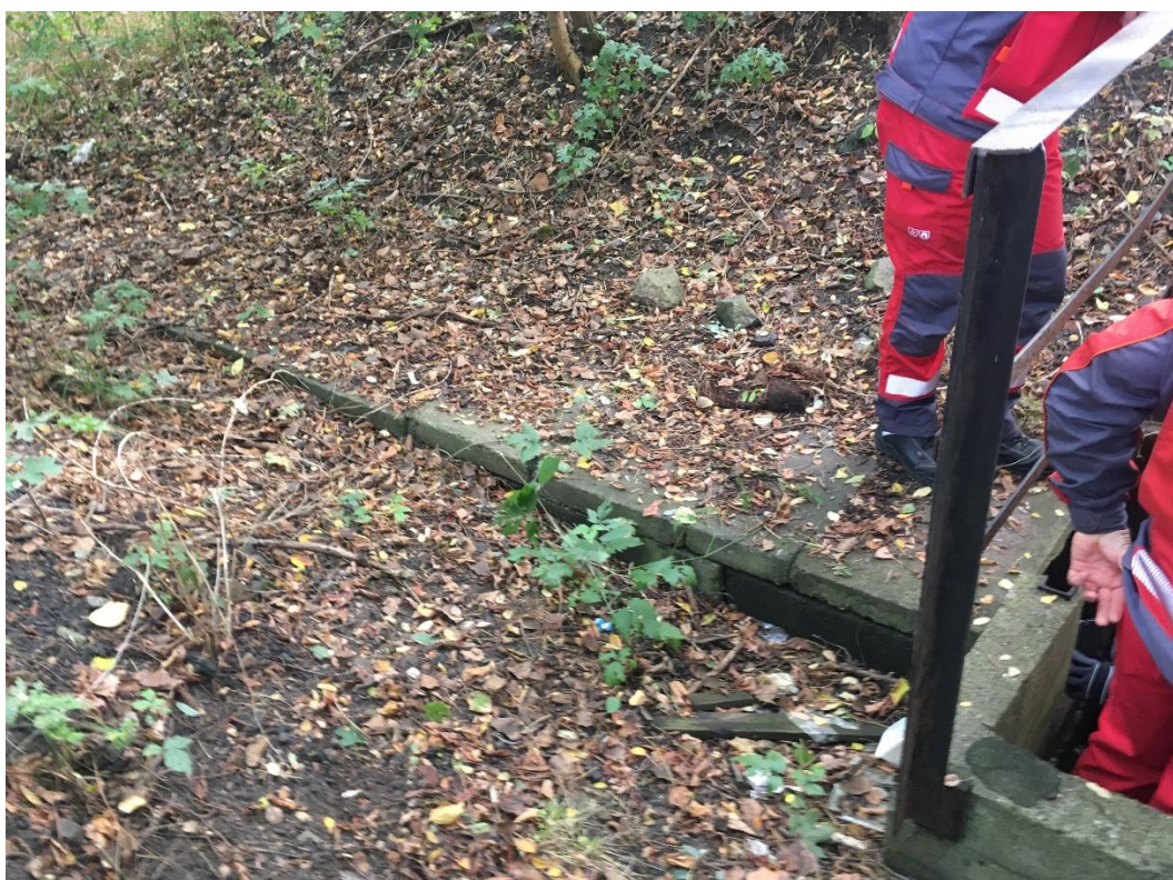
Zdjęcie 6. Kanały drenażowe z płytami pokrywowymi (z prawej strony likwidowana komora)
