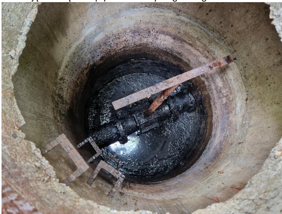
Zdjęcie 3. Studnia z zasuwą zlokalizowana obok komory otwartej
