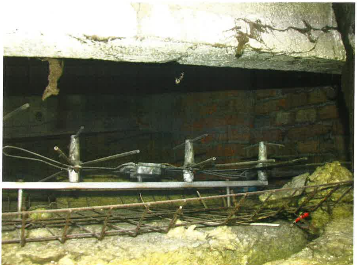
Fot. 8. Widok konstrukcji dachu
