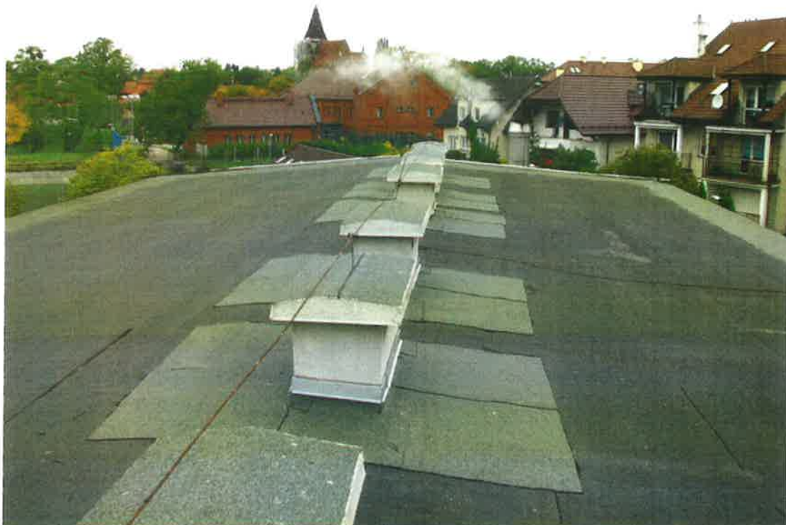
Fot. 5. Widok dachu
