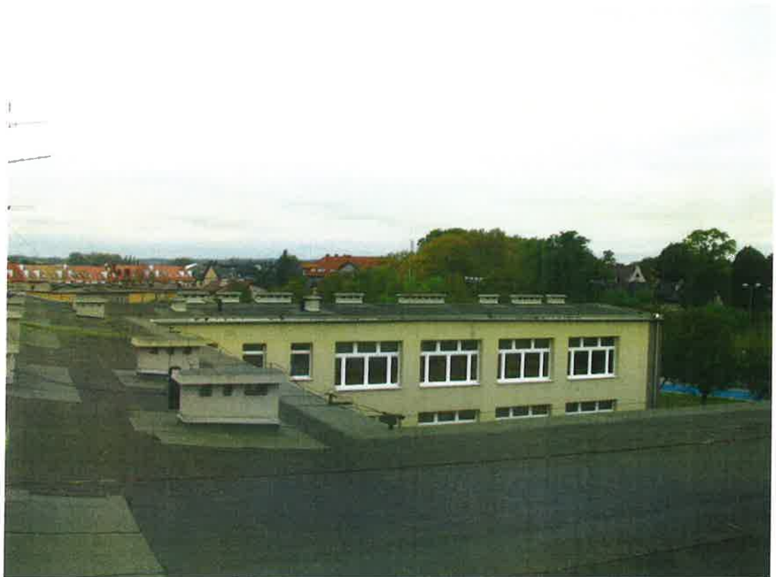
Fot. 4. Widok dachu
