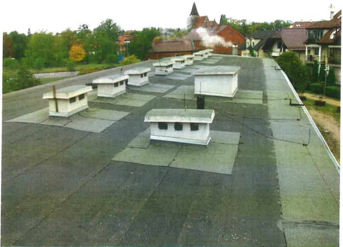
Fot. 3. Widok dachu
