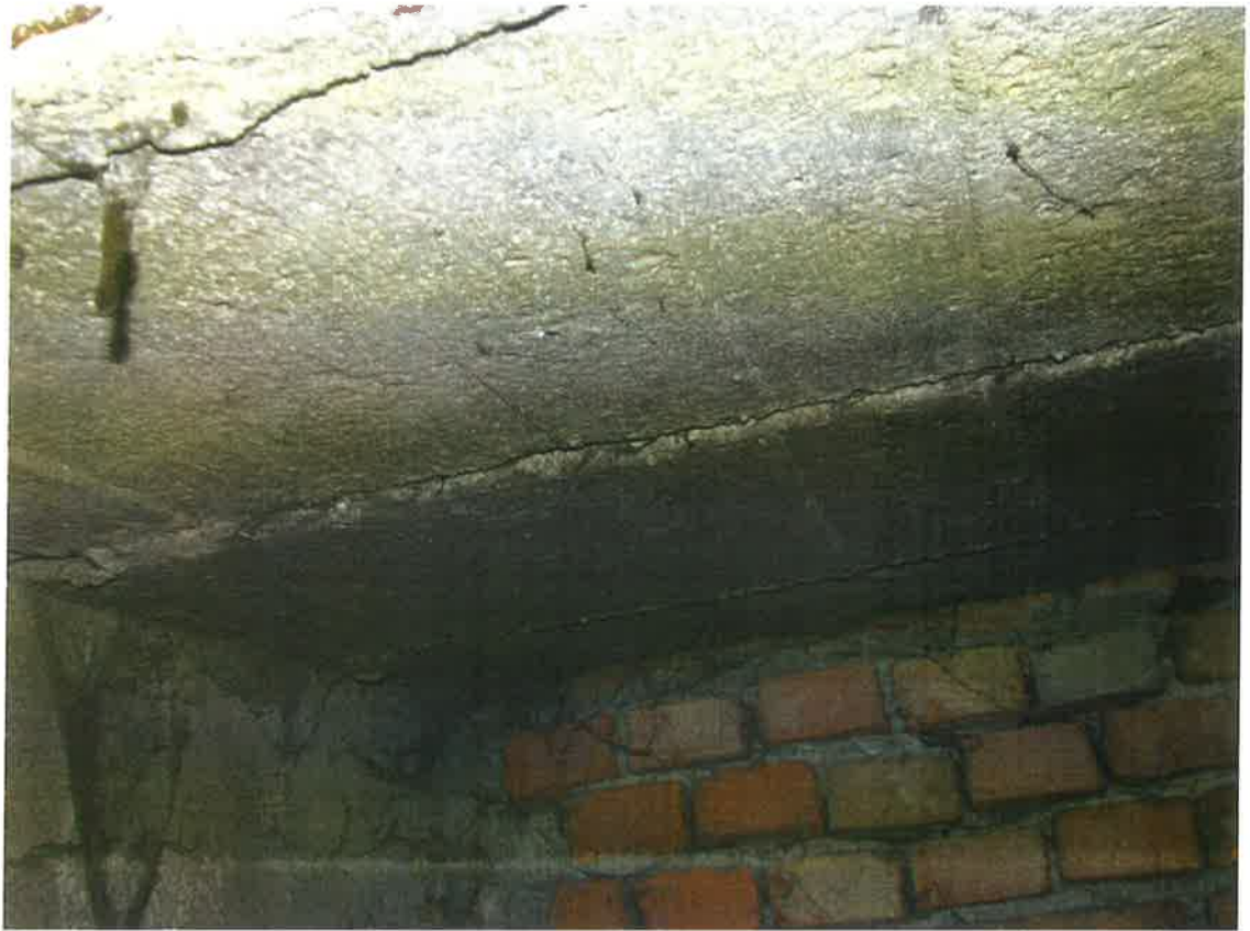
Fot. 7. Widok konstrukcji dachu
