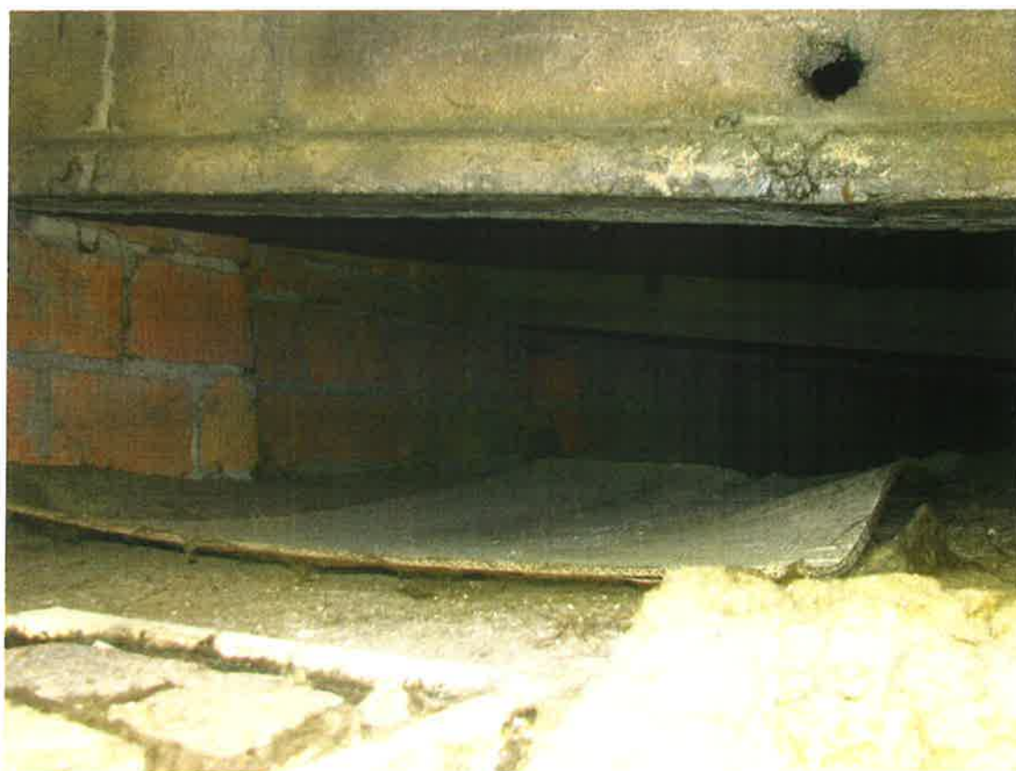
Fot. 6. Widok konstrukcji dachu
