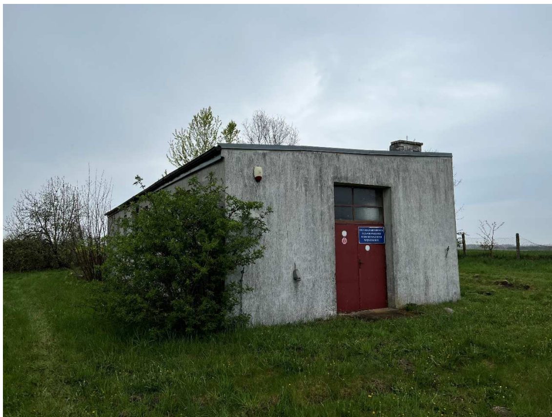
Fot.3. Budynek stacji uzdatniania wody w Dobrzycy
