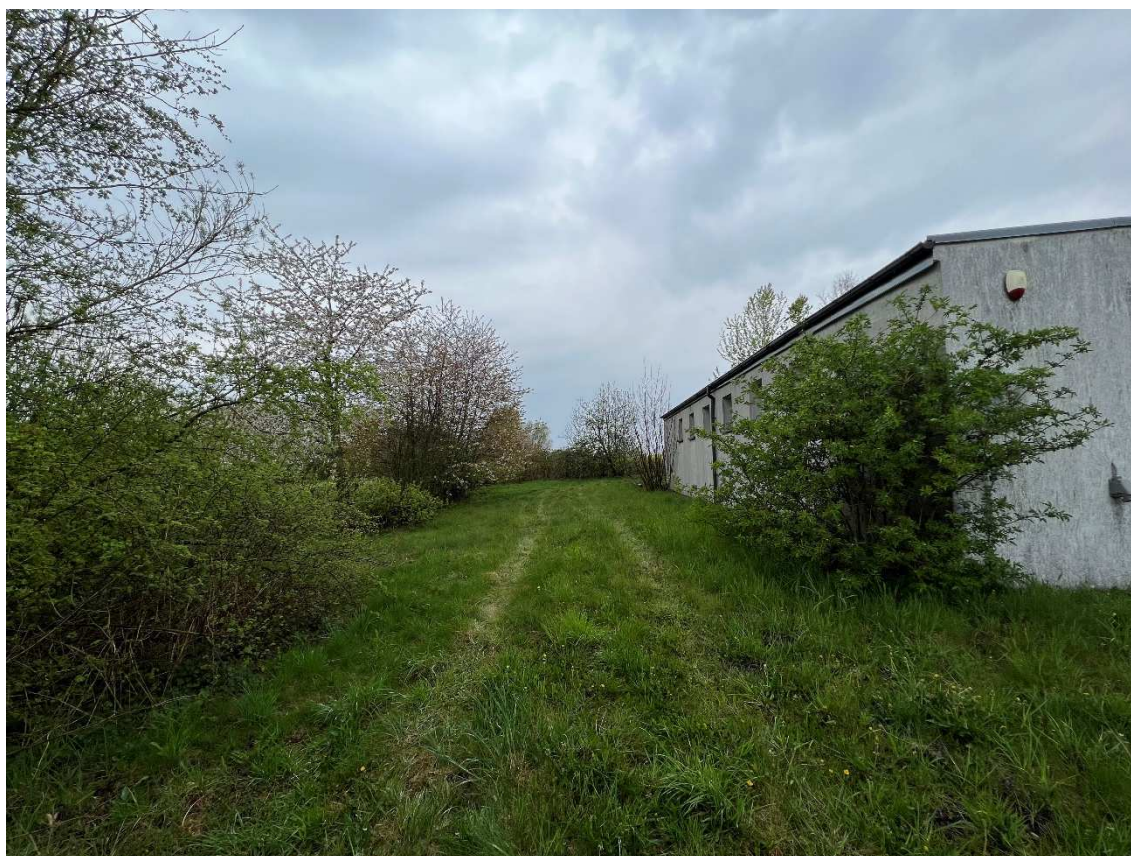
Fot. 12. Teren stacji uzdatniania wody – miejsce przewidywanej lokalizacji odstoju wód popł.
