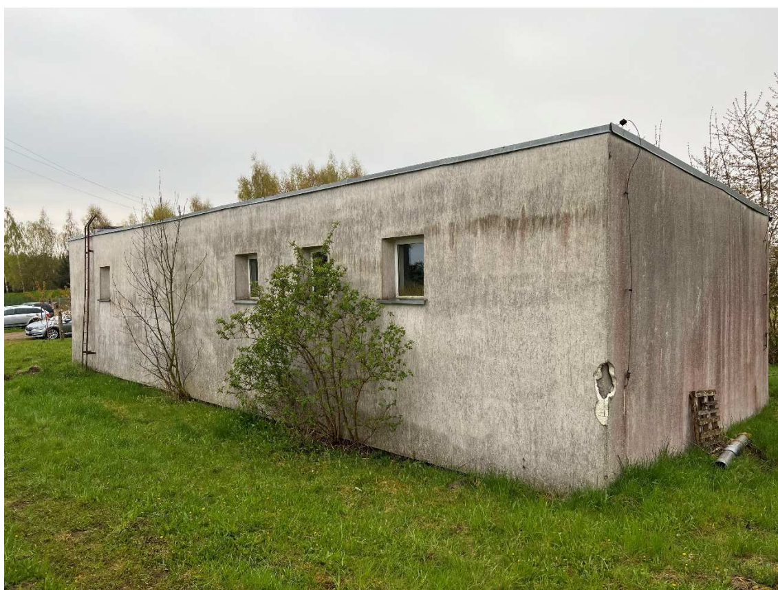
Fot.4. Budynek stacji uzdatniania wody w Dobrzycy
