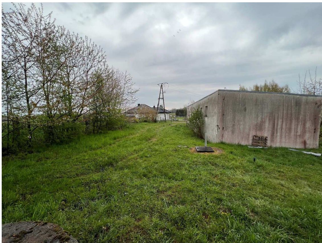
Fot. 11. Teren stacji uzdatniania wody – miejsce przewidywanej lokalizacji zbiorników ret.
