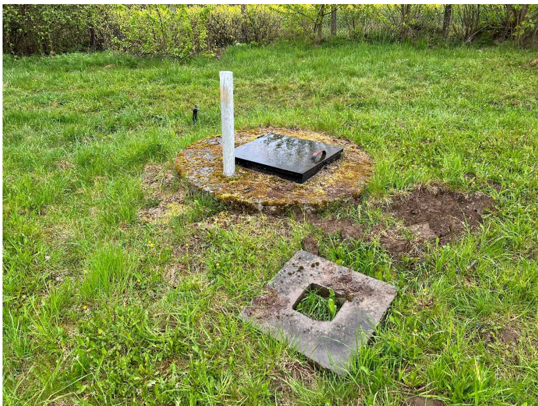
Fot. 2. Ujęcie wody – obudowa studni głębinowej nr SW2
