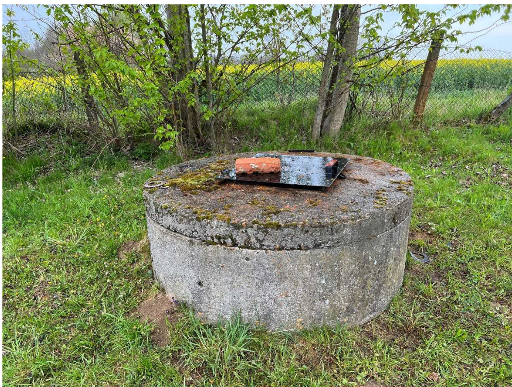
Fot. 1. Ujęcie wody – obudowa studni głębinowej nr SW1
