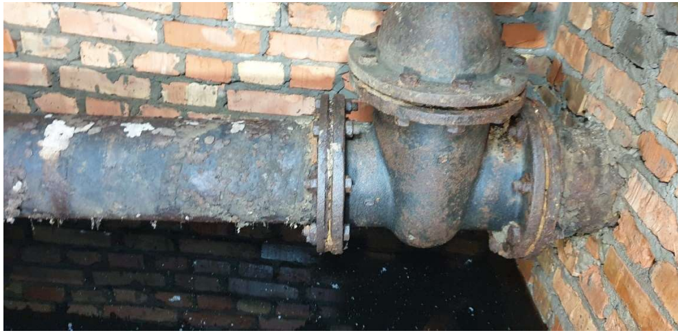
Fot.4 Wnętrze Komory nr 1
