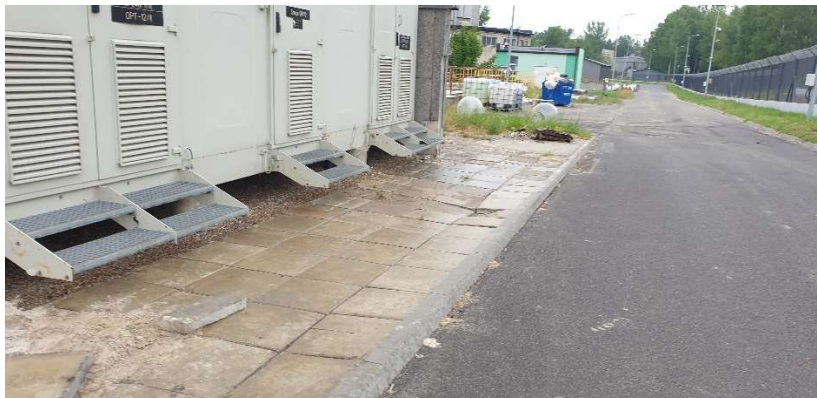
Fot.29 Chodnik od strony drogi
