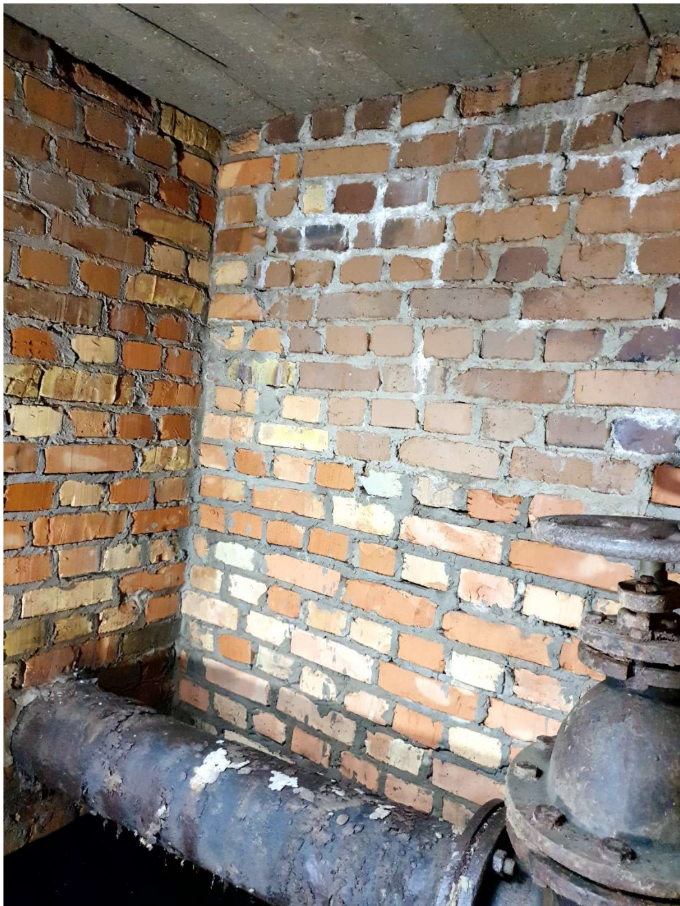
Fot.5 Wnętrze Komory nr 1
