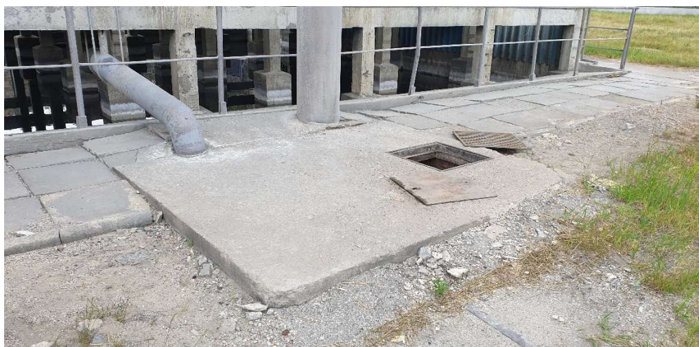
Fot.2 Widok Komory nr 1
