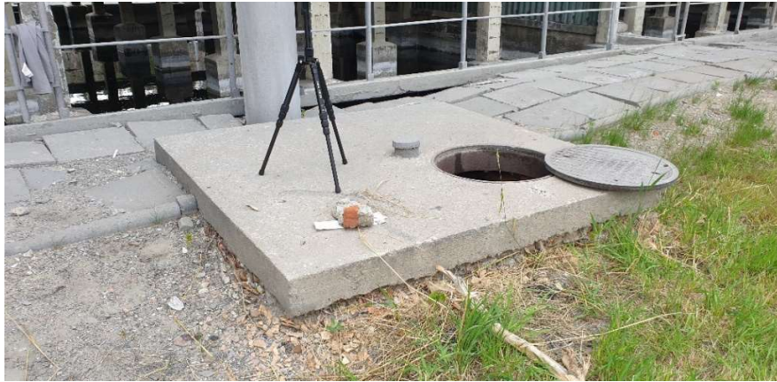
Fot.18 Widok Komory nr 4
