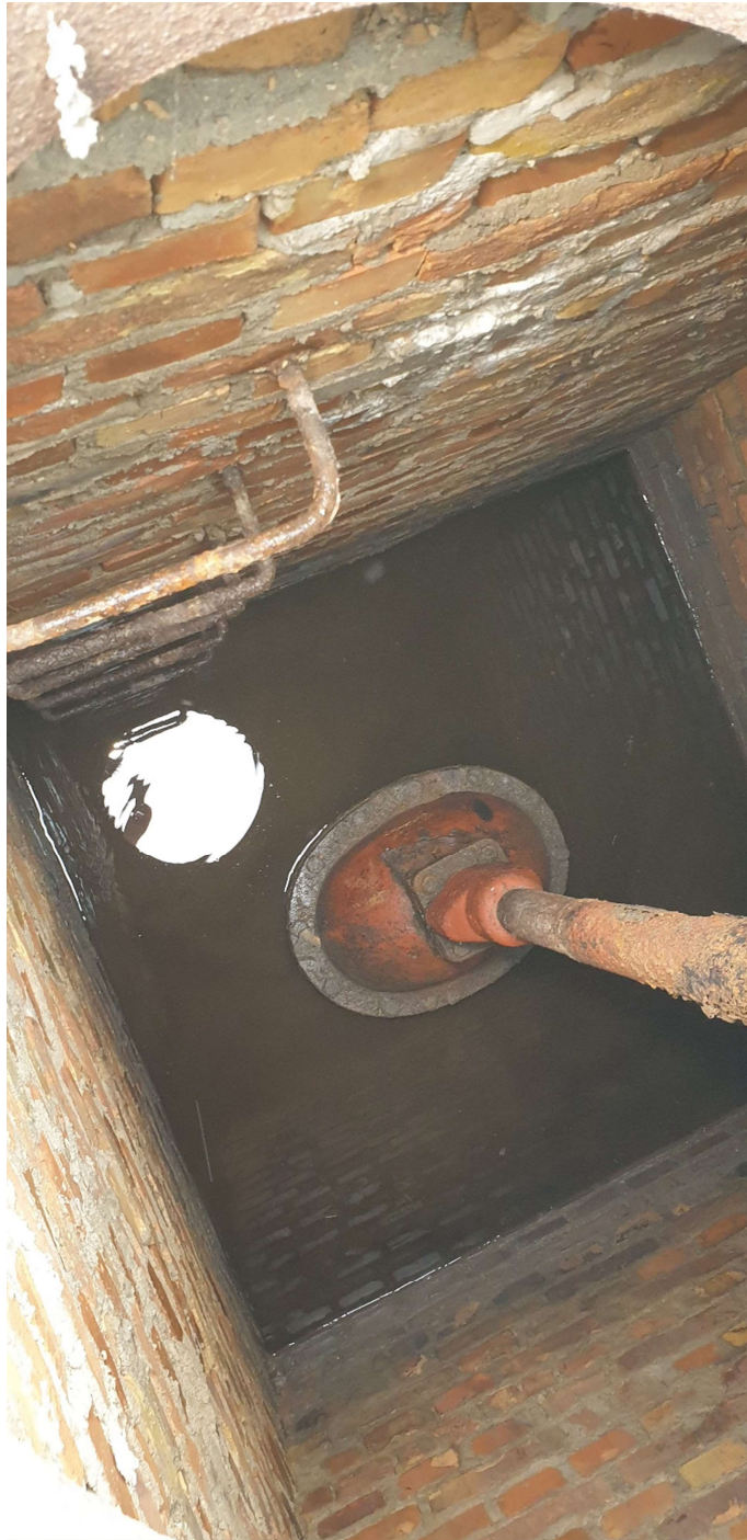
Fot.22 Widok Komory nr 4
