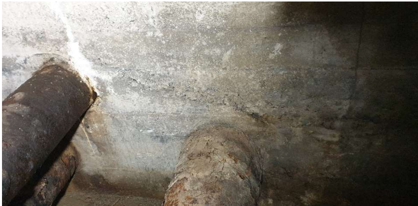
Fot.10 Przejścia przez ścianę w Komorze nr 2
