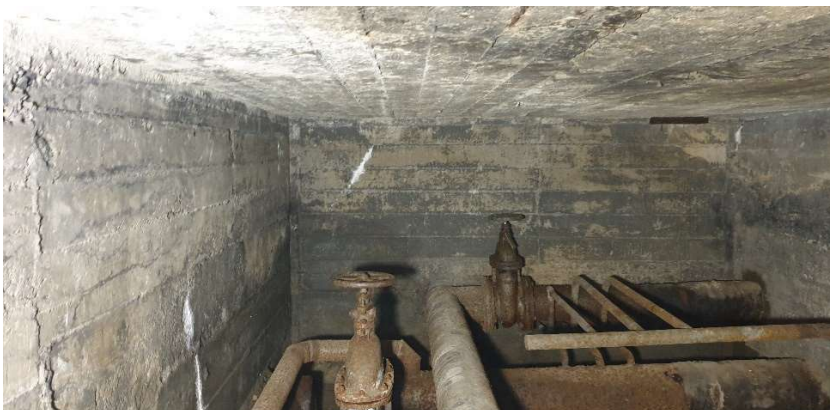
Fot.8 Wnętrze Komory nr 2
