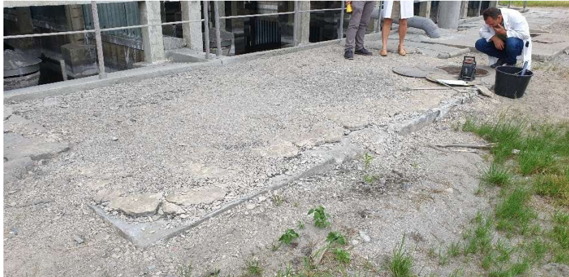
Fot.6 Widok Komory nr 2
