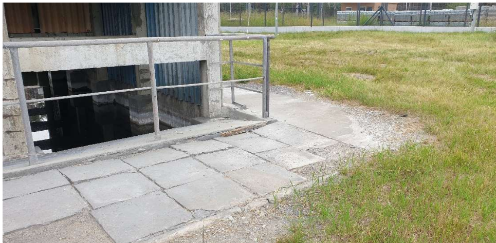
Fot.23 Chodnik w narożu południowo-zachodnim
