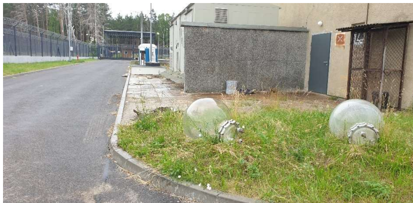
Fot.28 Chodnik od strony drogi
