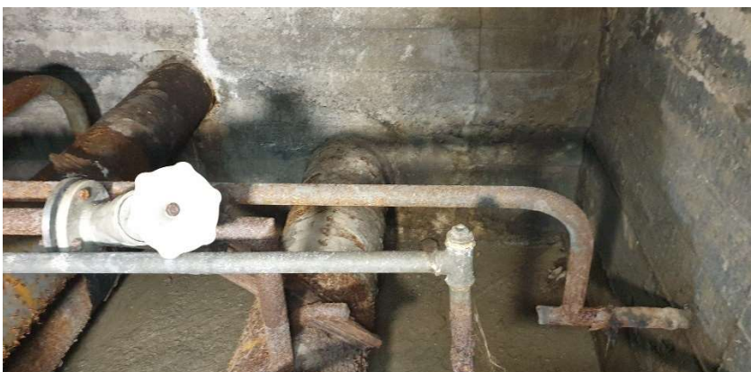
Fot.12 Widok wnętrza Komory nr 2 (brak wody)
