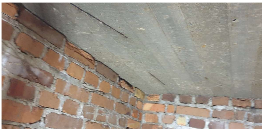
Fot.3 Strop w Komorze nr 1
