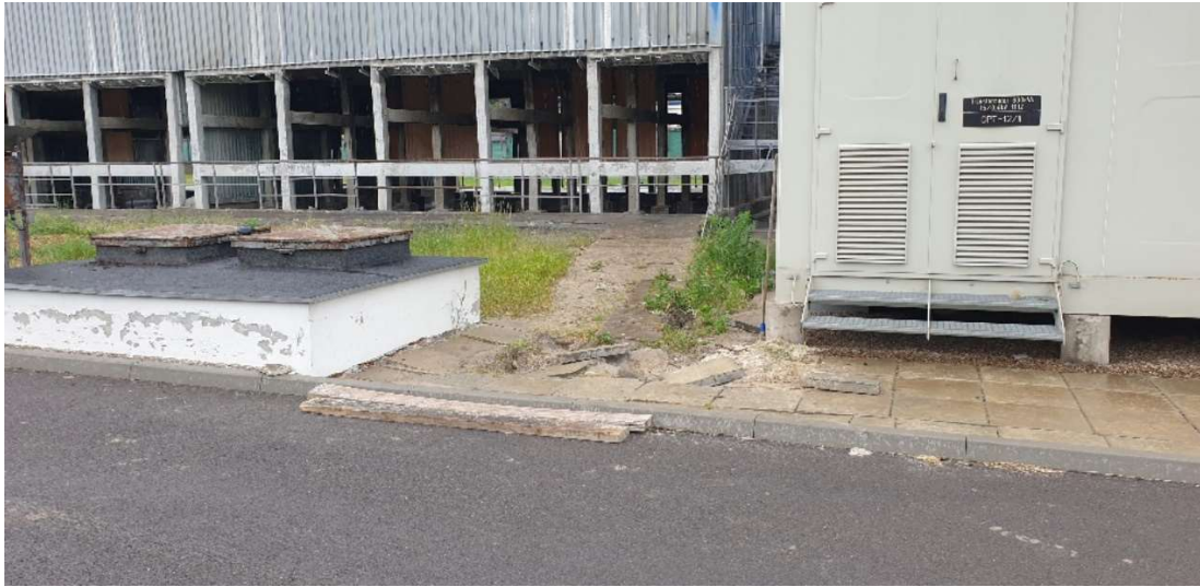
Fot.30 Chodnik od strony drogi
