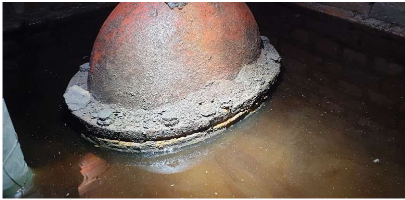
Fot.21 Zabetonowana w podłożu zasuwa Komorze nr 4
