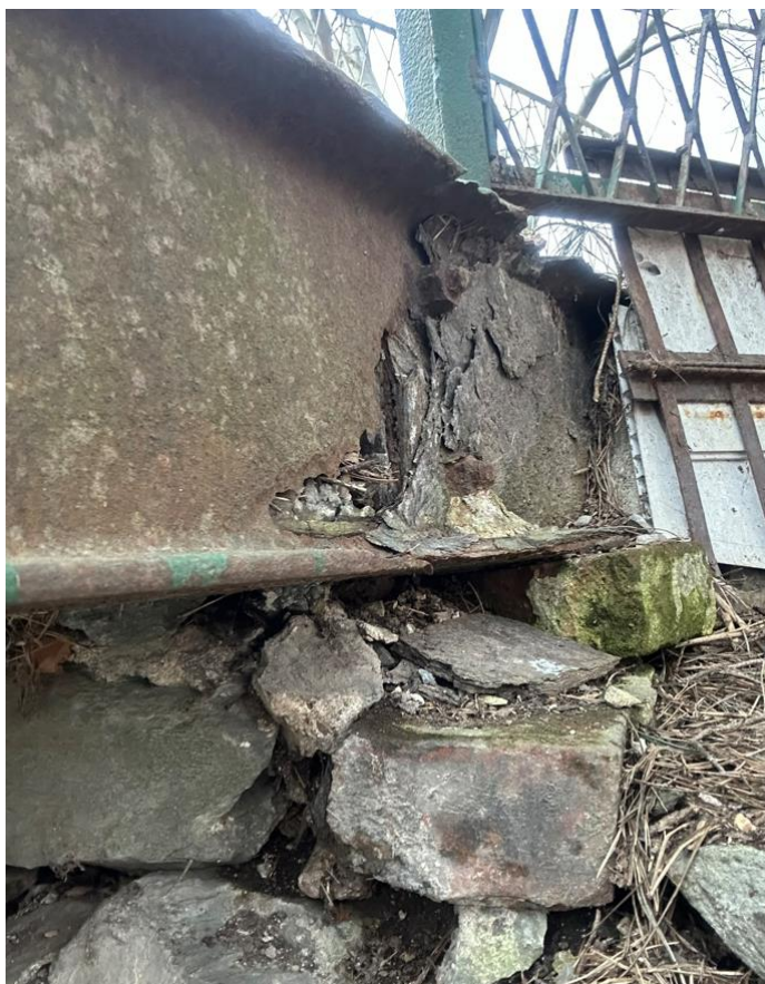
Rysunek 20. Obiekt nr 3 – widok na zdegradowaną strefę podporową dźwigara
