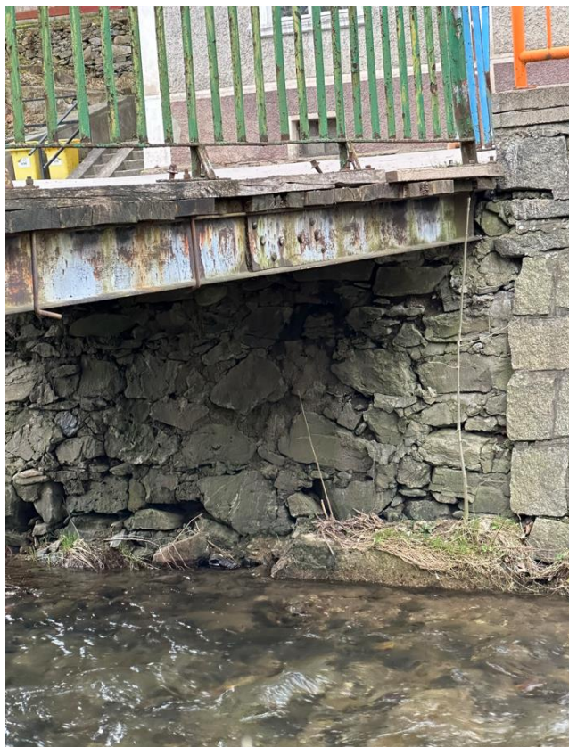
Rysunek 24. Obiekt nr 7 – widok na zdegradowany przyczółek
