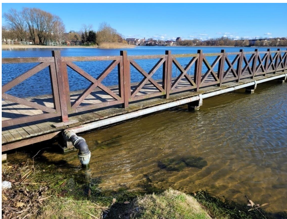
Fot.7. Widok na istniejącą infrastrukturę techniczną biegnącą wzdłuż istniejącego pomostu.
