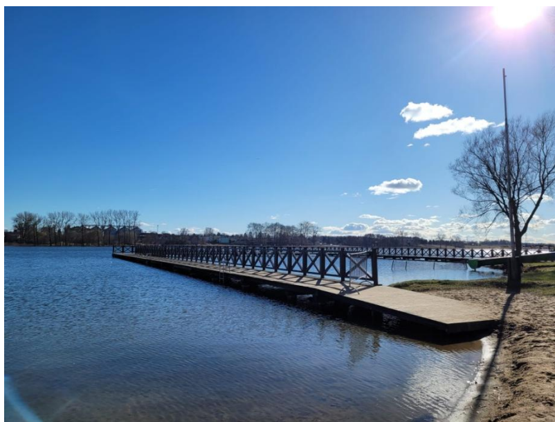
Fot.2. Widok na istniejący pomost od strony plaży miejskiej
