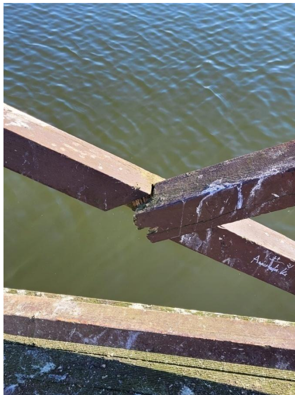
Fot.5. Widok na uszkodzenia elementów balustrady drewnianej. Widoczna korozja biologiczna, brak odporności materiału na niszczące warunki wilgoci i wody.
