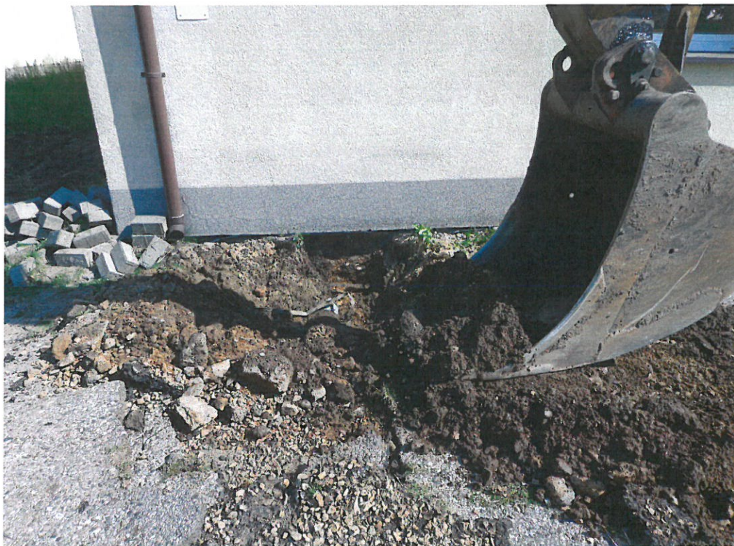
Fot. 5 Odkrywka druga, widoczna struktura gruntu nasypowego.
