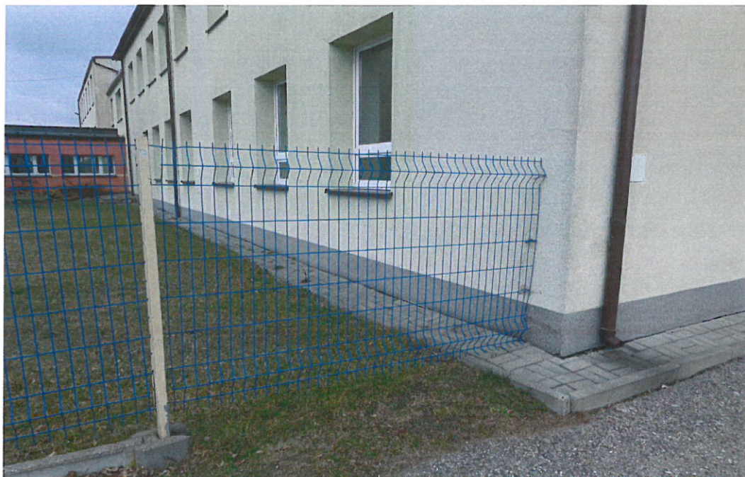
Fot. 1 Narożnik starej części budynku – miejsce wykonanych odkrywek.
