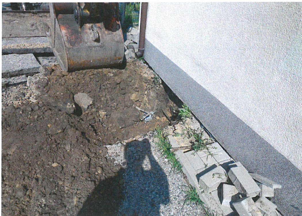
Fot. 6 Odkrywka druga, widoczny grunt nasypowy.
