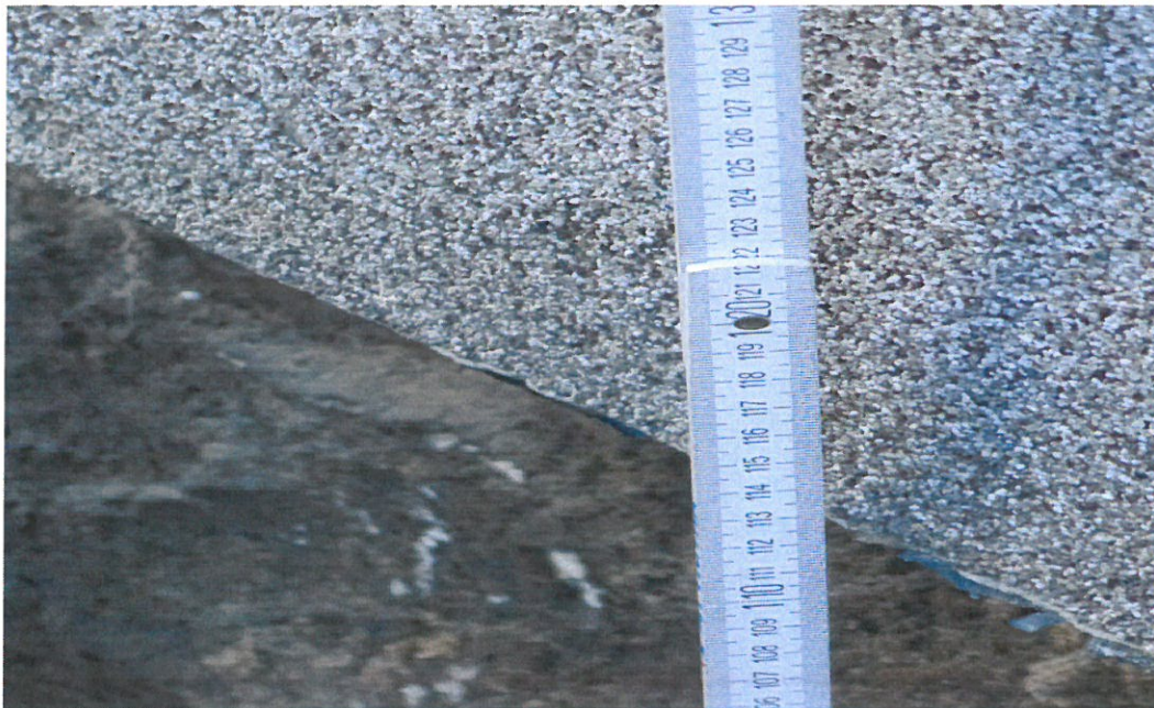
Fot. 3 Odkrywka – widoczny mur z kamienia wapiennego.
