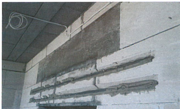
Przykładowy schemat wzmocnienia nadproża
