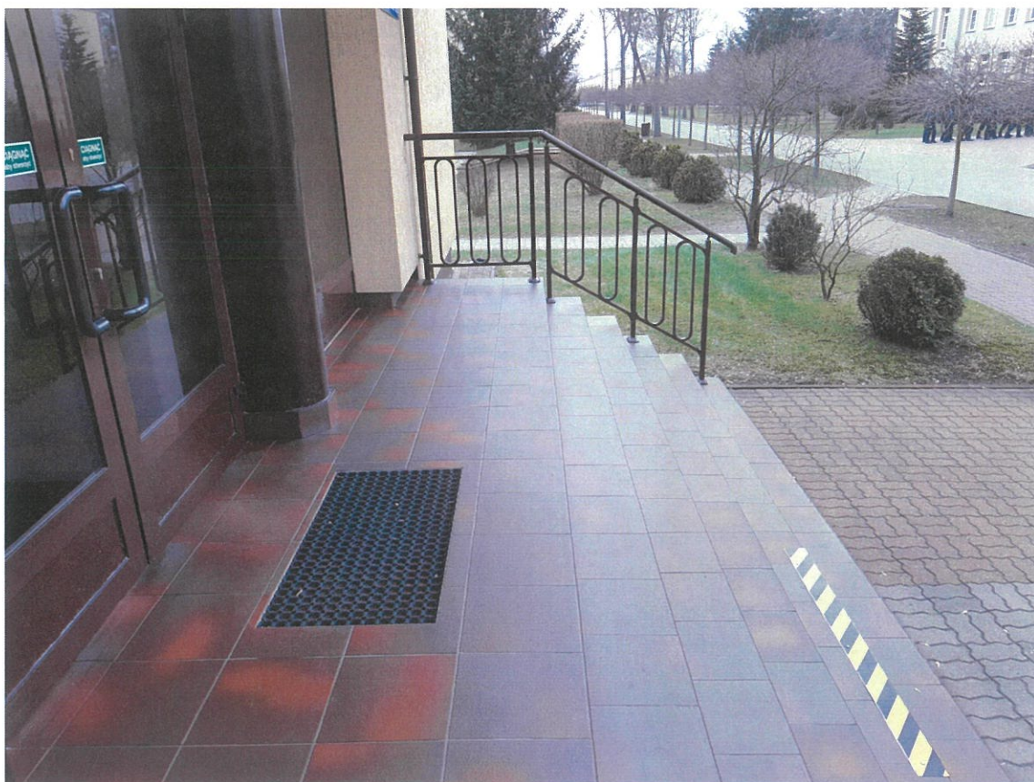
Fot. nr 4 – Balustrada.
