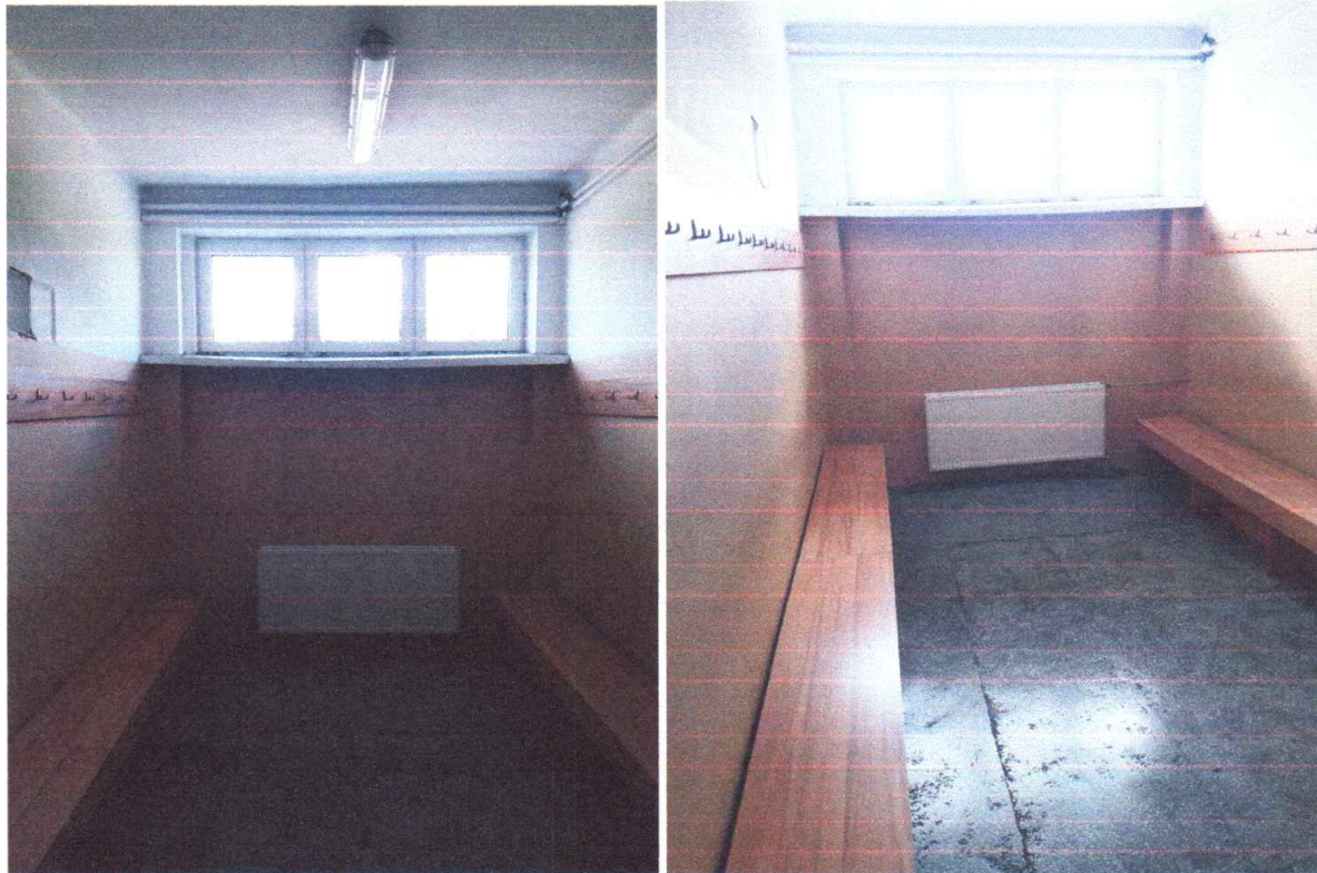
Zdjęcie 3,4 widok na pomieszczenia szatni
