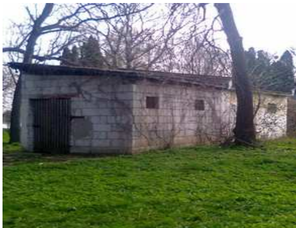
Zdj. nr 5 – Budynek „barak”
