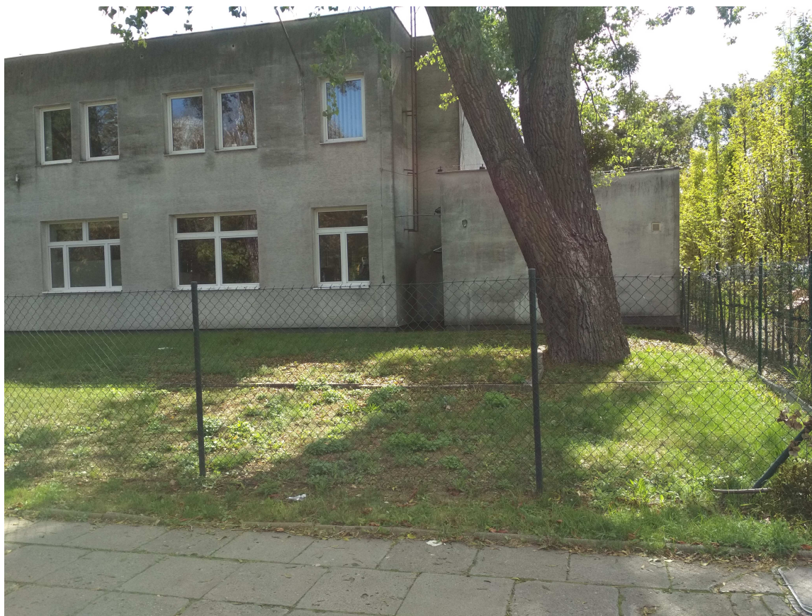
Fotografia nr 1: Widok na budynek uniwersytecki – w tle drabina przewidziana do demontażu
