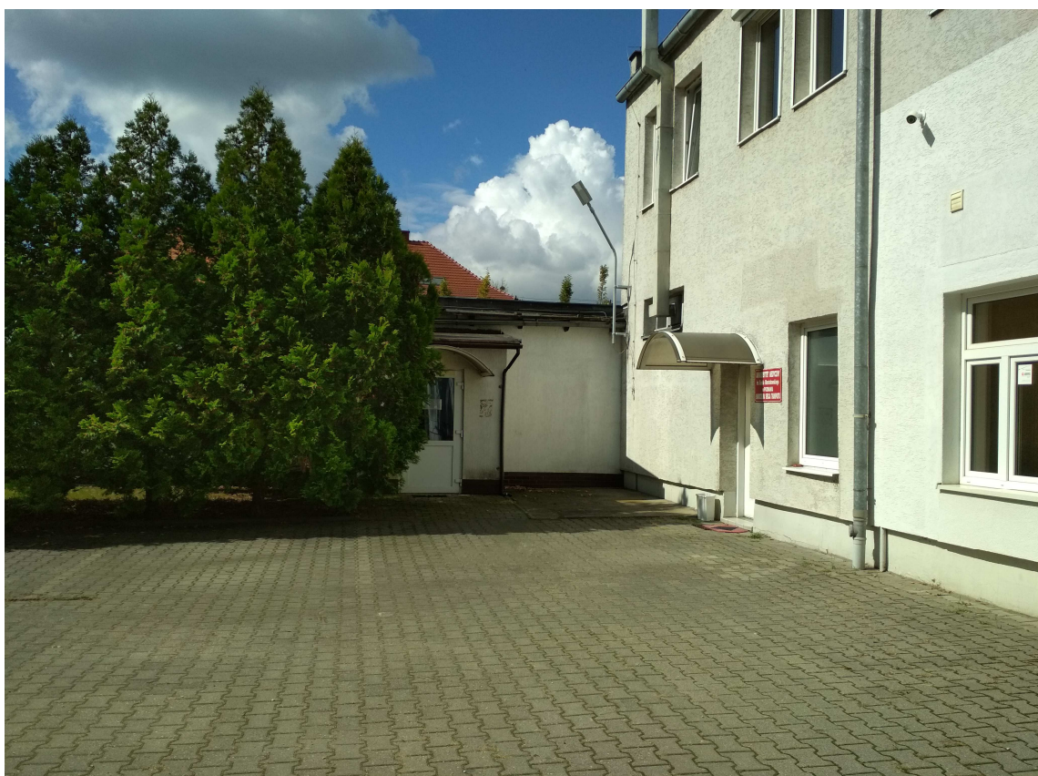
Fotografia nr 2: Widok na ścianę zachodnią (niższą) przewidzianą pod montaż drabiny nr 1 (we wnęce)
