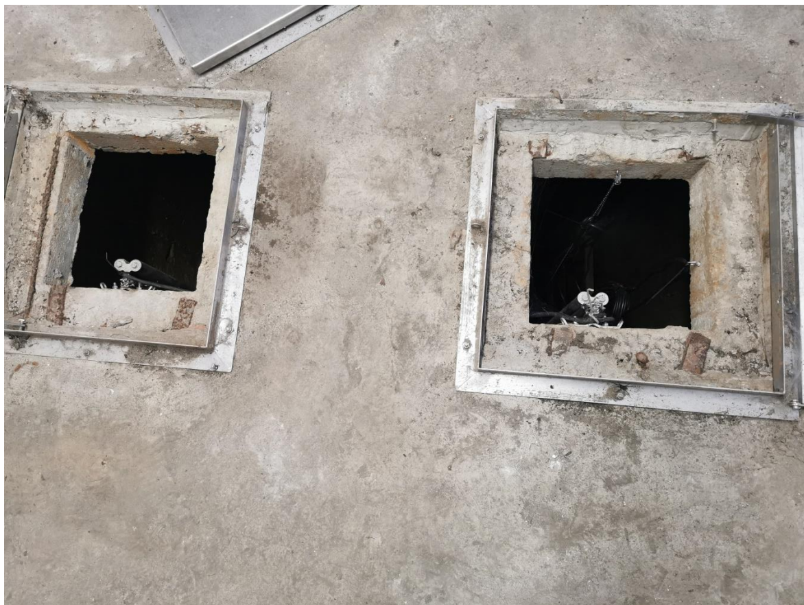
Rysunek 4. Włazy rewizyjne stan istniejący
