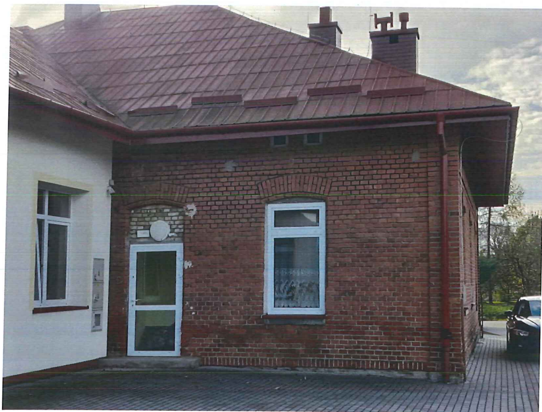
Zdjęcie nr 5. Elewacja pół-wsch. Wejście do budynku od strony podwórza.
