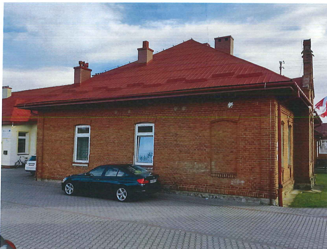
Zdjęcie nr 3. Elewacja półn-zach. (wątek ceglany ściany i kamienny cokołu, pokrycie z blachy na rąbek).
