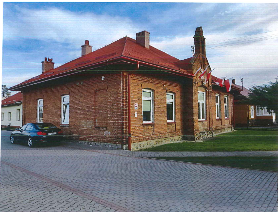
Zdjęcie nr 2. Widok budynku od strony zachodniej (wątek ceglany ściany i kamienny cokołu, pokrycie z blachy na rąbek).
