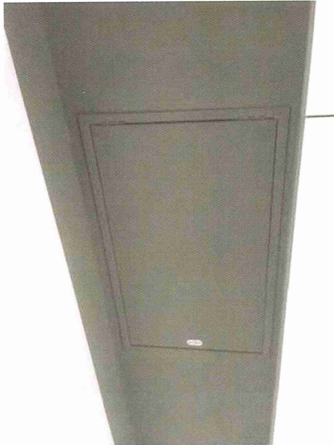
Fot. 9. Wyłaz na poddasze do czasowego demontażu
