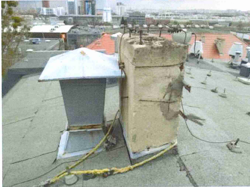
Fot. 2. Komin niski „wschodni”
