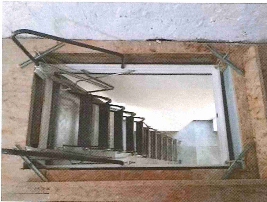
Fot. 7. Wyłaz na poddasze do czasowego demontażu
