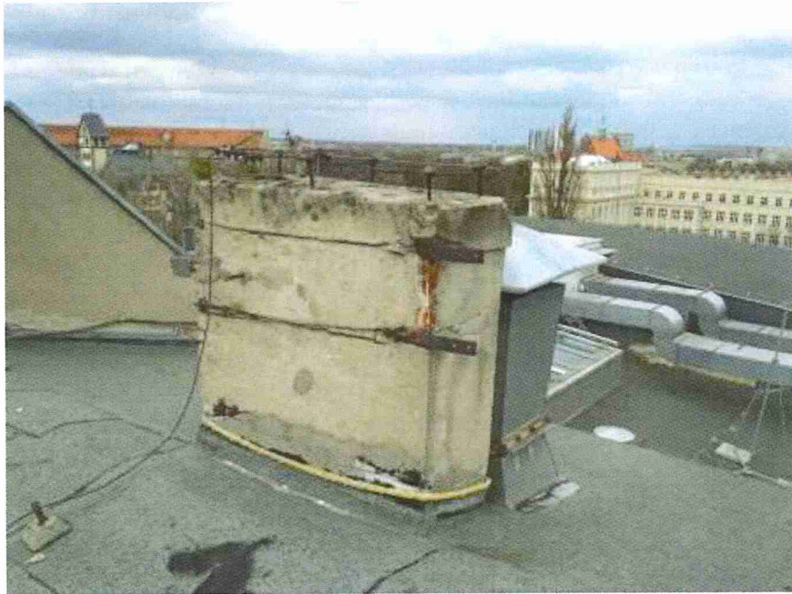
Fot. 1. Komin niski „wschodni”
