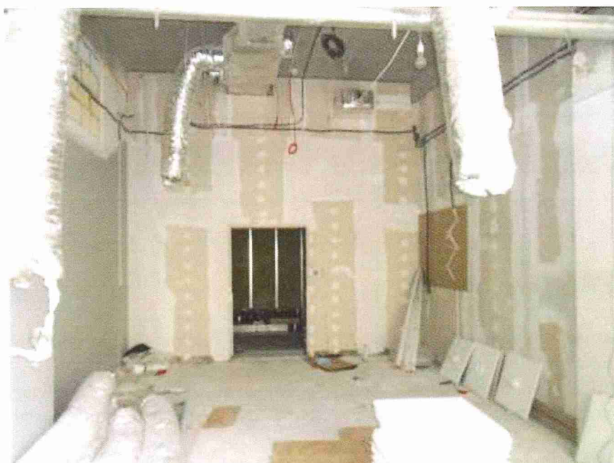
Fot. 2. Stan istniejący pomieszczenia
