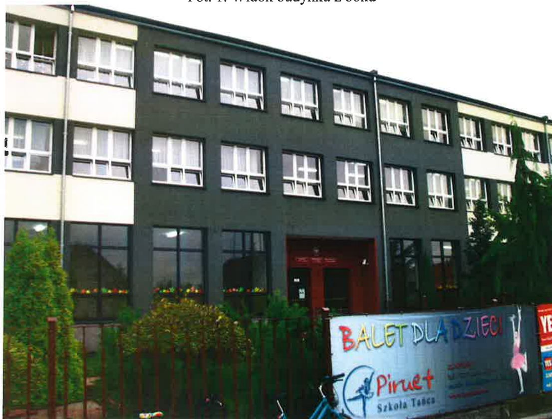
Fot. 2. Widok budynku od frontu
