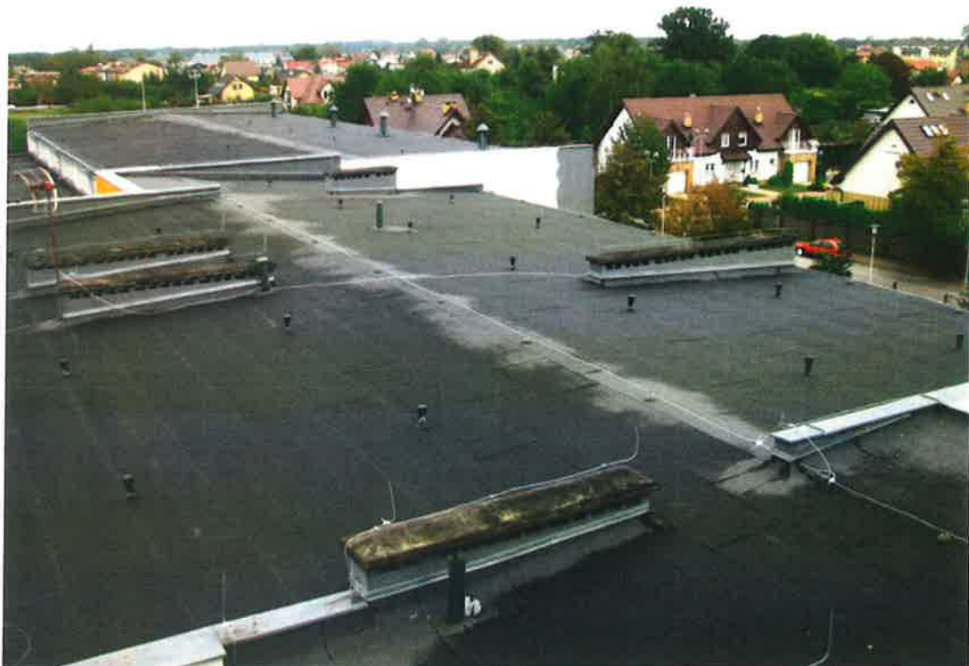
Fot. 5. Widok na dach budynku C
