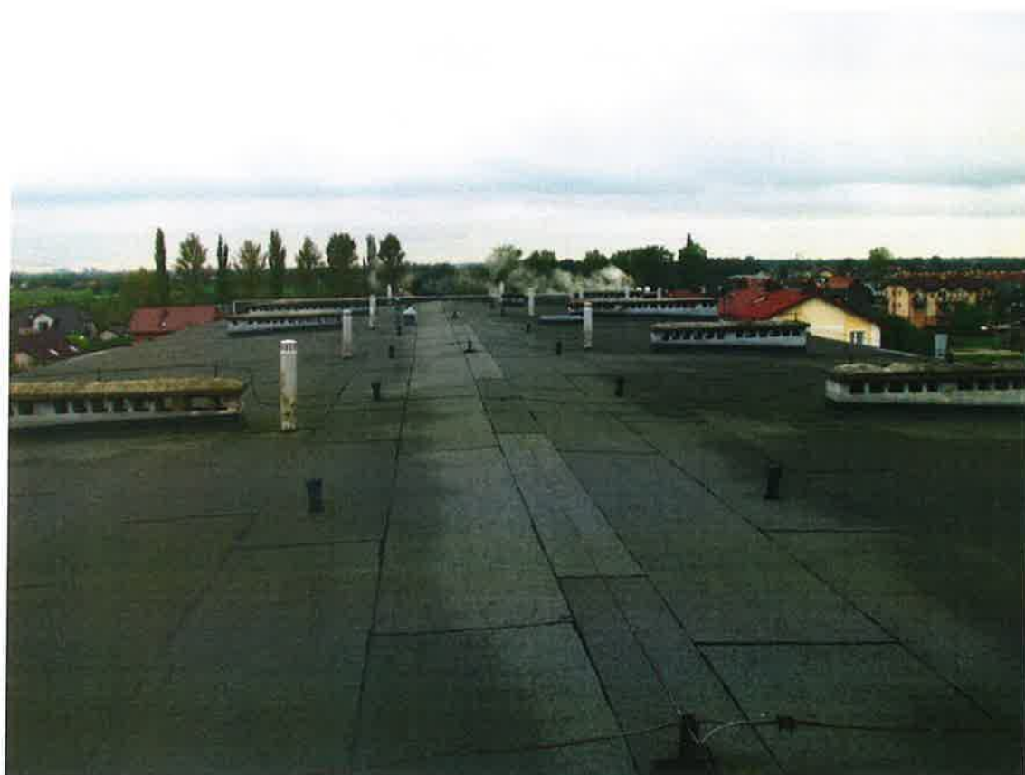
Fot. 6. Widok na dach budynku B
