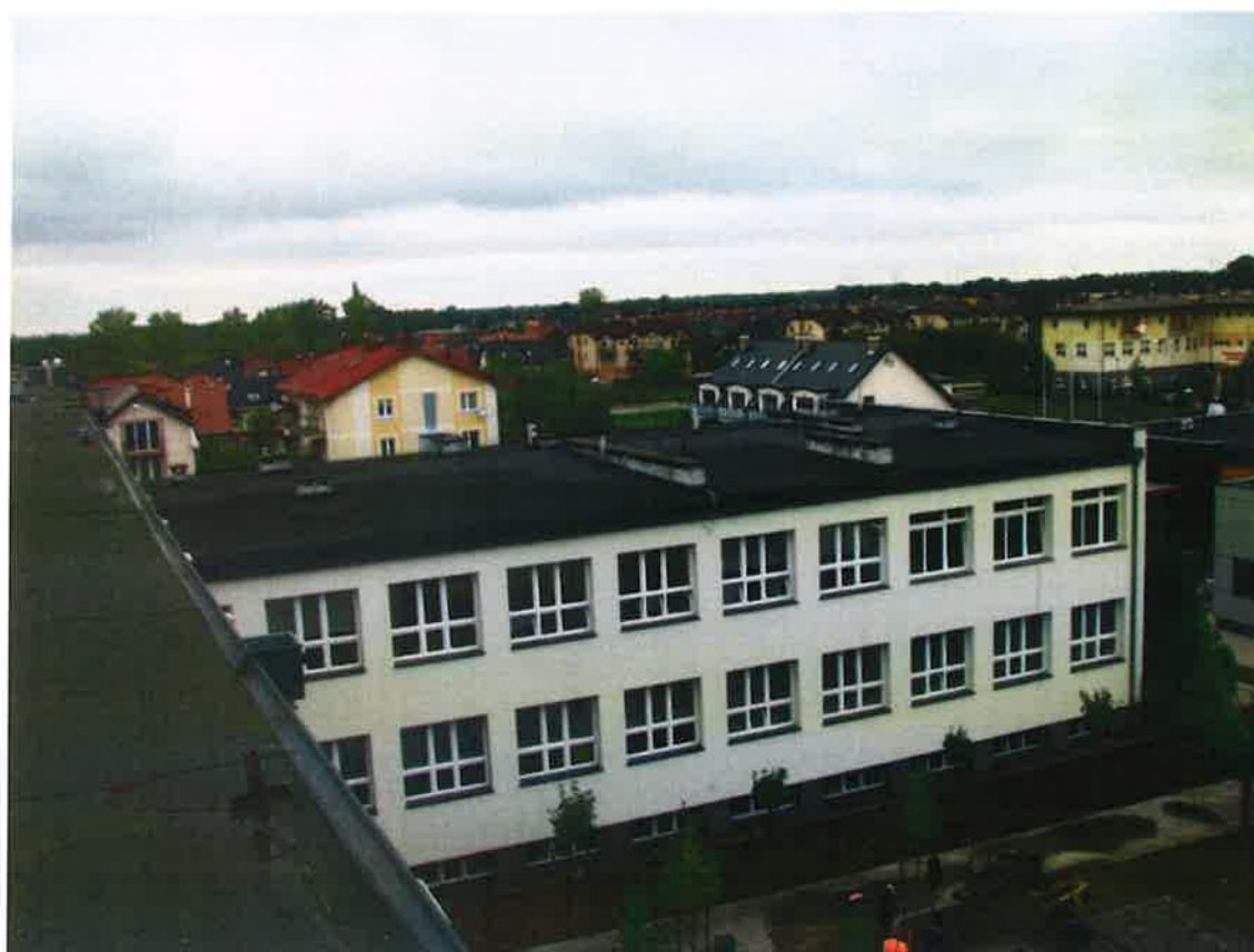
Fot. 4. Widok na dach budynku A
