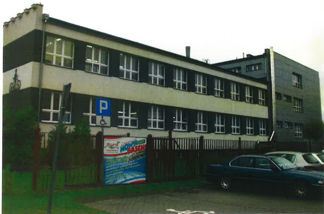
Fot. 1. Widok budynku z boku
