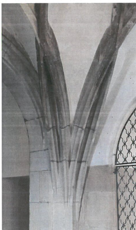
Fot. 3 Elementy żeber - uzupełnienie spionowania
