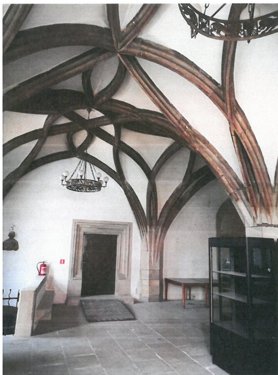
Fot.1 Żebra na sklepieniu sieciowym z widocznymi zanieczyszczeniami
