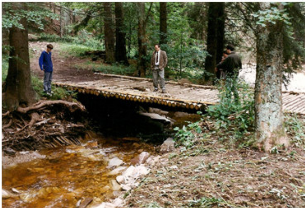
Mostek ocalały w stanie nienaruszonym po przejściu fali powodziowej o metr nad nim w 1997 roku – Nadleśnictwo Zdroje. Fot. B. Noga. Źródło: Archiwum CKPŚ.
