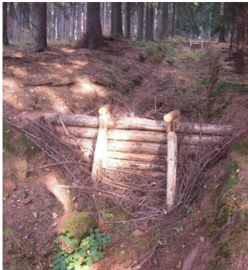
Przegrody drewniane wypełnione gałęziówką na szlakach zrywkowych (N-ctwo Jugów, RDLP Wrocław)
