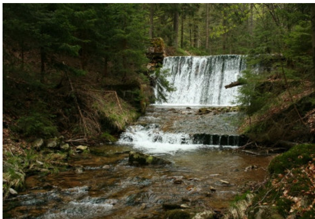
Całkowicie wypełniona zapora na cieku z potencjałem siedliskowym dla ryb – Nadleśnictwo Łądek Zdrój. Źródło: Archiwum CKPŚ.
