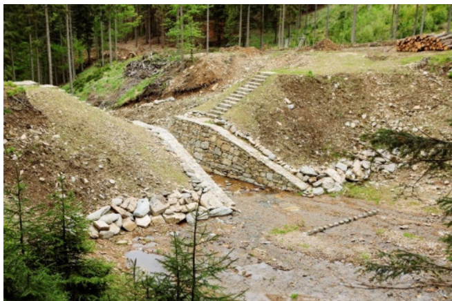
Widok na zaporę czołową dawnego zbiornika na ciek do spławu drewna przerobionego na zbiornik przeciwpowodziowy – Nadleśnictwo Międzylesie. Źródło: Archiwum CKPŚ. (rys. na górze)
