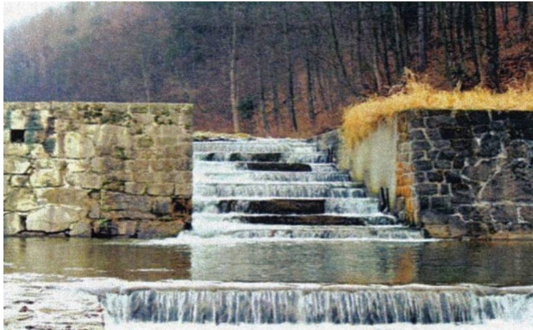
Przepławka wykonana w zaporze przeciwrumowiskowej na potoku Wirchomla. Źródło: Archiwum CKPŚ.
