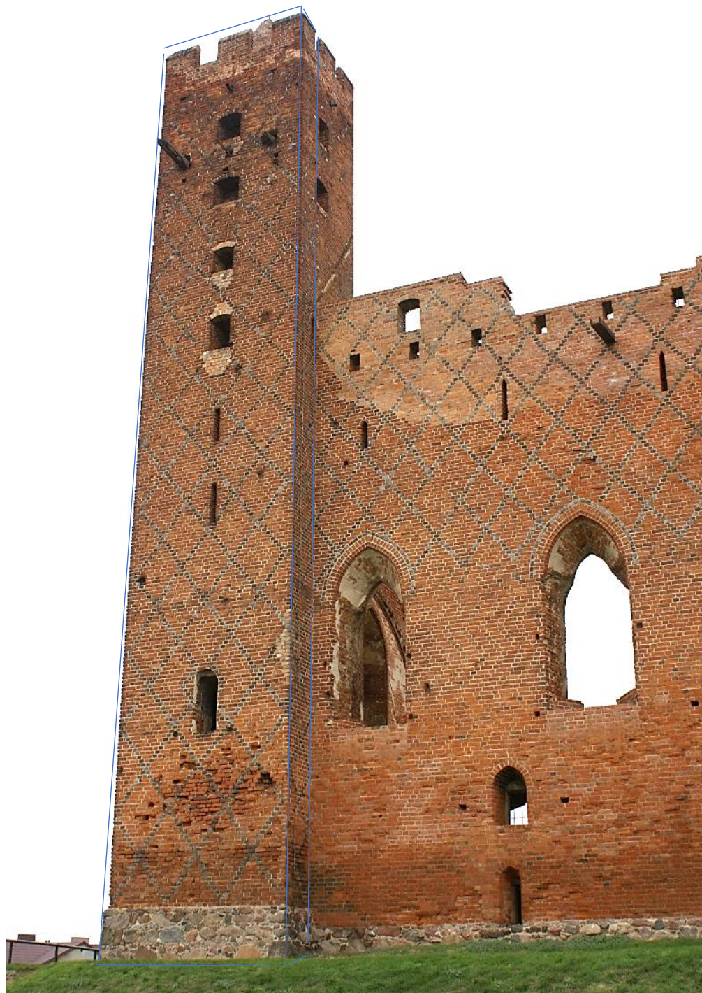
Fot. 1 Elewacja południowa wieży pd-zach zamku z narożnikiem elewacji wsch. wieży.- Zakres VIII Etapu prac konserwatorskich , Fot . i Opr. R Gazda '2021
