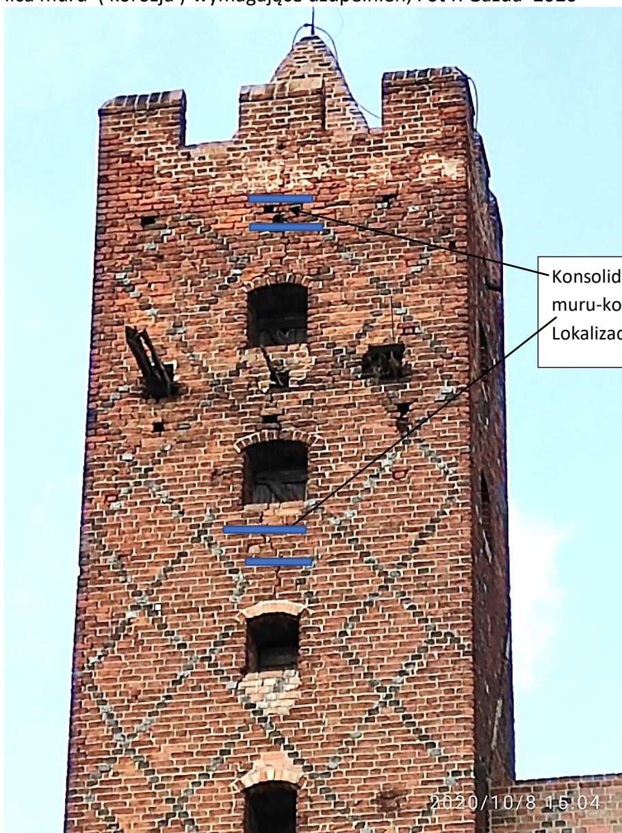
Fot. 2 Elewacja południowa wieży Zamku w Radzynie Chełmińskim widoczne głębokie ubytki lica muru ( korozja )-wymagające uzupełnień, Fot R Gazda '2020
