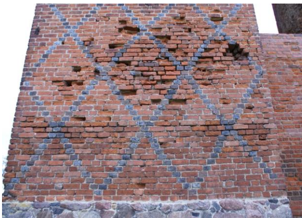
Fot. 2 Elewacja południowa wieży Zamku w Radzynie Chełmińskim widoczne głębokie ubytki lica muru ( korozja )-wymagające uzupełnień, Fot R Gazda '2020
