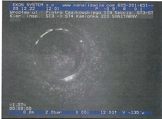
ST3-ST4-foto_nr-112.jpg, 00:00:00, 0.00 m Węzeł początkowy. Studzienka włączowa, ST3
