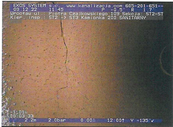
ST2-ST3-foto_nr-099.jpg, 00:03:18, 2.23 m Złamanie obwodowe - wyraźne otwarcie ścian przewodu, fragmenty obecne na swoim miejscu, szer.: 1mm od 12 godz. do 12 godz.
