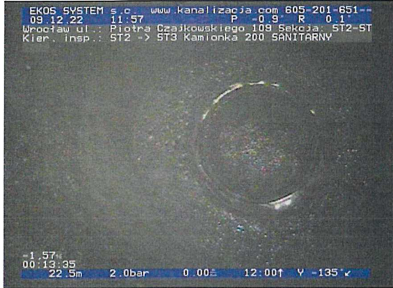
ST2-ST3-foto_nr-111.jpg, 00:13:35, 22.51 m Węzeł końcowy. Studzienka wiazowa, ST3
