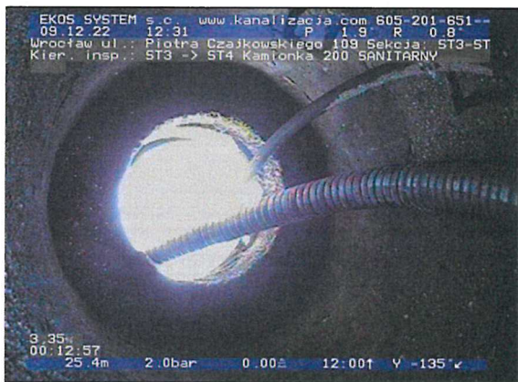
ST3-ST4-foto_nr-130.jpg, 00:12:57, 25.43 m Węzeł końcowy. Studzienka wiazowa, ST4
