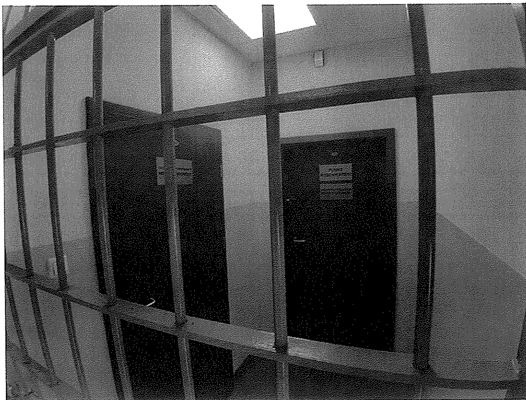
Budynek nr 112 – korytarz oś „T” rusznikarnia
