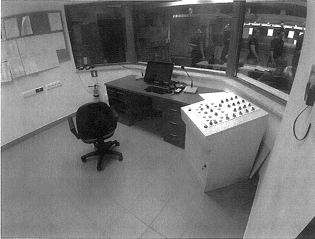
Budynek nr 112 – sterownia osi strzeleckiej
