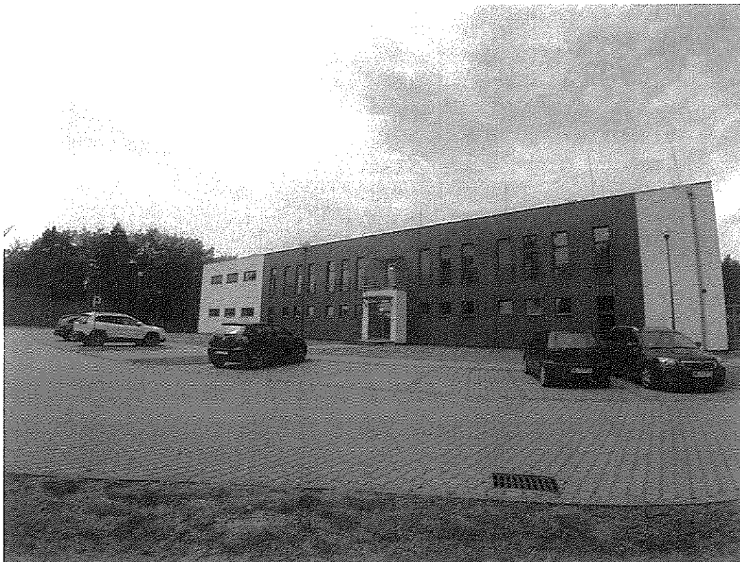
Budynek nr 112 – teren
