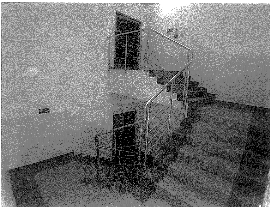
Budynek nr 112 – klatka schodowa oś „T” część administracyjna
