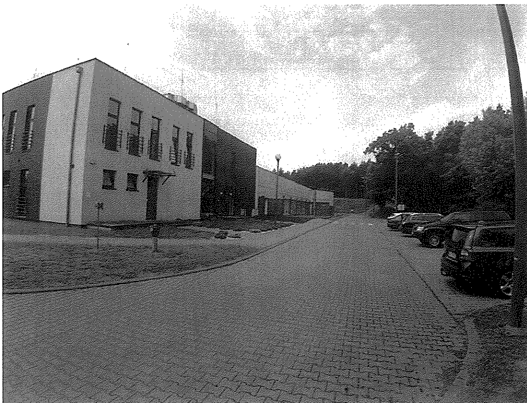
Budynek nr 112 – teren
