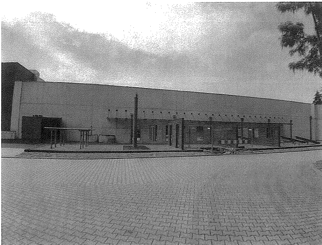
Budynek nr 112 – strefa treningu bezstrzałowego
