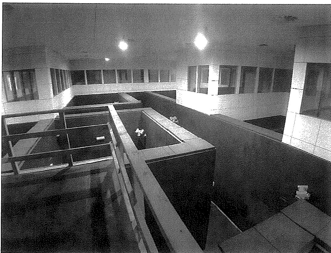
Budynek nr 112 – taras oś „T”
