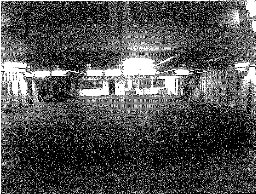
Budynek nr 112 – oś „C”
