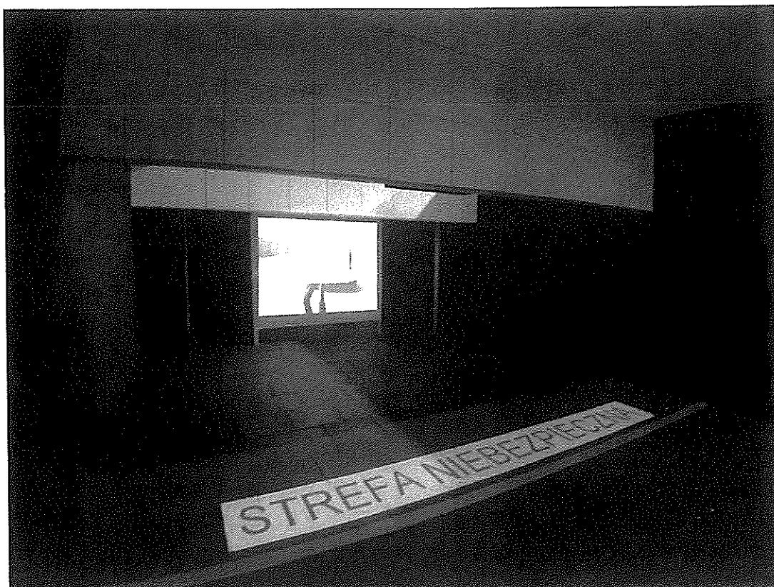
Budynek nr 112 – oś „W”
