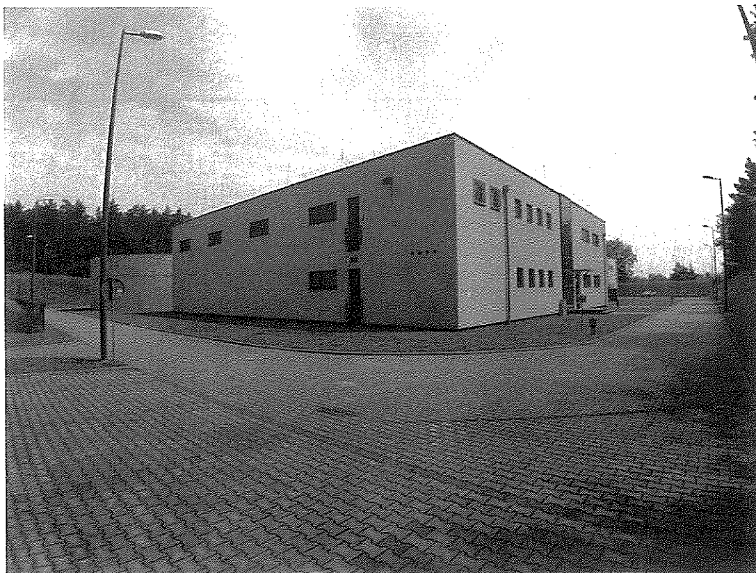
Budynek nr 112 – teren
