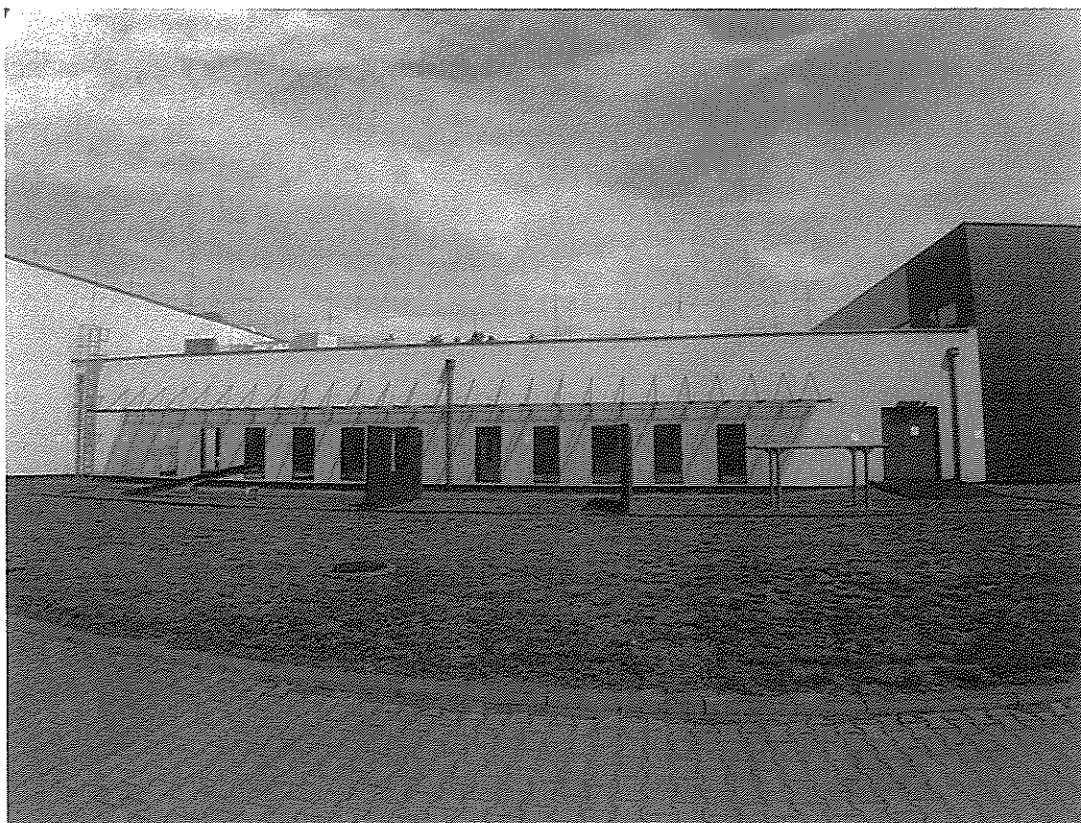
Budynek nr 112 – strefa treningu bezstrzałowego
