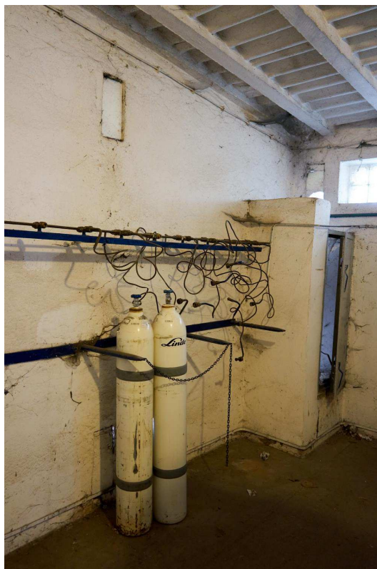
Zdjęcie 5 Pomieszczenie rozdzielni tlenu
