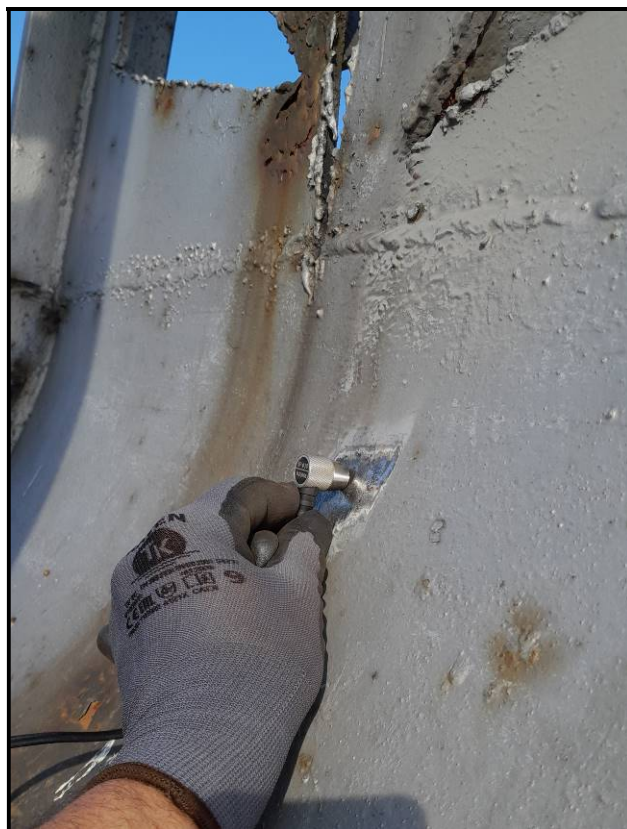
Fot.15 Badania grubości stali grubościomierzem ultradźwiękowym w miejscu referencyjnym na ścianie pionowej kłosa nr 1
