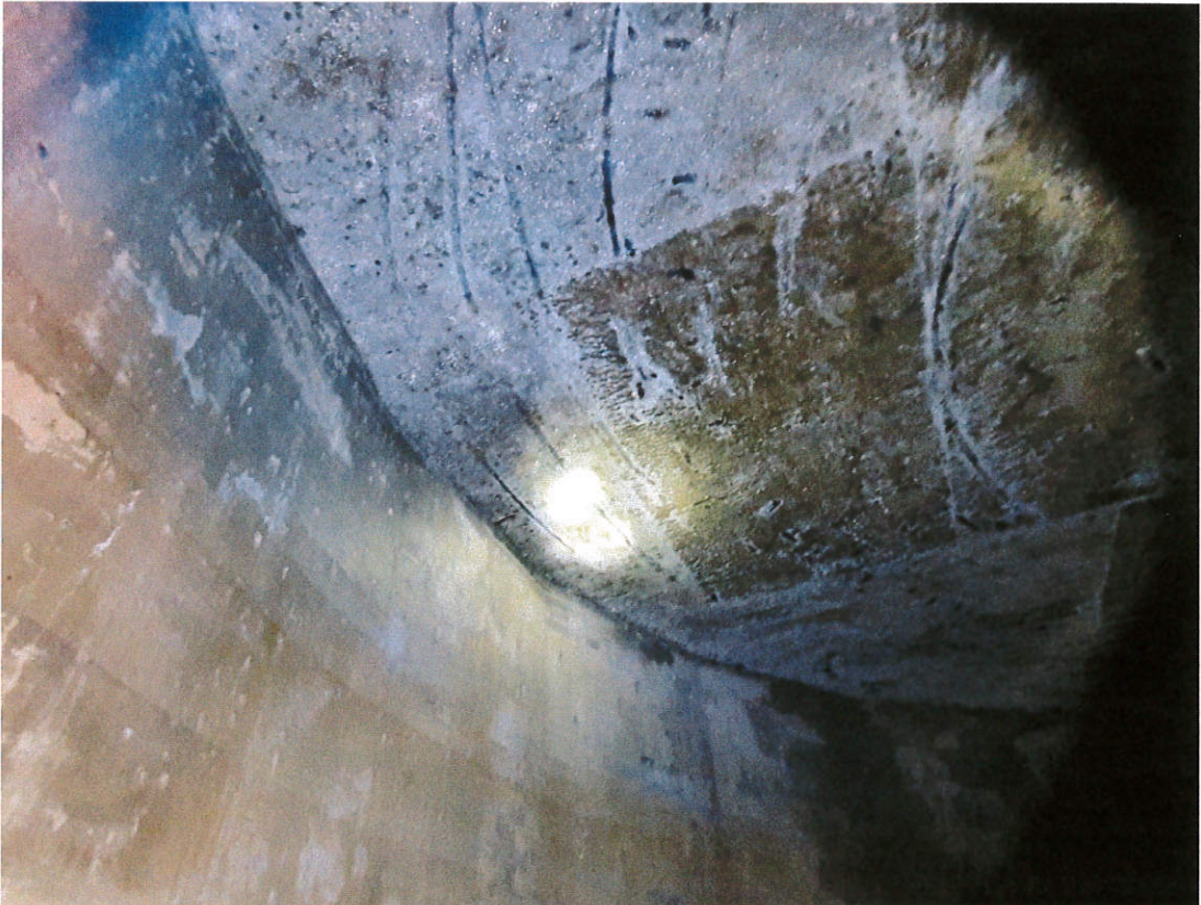
Zdjęcie 3. Płyta stropowa – widoczne zbrojenie
