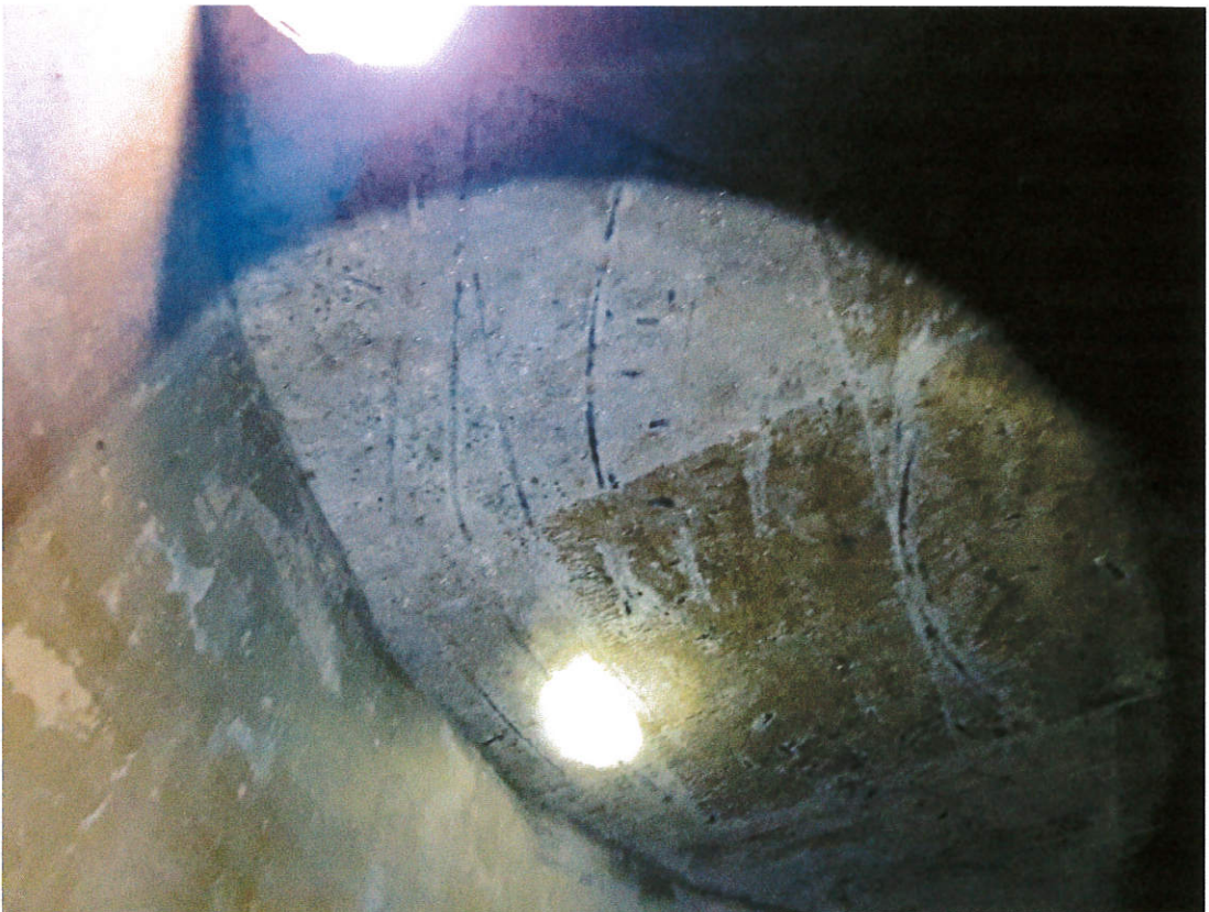
Zdjęcie 4. Płyta stropowa – widoczne zbrojenie
