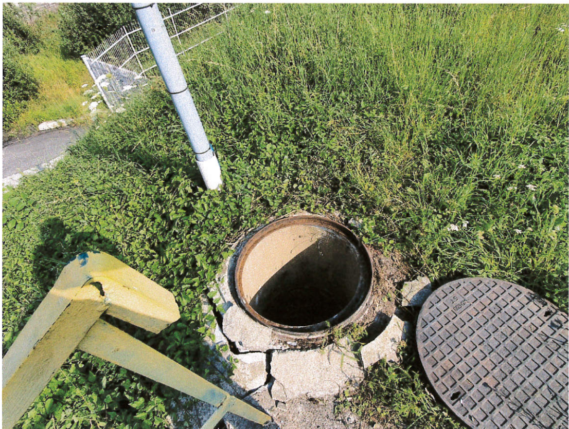
Zdjęcie 2. Właz do zbiornika
