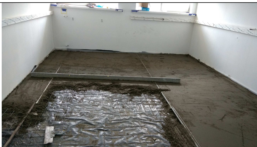
Fot. 2. Fotografia miejsca odkrytki. Widoczne zbrojenie stropu grzejnego. Pręt równoległe do żeber średnicy 6mm, prostopadłe – 4,5mm. Płyta sufitu grzejnego gr. 5cm otynkowana. Pustak stropu Ackermana 18cm.
