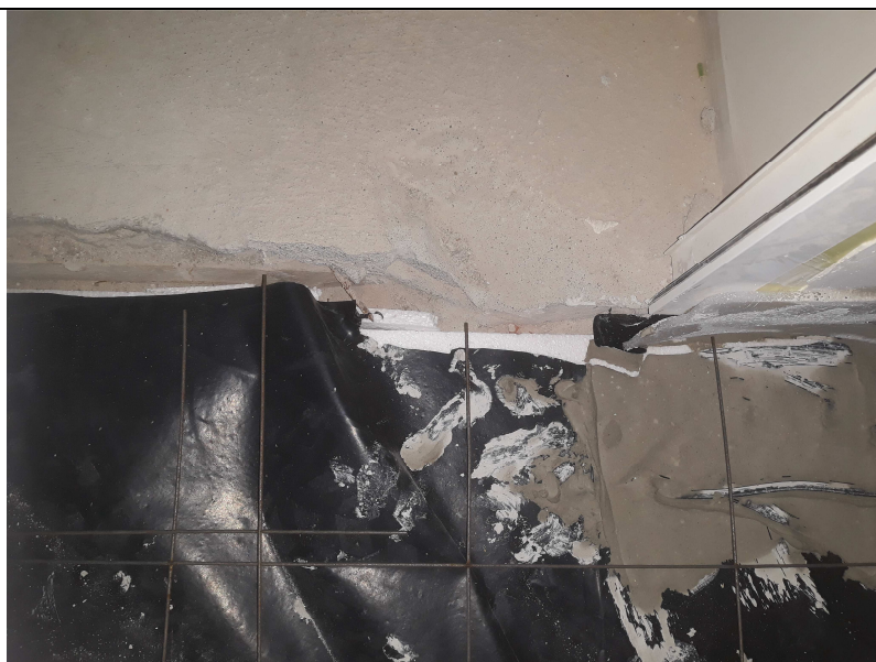
Fot. 3. Fotografie archiwalne z okresu remontu . Widoczne warstwy posadzkowe na przykładzie w pomieszczenia nr 108D.
