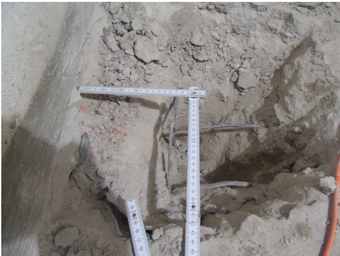
Fot.OŁ1. Widok odkrywki styku ławy fundamentowej pod ścianą pośrednią z widoczną dolewką posadzkową gr. 30+10cm. Odsadzka fundamentowa ok. 15,5cm od lica otynkowanego muru.
