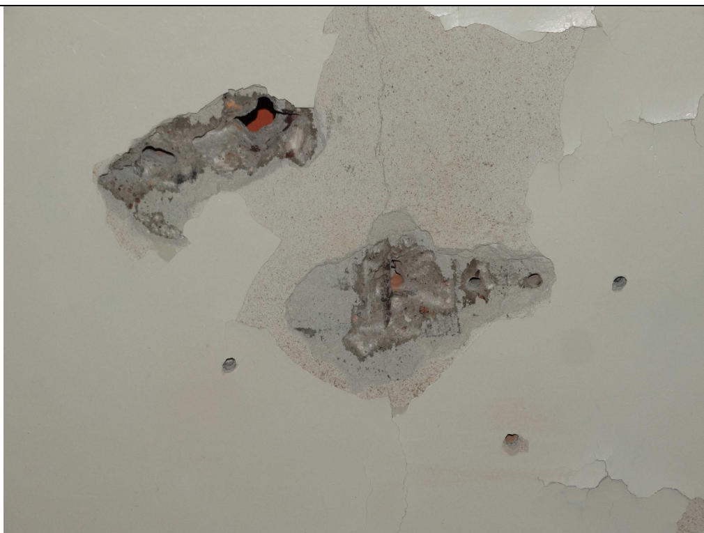
Fot. 2. Fotografia miejsca odkrytki. Widoczne zbrojenie stropu grzejnego. Pręt równoległe do żeber średnicy 6mm, prostopadłe – 4,5mm. Płyta sufitu grzejnego gr. 5cm otynkowana. Pustak stropu Ackermana 18cm.
