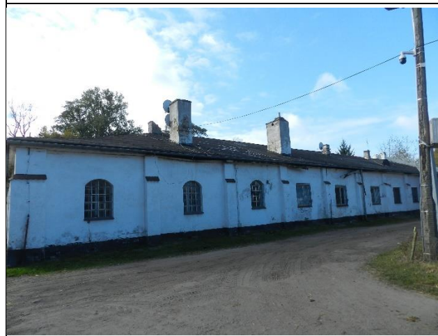
Fot. 04. Widok ogólny budynku elewacja północna.
