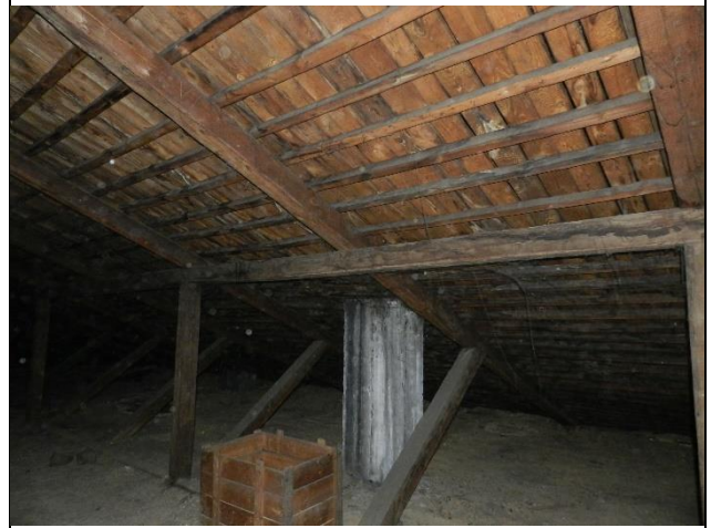
Fot. 14. Widok więźby dachowej połać południowa.
