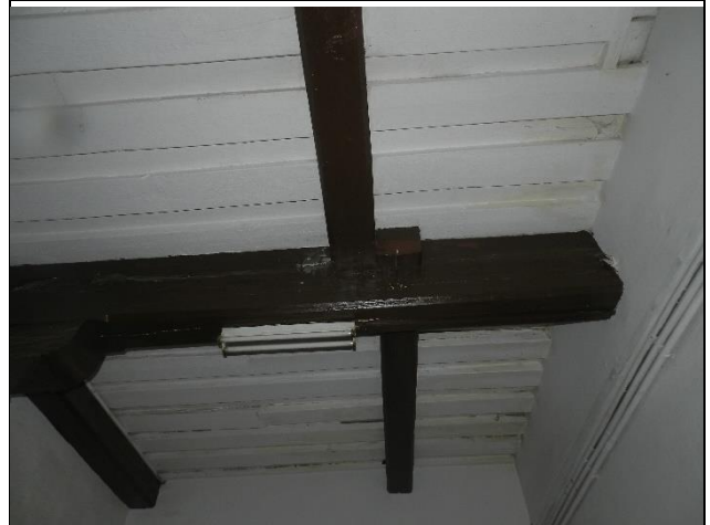
Fot. 28. Widok belek stropowych wewnątrz budynku.
