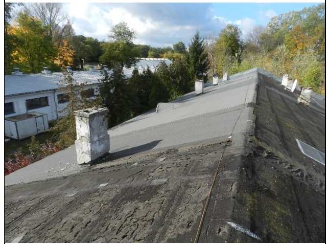
Fot. 08. Widok pokrycia dachowego na połaci południowej.
