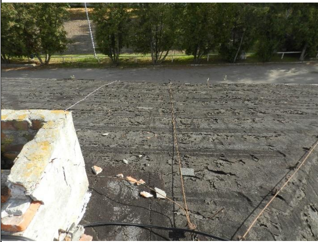
Fot. 07. Widok pokrycia dachowego na połaci wschodniej.
