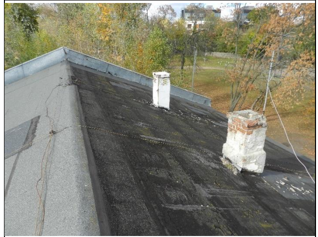
Fot. 12. Widok uszkodzonych kominów nr3.
