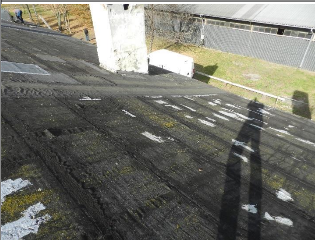
Fot.09. Widok pokrycia dachowego na połaci północnej.
