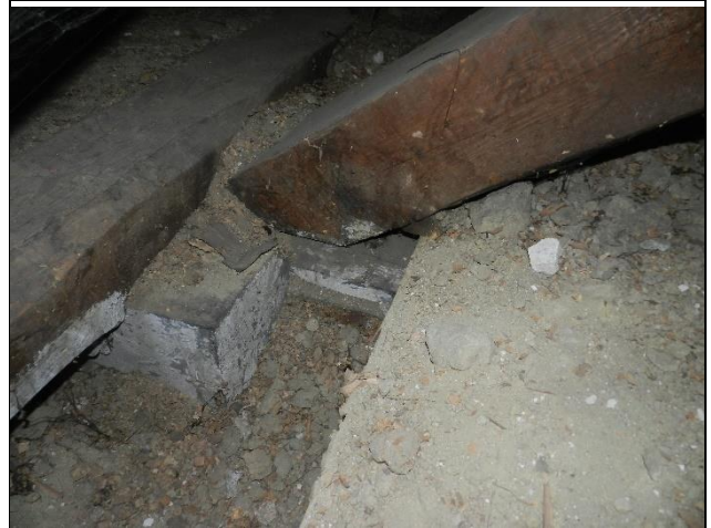
Fot. 24. Widok oparcia zastrzału na stropie.
