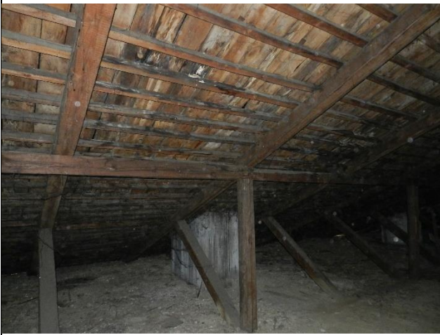
Fot. 13. Widok więźby dachowej połać północna.
