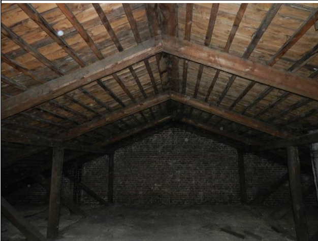
Fot. 15. Widok połaci południowej oraz północnej (od strony zachodniej budynku).
