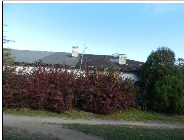
Fot. 02. Widok ogólny budynku elewacja południowa nr1.
