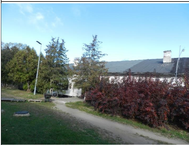
Fot. 03. Widok ogólny budynku elewacja południowa nr2.
