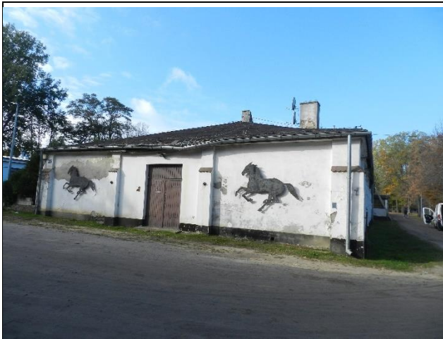
Fot. 01. Widok ogólny budynku elewacja wschodnia.
