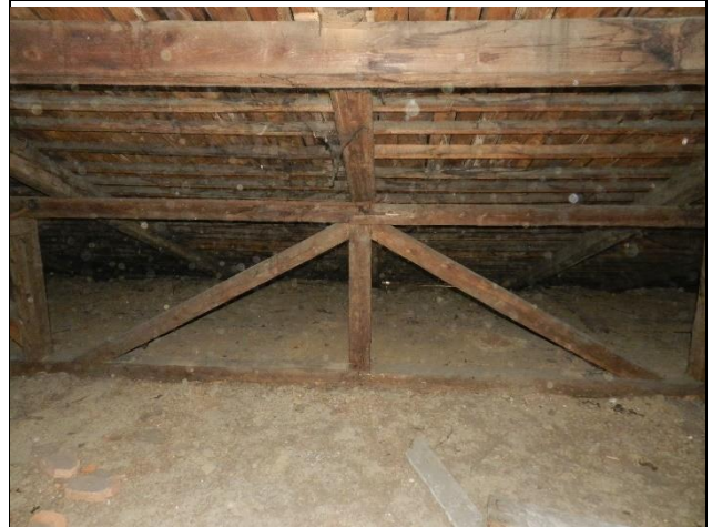
Fot. 16. Widok więźby dachowej połać wschodnia.
