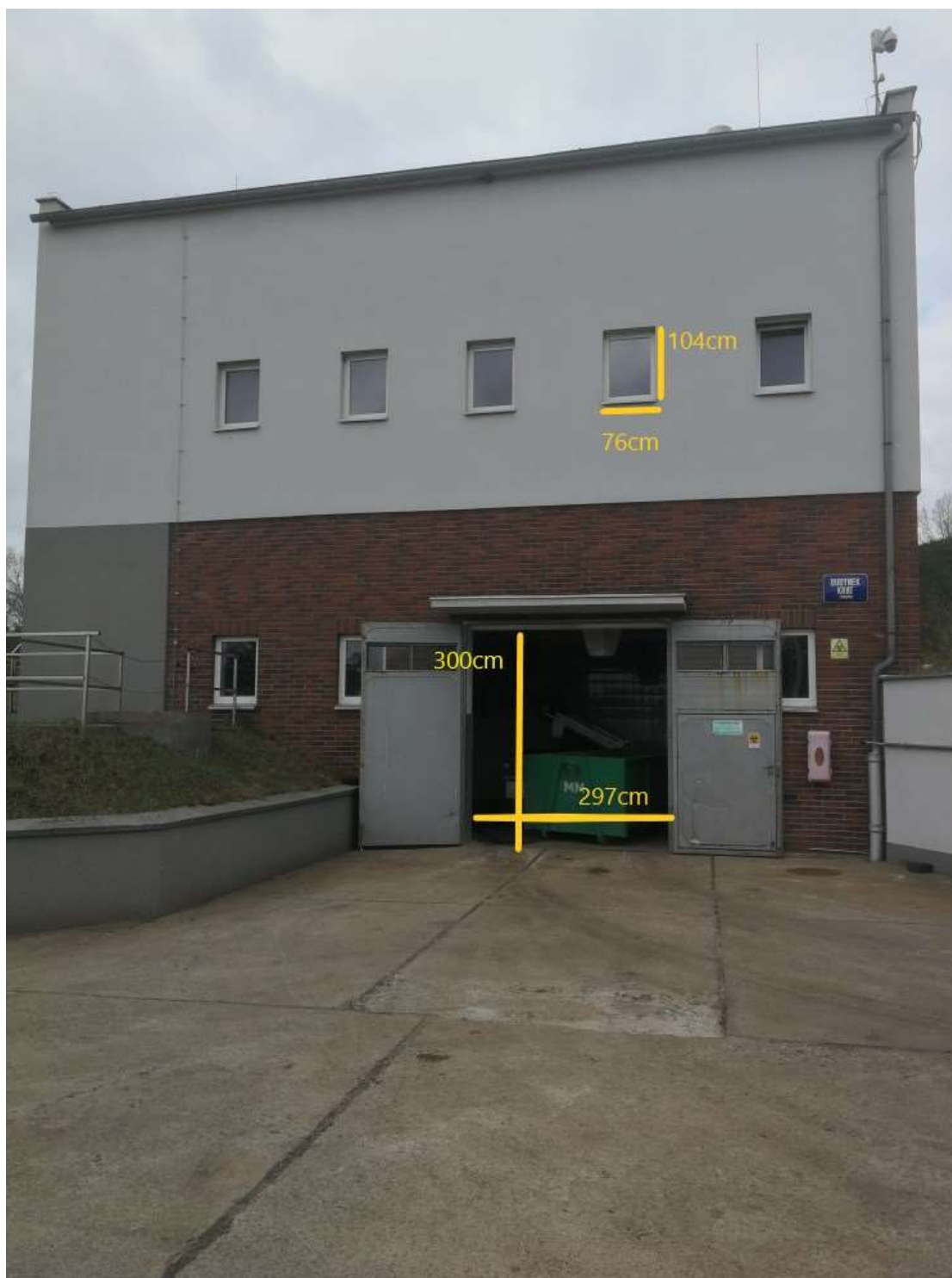
Budynek krat front
