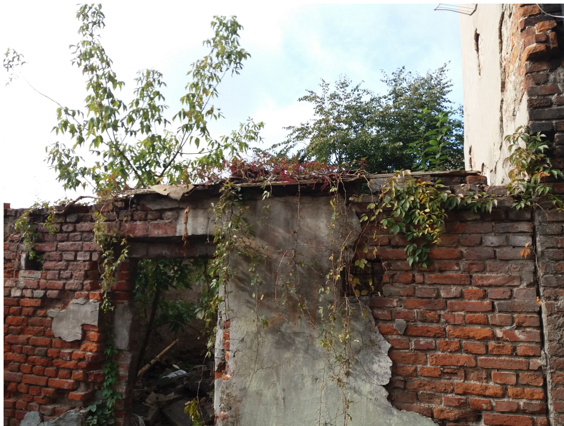
Zdjęcie nr 3: Budynek gospodarczy, elewacja frontowa, część prawa – widok zniszczonego dachu oraz linii przylegania ścian sąsiadujących obiektów
