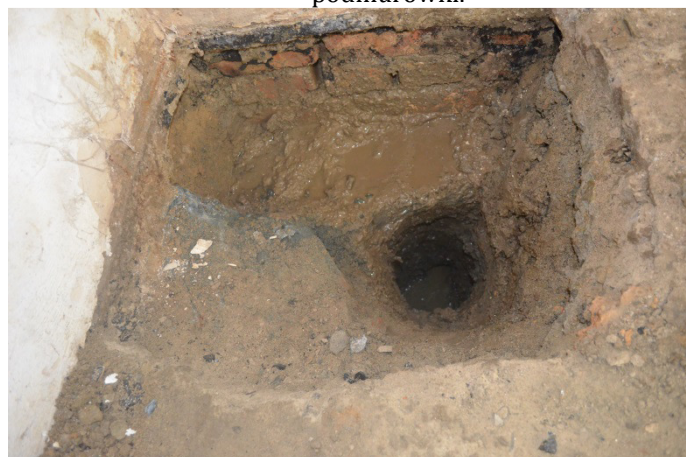
Fot. 5 – Odkrywka w garażu
