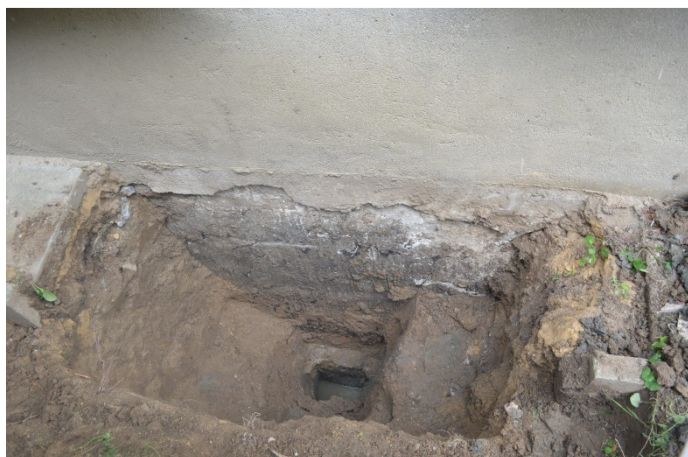
Fot. 4 – Odkrywka na zewnątrz budynku
