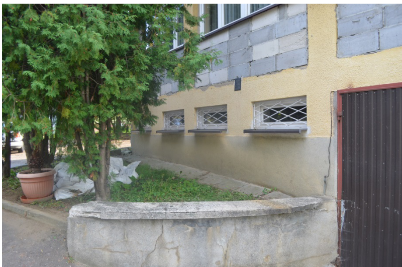
Fot. 2 – Miejsce wykonania odkrywki na zewnątrz budynku
