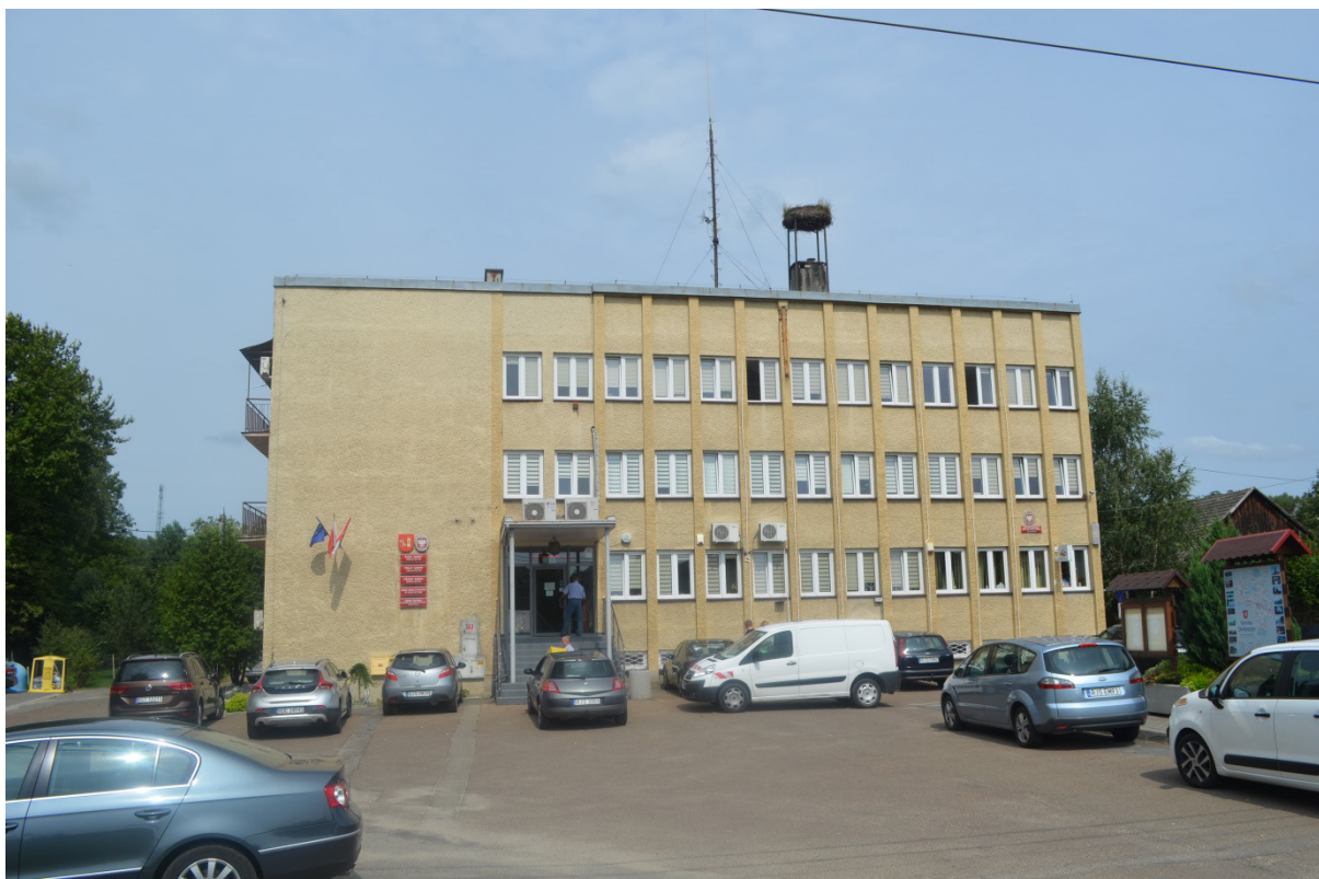
Fot. 1 – Widok na analizowany budynek (elewacja frontowa)
