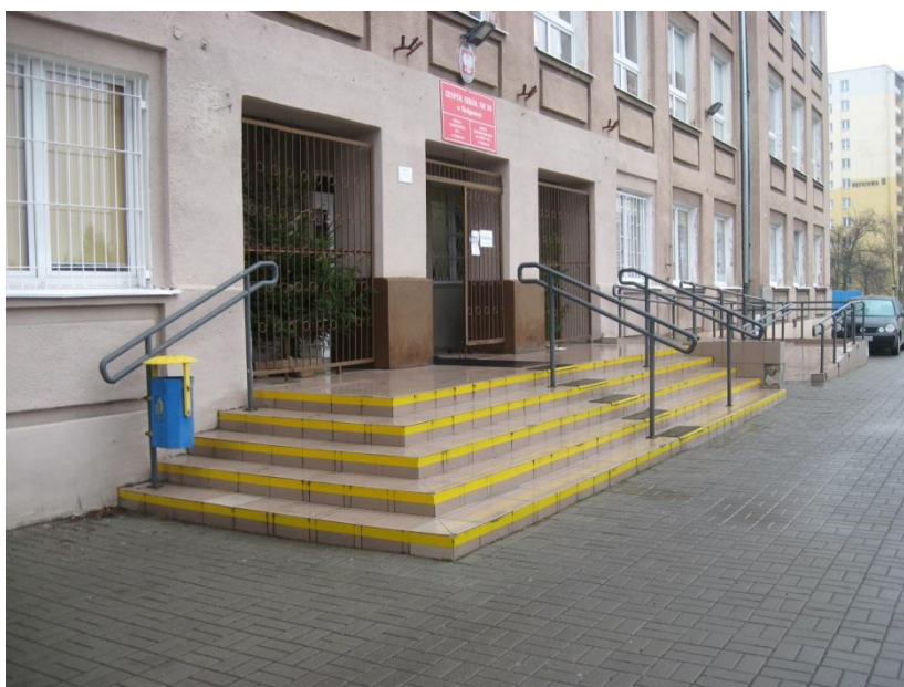
widok wejścia głównego do szkoły objęty projektem przebudowy
