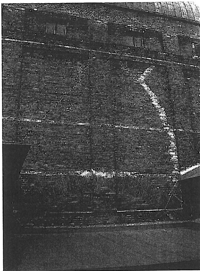
Rys. 14. Widok przemurowań rys ścian komina scenicznego
