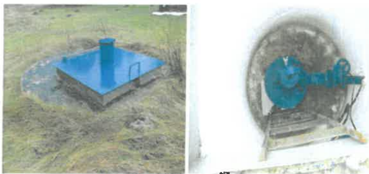
Zdjęcie nr 2 i 3. Obudowa studni SW-1.
