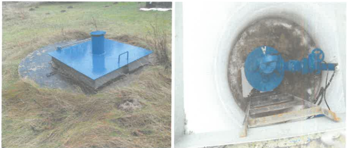
Zdj. nr 2 i 3. Obudowa studni SW-1.
