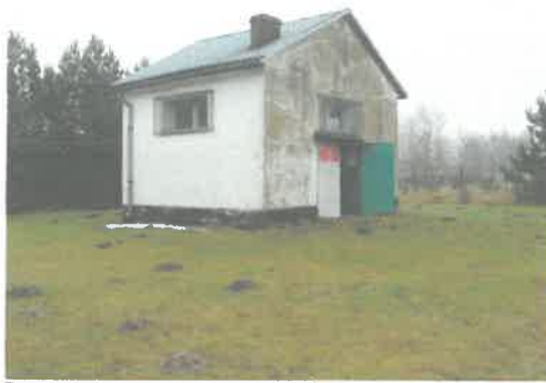
Zdj. nr 6. Budynek hydroforni.
