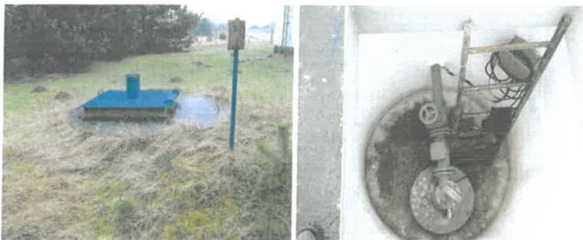
Zdjęcie nr 4 i 5. Obudowa studni SW-2.
