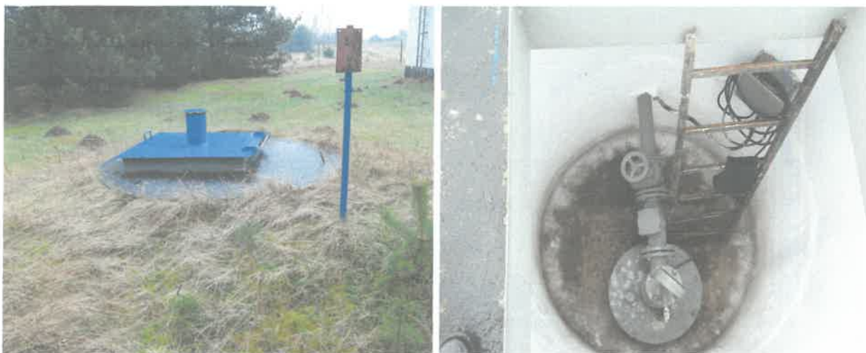
Zdj. nr 4 i 5. Obudowa studni SW-2.
