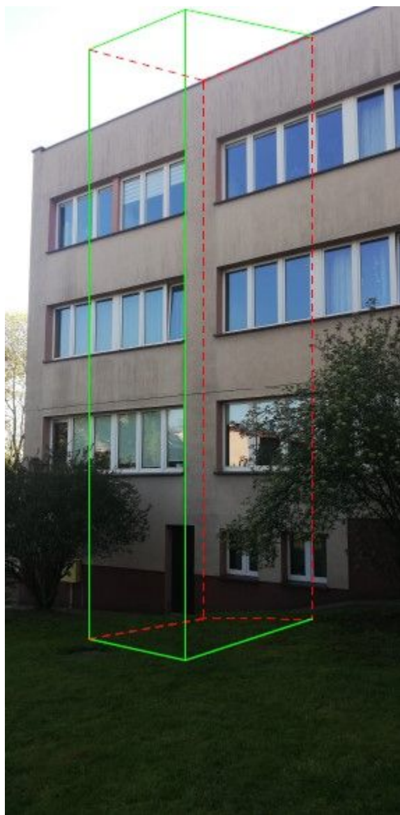
Rys. nr 7 Wizualizacja lokalizacji szybu windy zewnętrznej w budynku Starostwa Powiatowego przy ul. Sienkiewicza 27 w Miechowie
