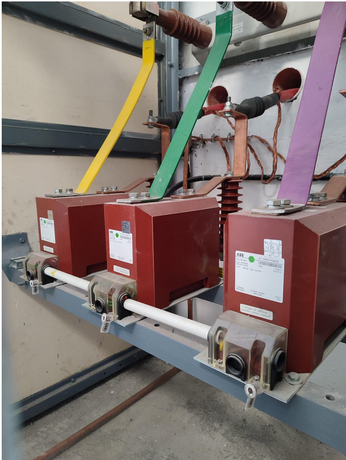
Przekładniki prądowe, w tle odejście do transformatora
