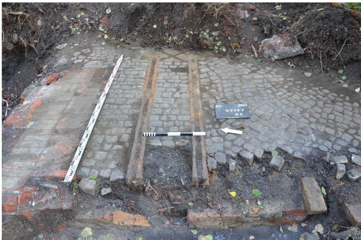
21. Widok na konstrukcję torowiska z reliktem brukowania granitowego i włazem studni kanalizacyjnej [K2]
