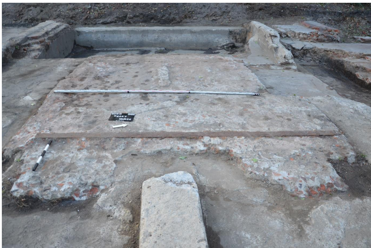
24. Widok na konstrukcję beton-rumosz ceglany – stal podstawa konstrukcji przemysłowej [K34]
