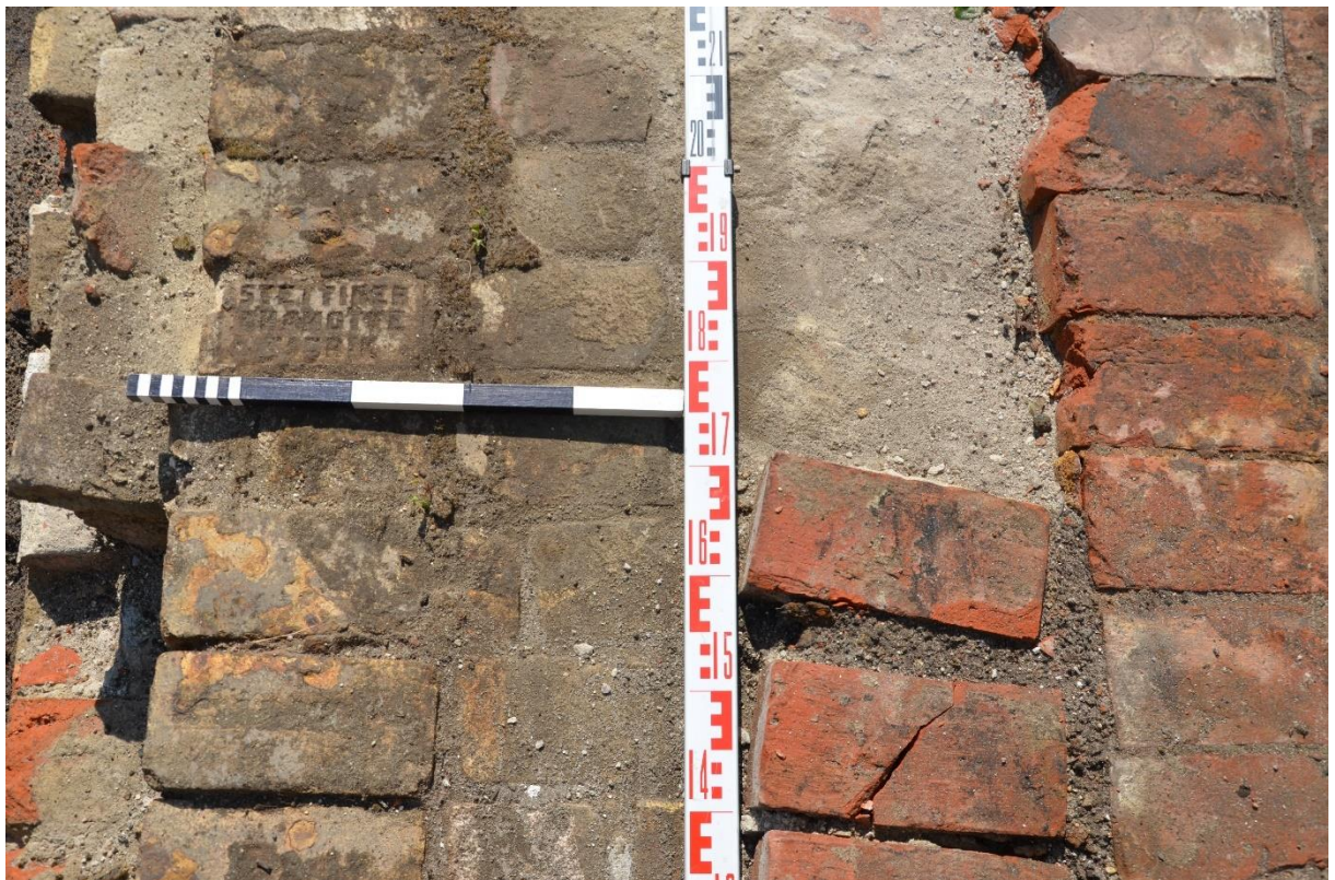
18. Detal cegły [M18]: STETTINER CHAMOTTE FABRIK
