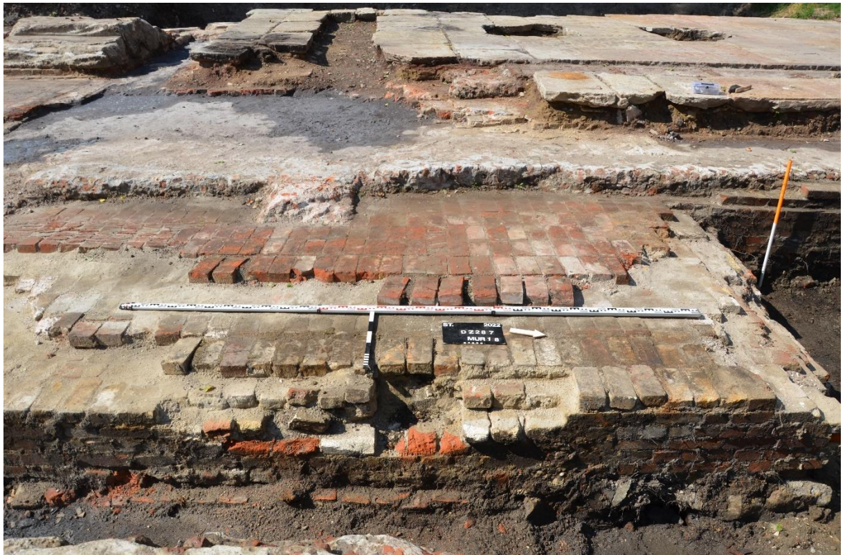
17. Konstrukcja fundamentowa, ceglana M18 – główna podstawa bryły budynku
