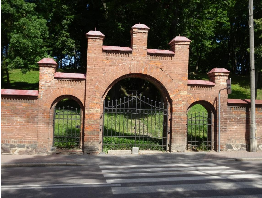
Fot. 15. Elewacja od strony ul. Armii Krajowej – brama wejściowa na cmentarz.
