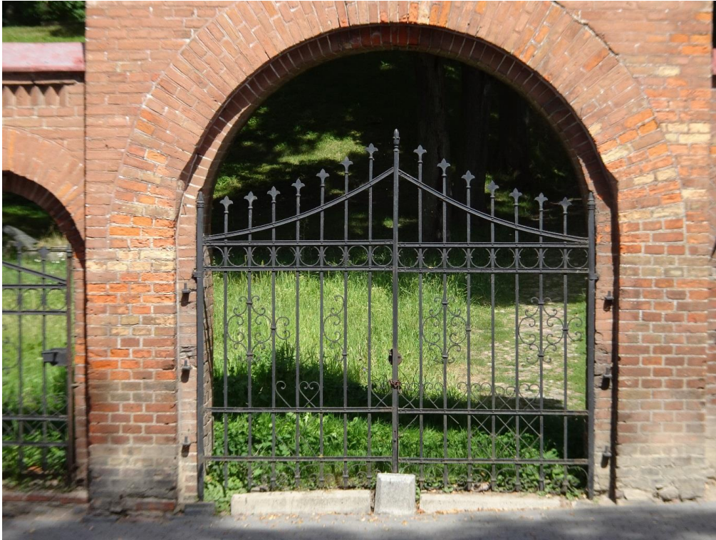
Fot. 39. Elewacja od strony zewnętrznej – kuta brama oraz fragmenty mocowania bramy.
