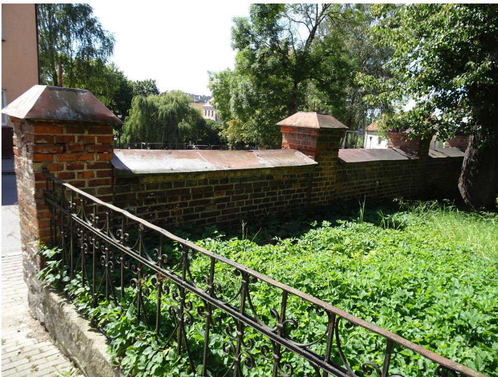
Fot. 20. Widok na mur od strony wewnętrznej.
