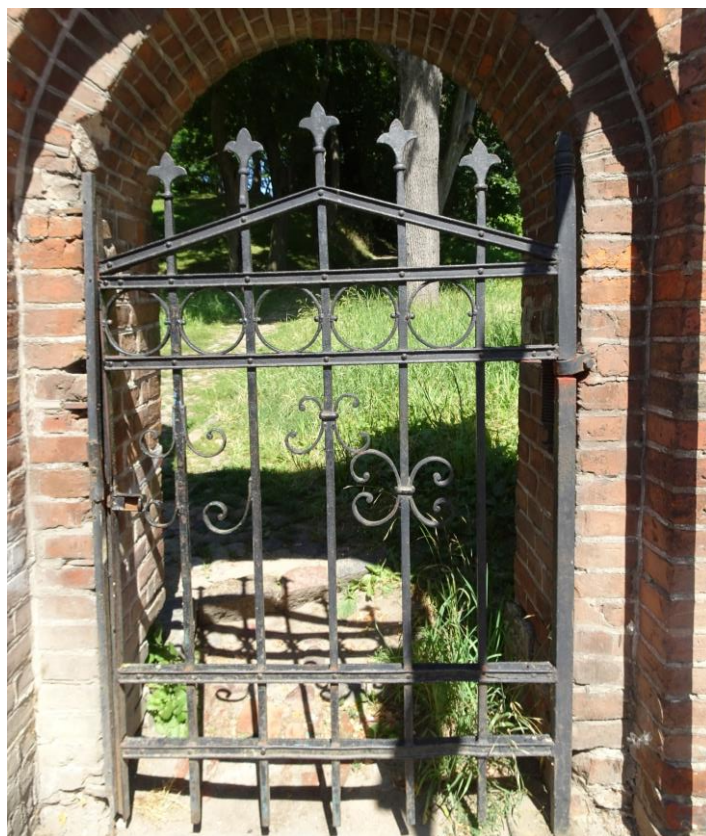
Fot. 41. Elewacja od strony zewnętrznej – kuta furтка (prawa).
