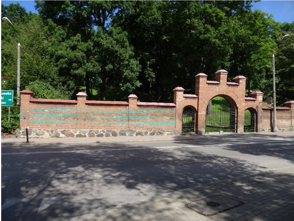
Fot. 1. Ogrodzenie cmentarza. Część zachodnia – elewacja frontowa. Na niebiesko zaznaczone pasy żółtej cegły.
