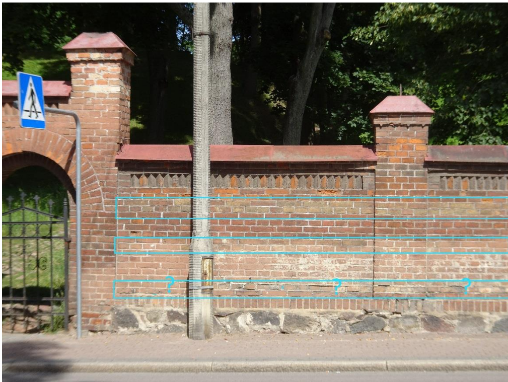
Fot. 2. Ogrodzenie cmentarza. Część wschodnia – elewacja frontowa. Na niebiesko zaznaczone pasy żółtej cegły.
