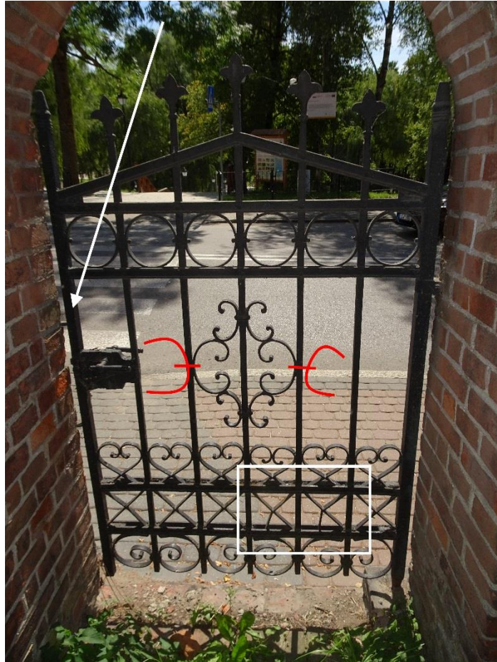
Fot. 7. Ogródzenie cmentarza – furtka lewa. Zaznaczone miejsca ubytków ażurowej dekoracji wypełniającej.
