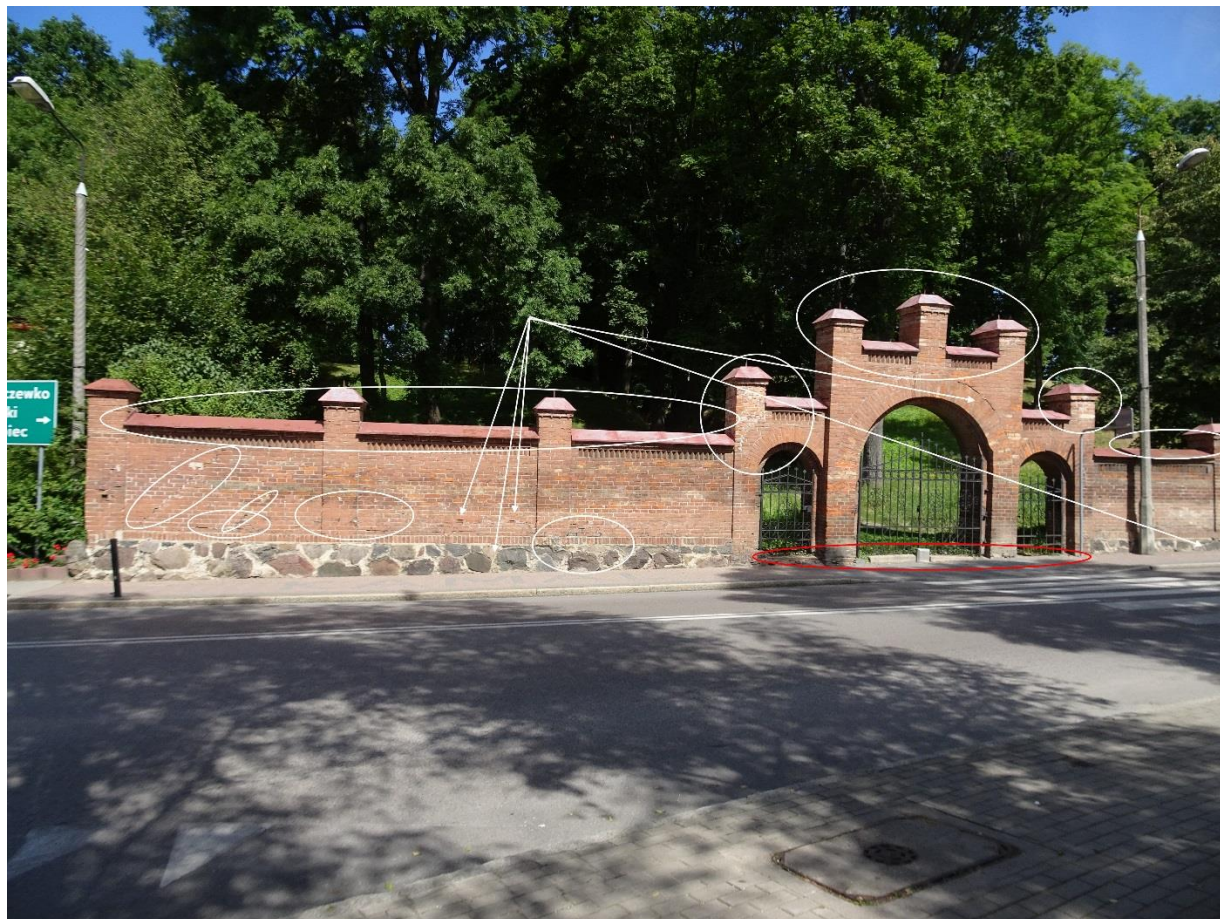
Fot. 3. Ogródzenie cmentarza – przykładowe zniszczenia: pęknięcia muru, ubytki spoinowania i cegieł oraz przemurowania słupków i sterczyn.
