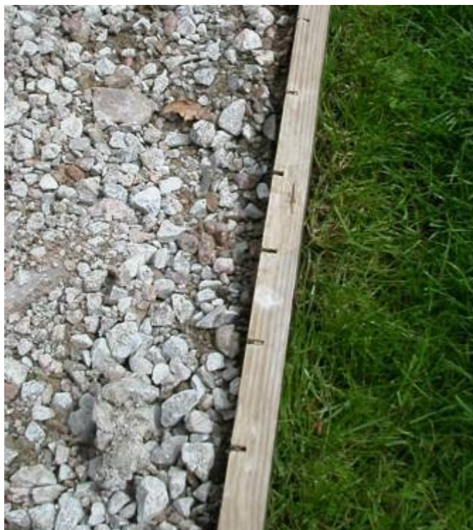
Sposób nacięcia deski w celu jej wygięcia źródło: www.pavingexpert.com
