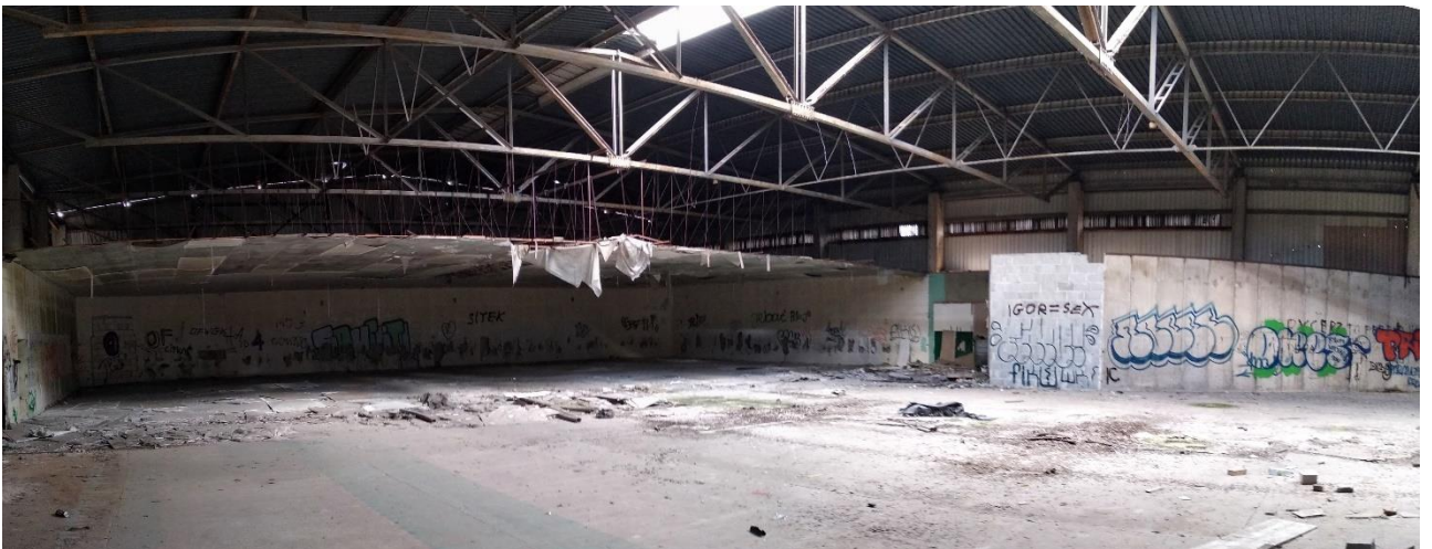
Budynek nr 3 – widok od wewnątrz, Fot. 2022 r.
