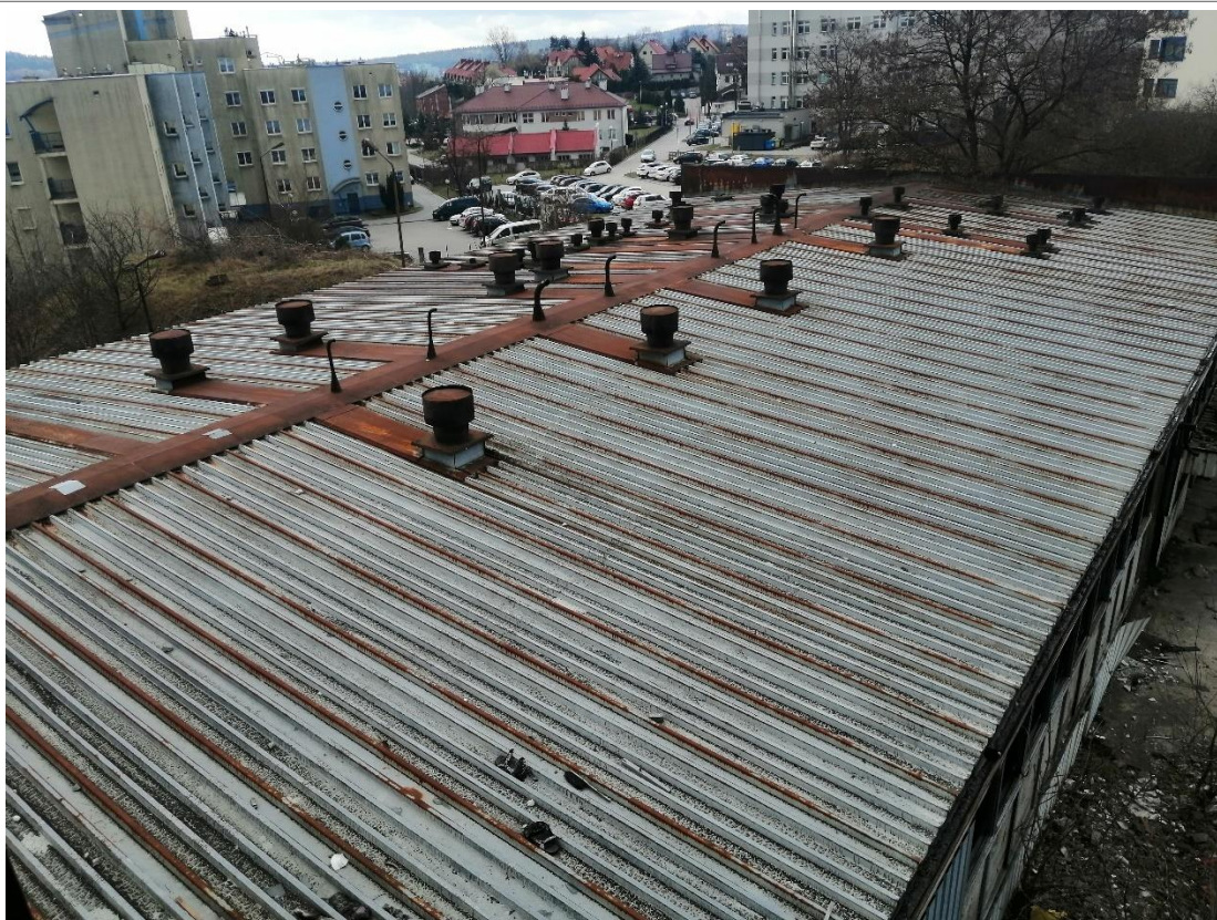
Budynek nr 1 – widok dachu, Fot. 2022 r.
