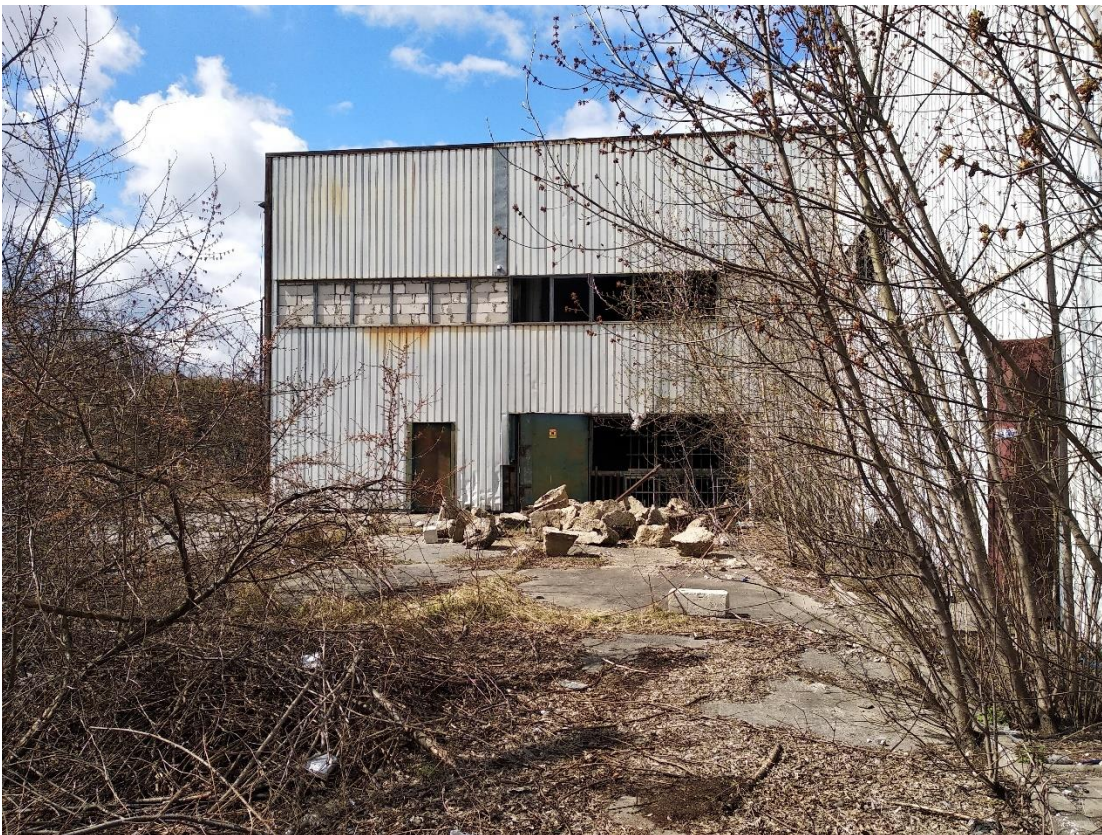
Budynek nr 1 i 2 – widok od strony wschodniej, Fot. 2022 r.
