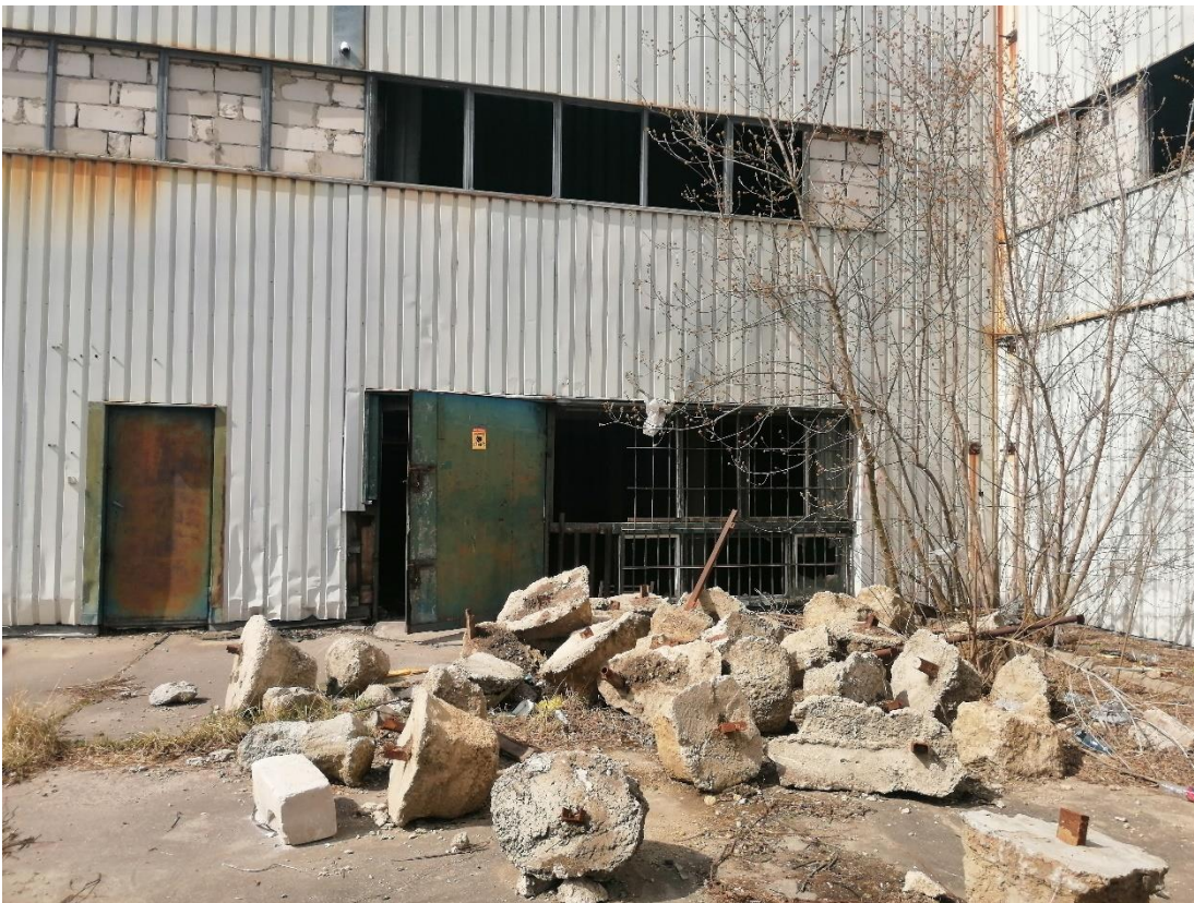
Bloki betonowe przeznaczone do utylizacji przed budynkiem nr 1 i 2 – widok od strony wschodniej, Fot. 2022 r.
