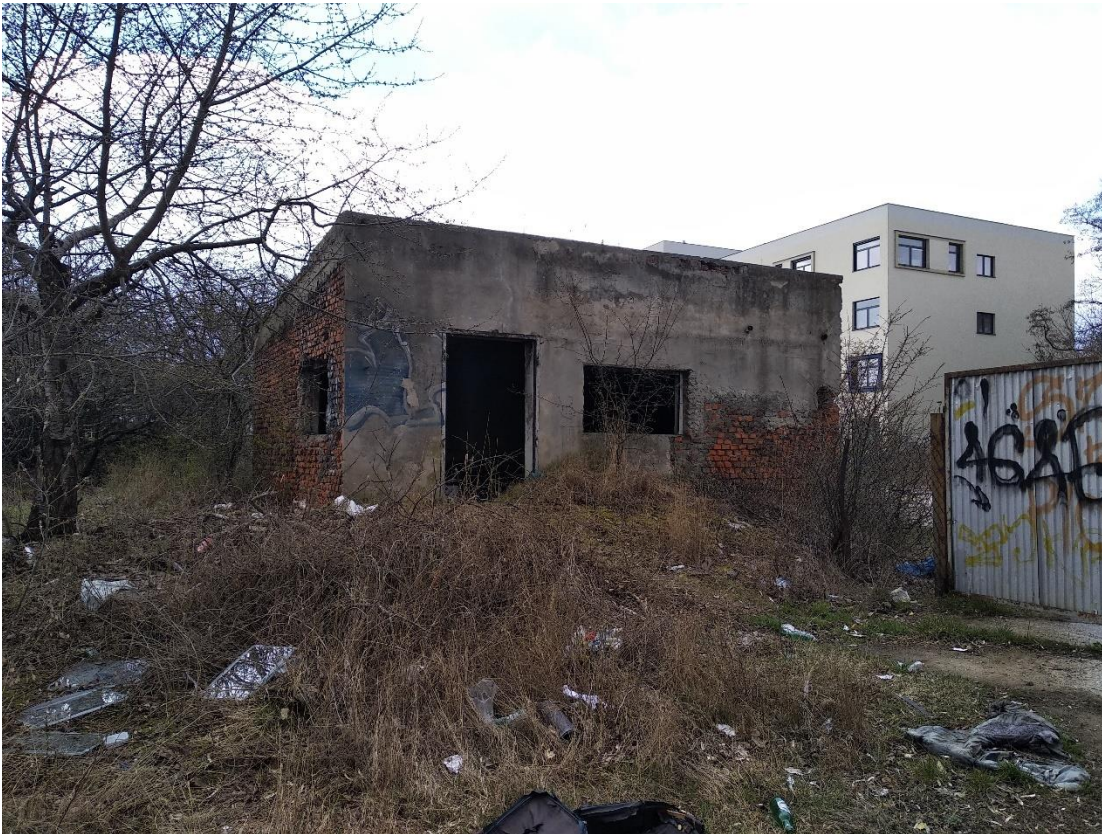
Budynek nr 4 – widok od strony północnej, Fot. 2022 r.
