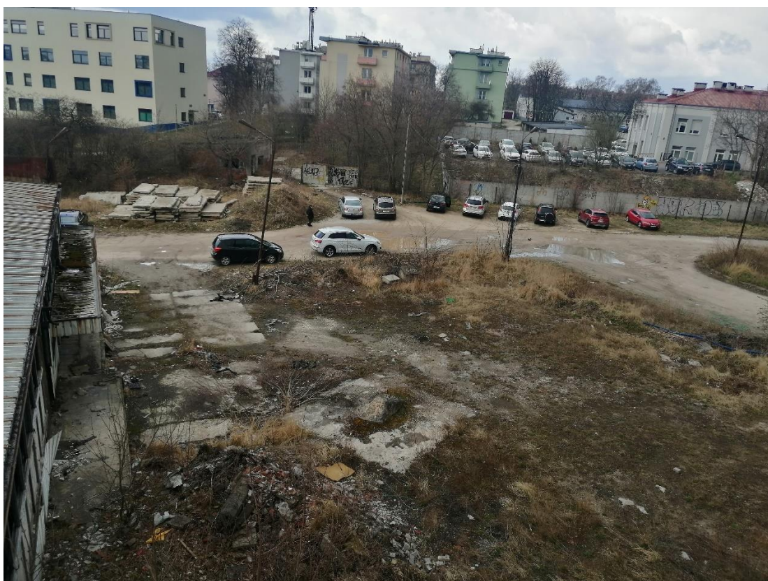
Plac przed budynkiem nr 1 i 2 od strony zachodniej, Fot. 2022 r.
