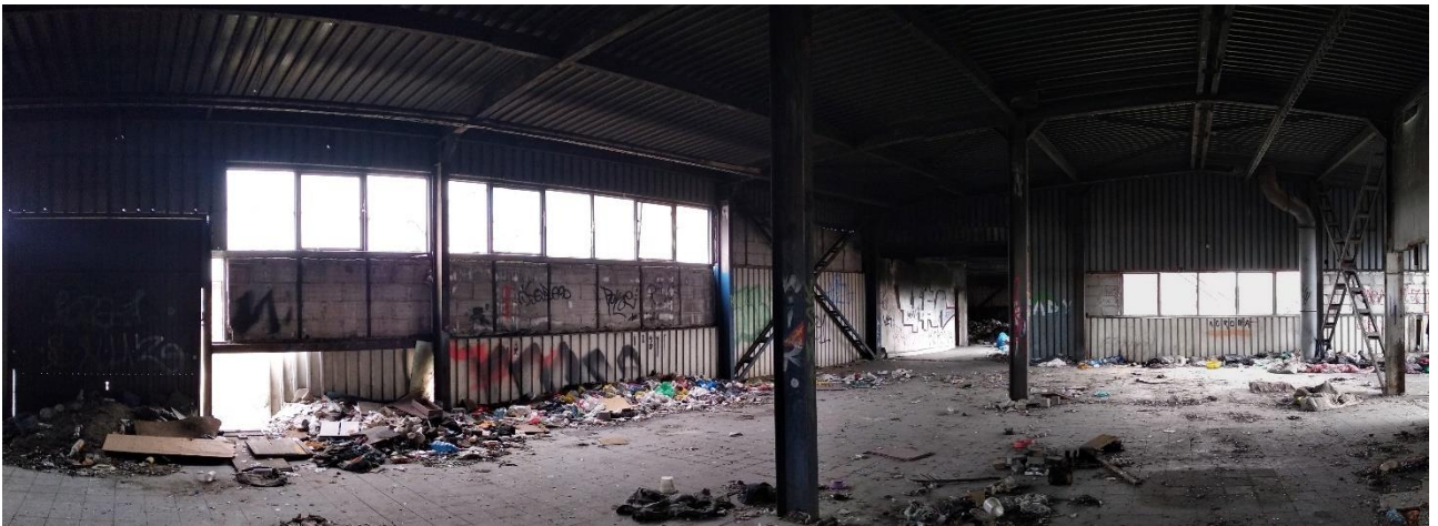
Budynek nr 1 – widok od wewnątrz, Fot. 2022 r.
