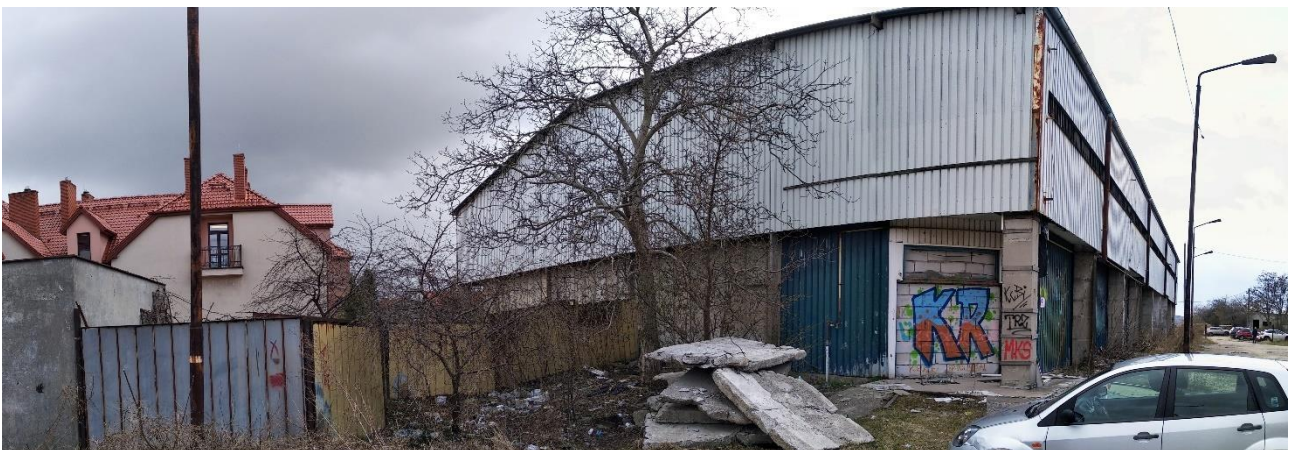
Budynek nr 3 - widok od strony północnej, Fot. 2022 r.
