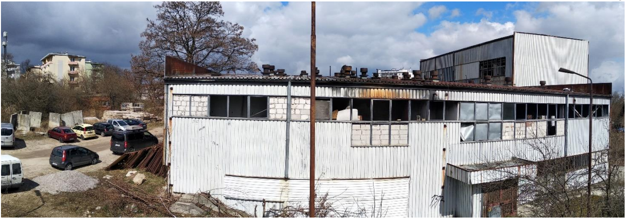
Budynek nr 1 - widok od strony południowej, Fot. 2022 r.
