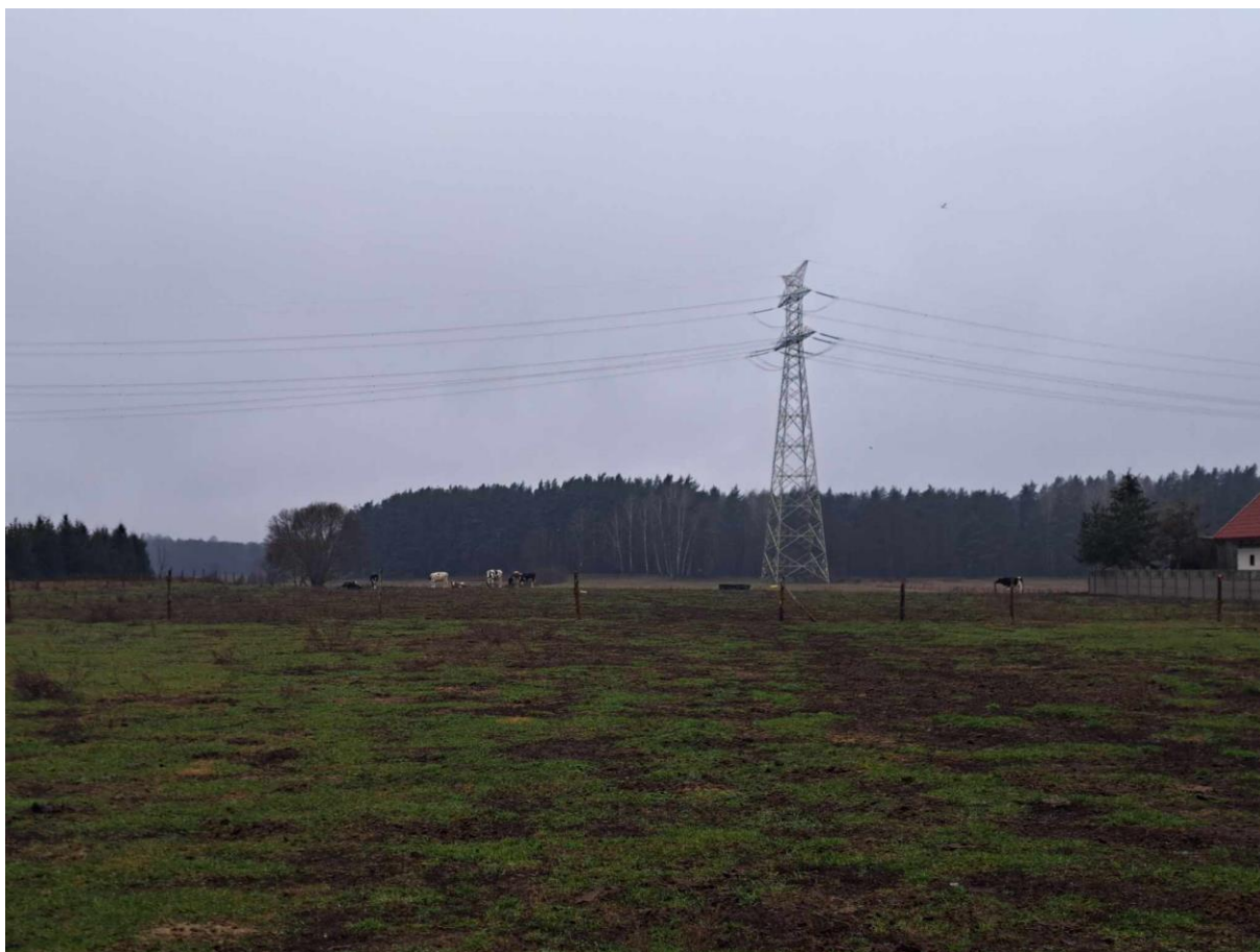
Rys.1 Dz.nr. 9/1 obręb Płozy teren budowy oczyszczalni – zamiennie przepompownia ścieków.
