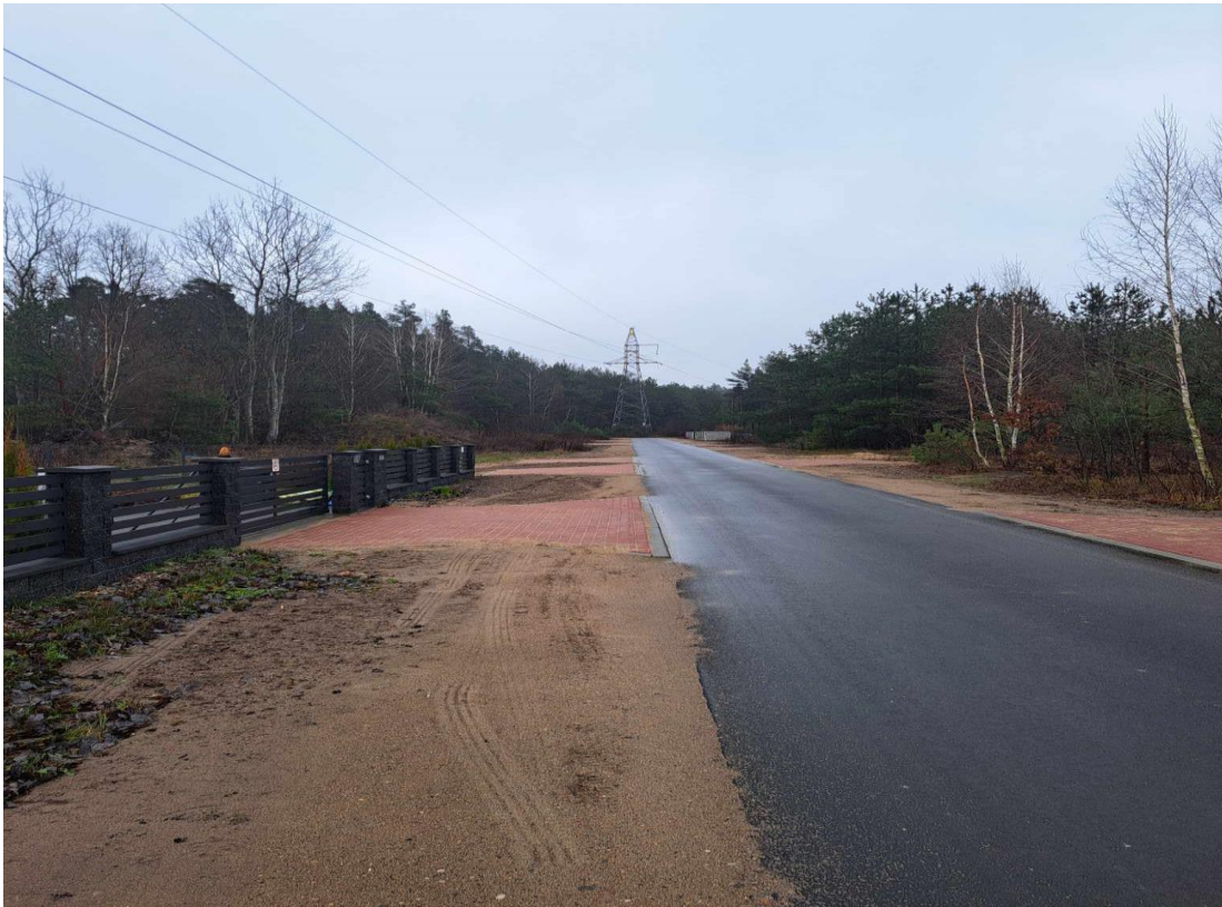
Rys.6 Dz.nr. 123/1 – widok miejsca prowadzenia kolektorów w msc. Nowe Gizewo (droga gminna dz.nr. 129/28)
