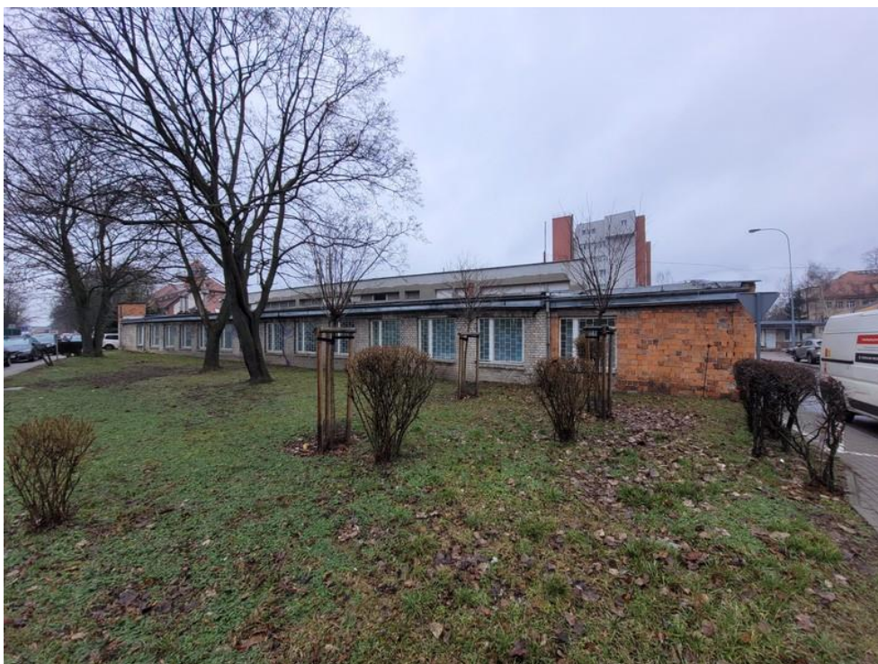
Ryc. 3. Budynek „G” – strona południowa.
