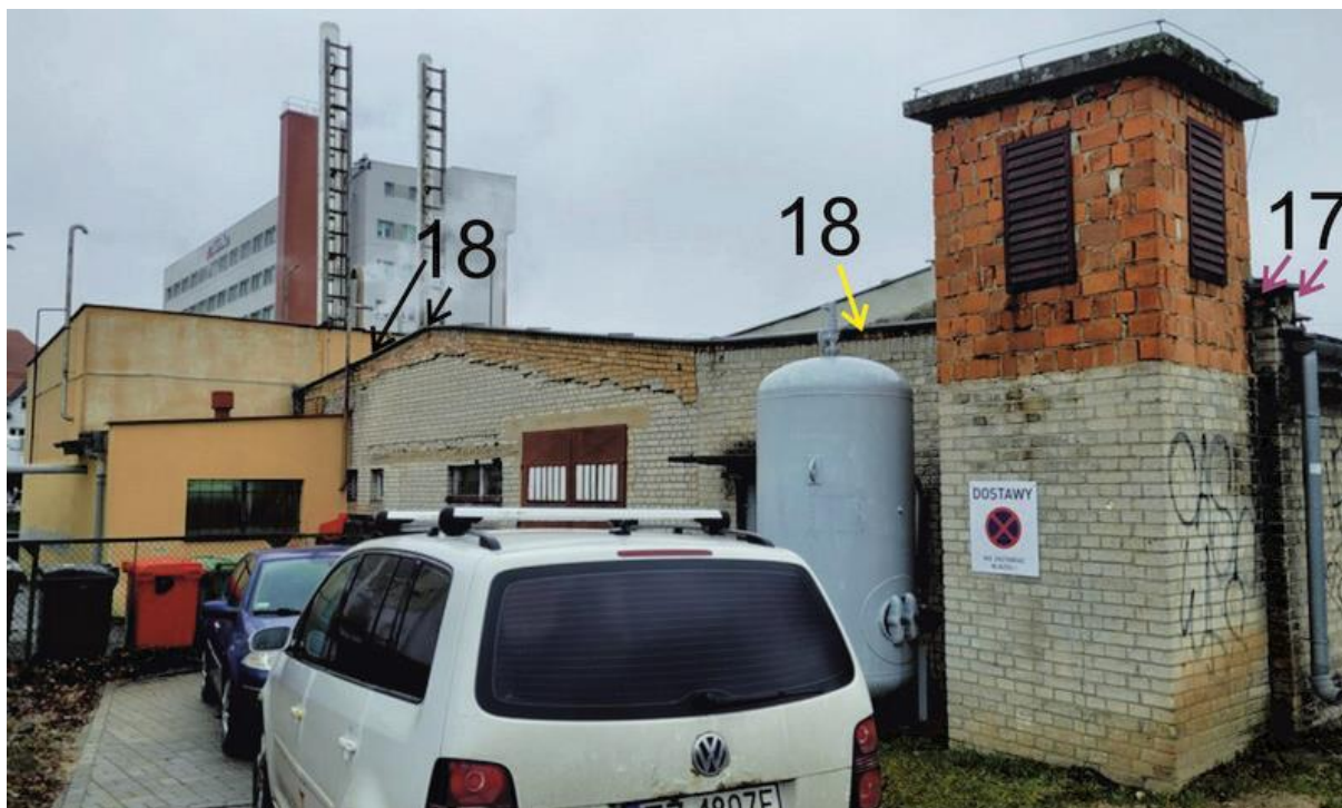
Ryc. 11. Ściana zachodnia budynku z zaznaczeniem pozycji opisanych w tekście.
