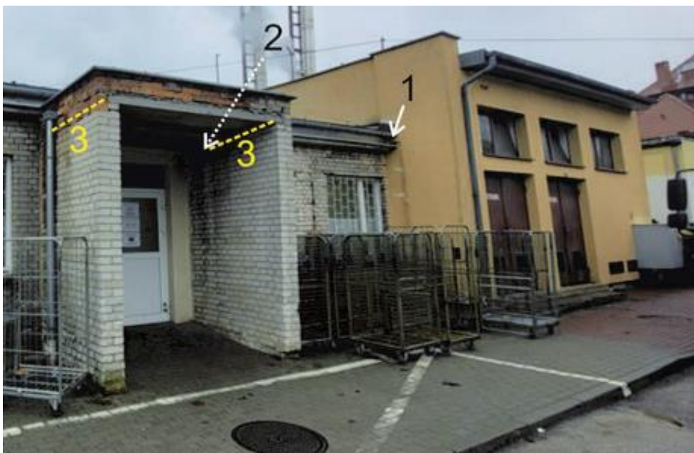
Ryc. 7. Ściana północno-zachodnia budynku z zaznaczeniem pozycji opisanych w tekście.
