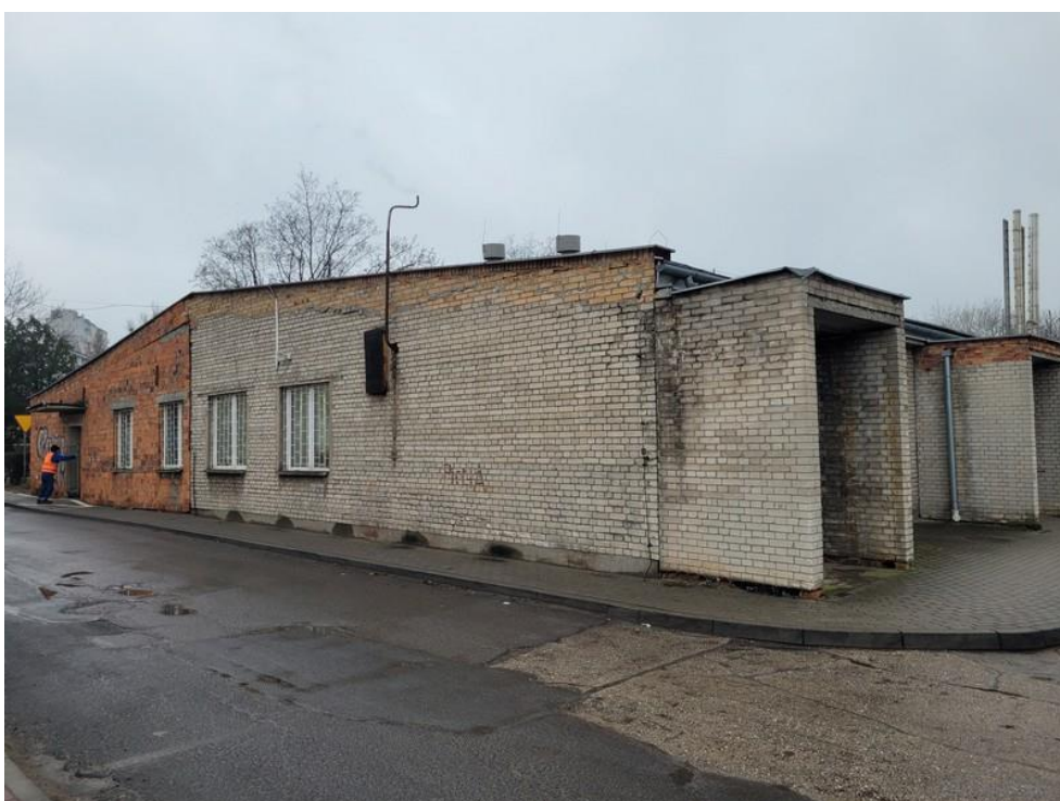
Ryc. 4. Budynek „G” – strona wschodnia.
