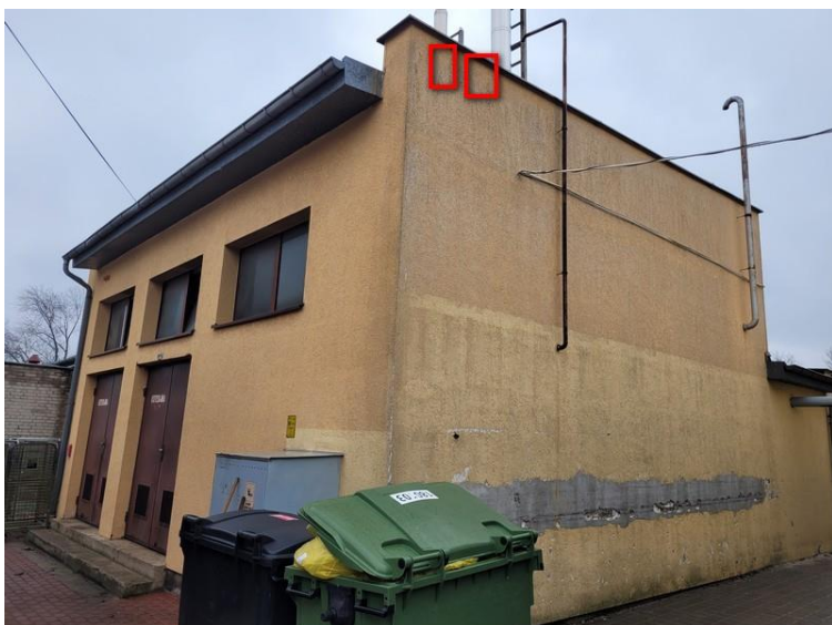
Ryc. 15. Proponowane miejsce zawieszenia 2 skrzynek dla nietoperzy (czerwone prostokąty) – ściana zachodnia kotłowni.
