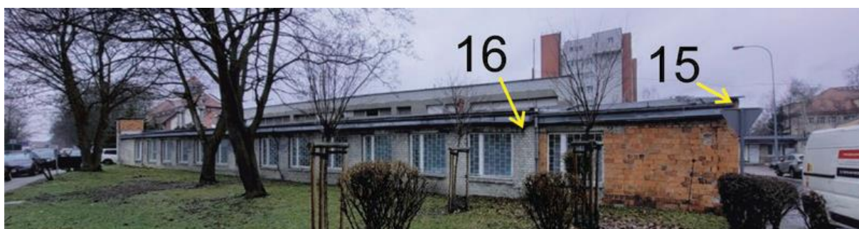
Ryc. 10. Ściana południowo-wschodnia budynku z zaznaczeniem pozycji opisanych w tekście.
