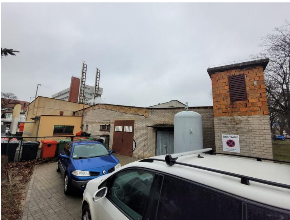
Ryc. 2. Budynek „G” – strona zachodnia.
