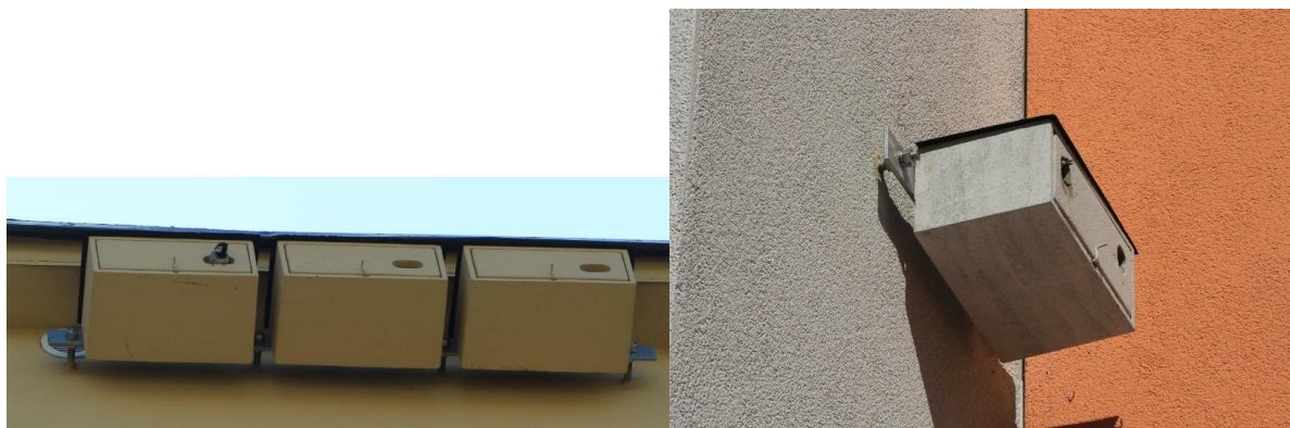
Ryc. 17. Przykładowy sposób zamocowania budek trocinobetonowych do budynku – za pomocą płaskownika i prętów gwintowanych.
