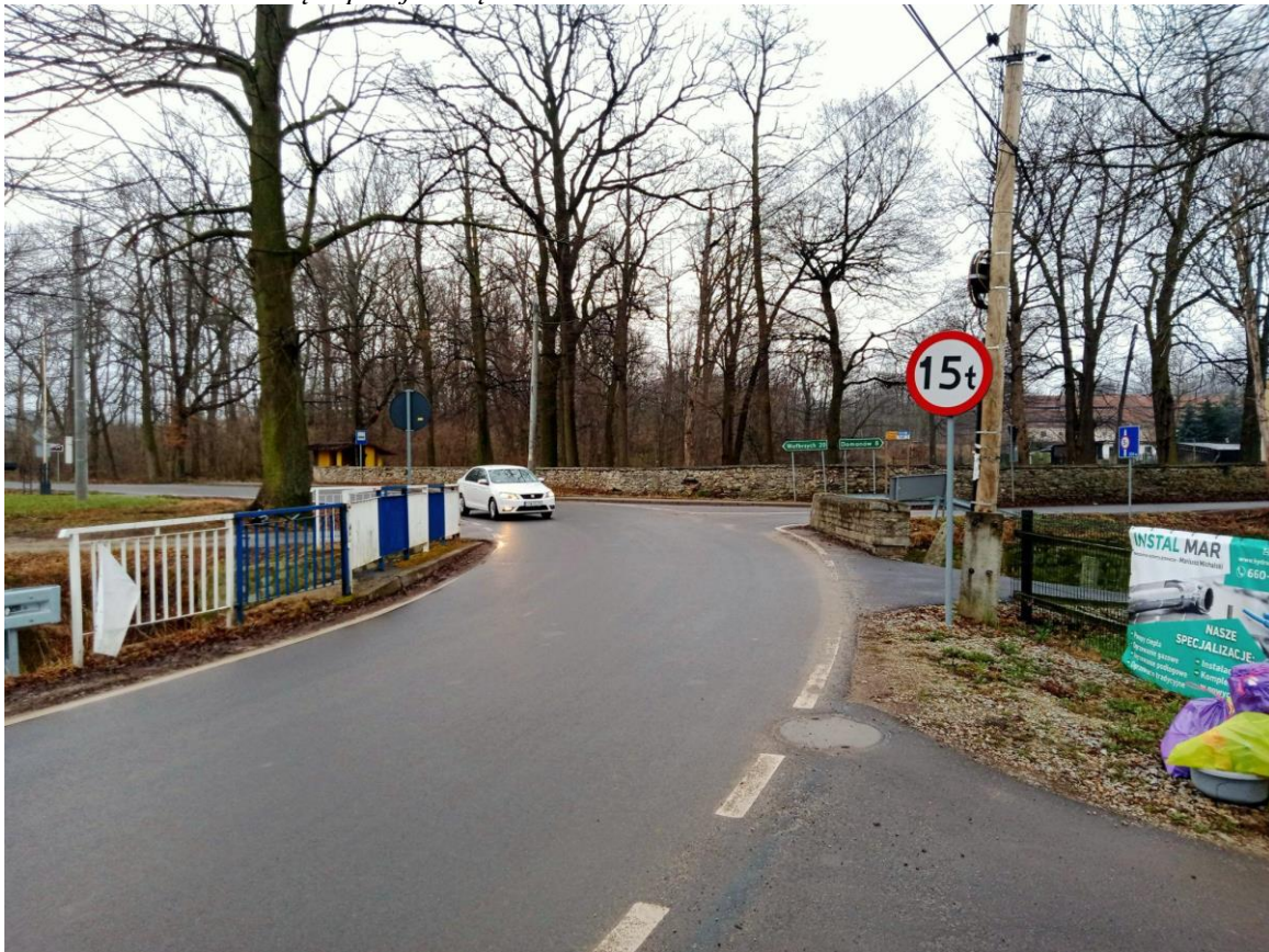
Foto nr 1. Widok na część przejezdną mostu.
