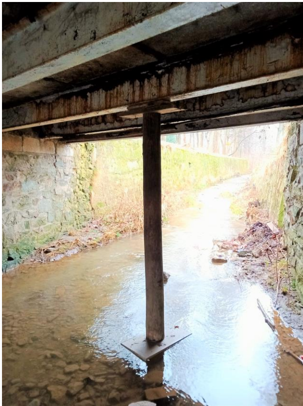
Foto nr 4 i 5. Prowizoryczne podparcie dźwigara niosącego za pomocą elementu drewnianego;
