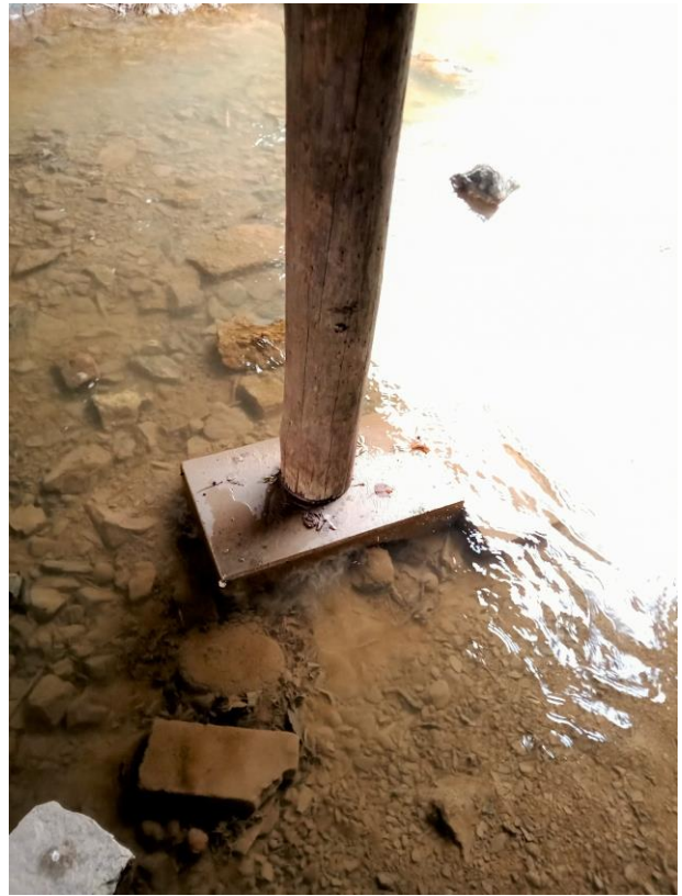
Foto nr 4 i 5. Prowizoryczne podparcie dźwigara niosącego za pomocą elementu drewnianego;
