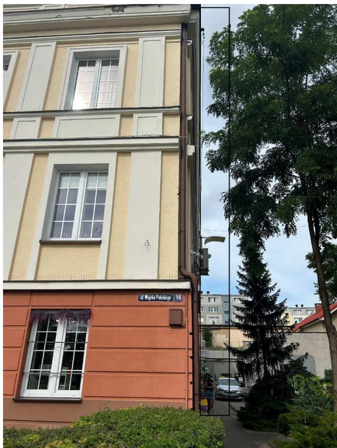
Wschodnia strona budynku
