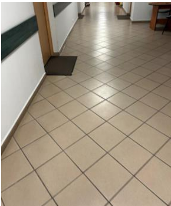
Posadzka na ciągach komunikacyjnych
