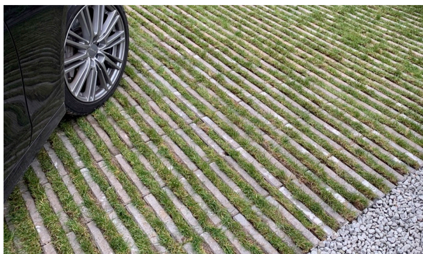
Ryc. 12: przykładowa forma i wymiary płyty betonowej przerośniętej trawą
