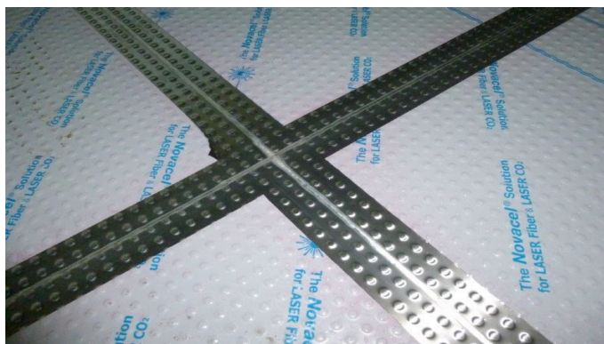
Ryc. 63: sposób wykonania dna niecki basenu
