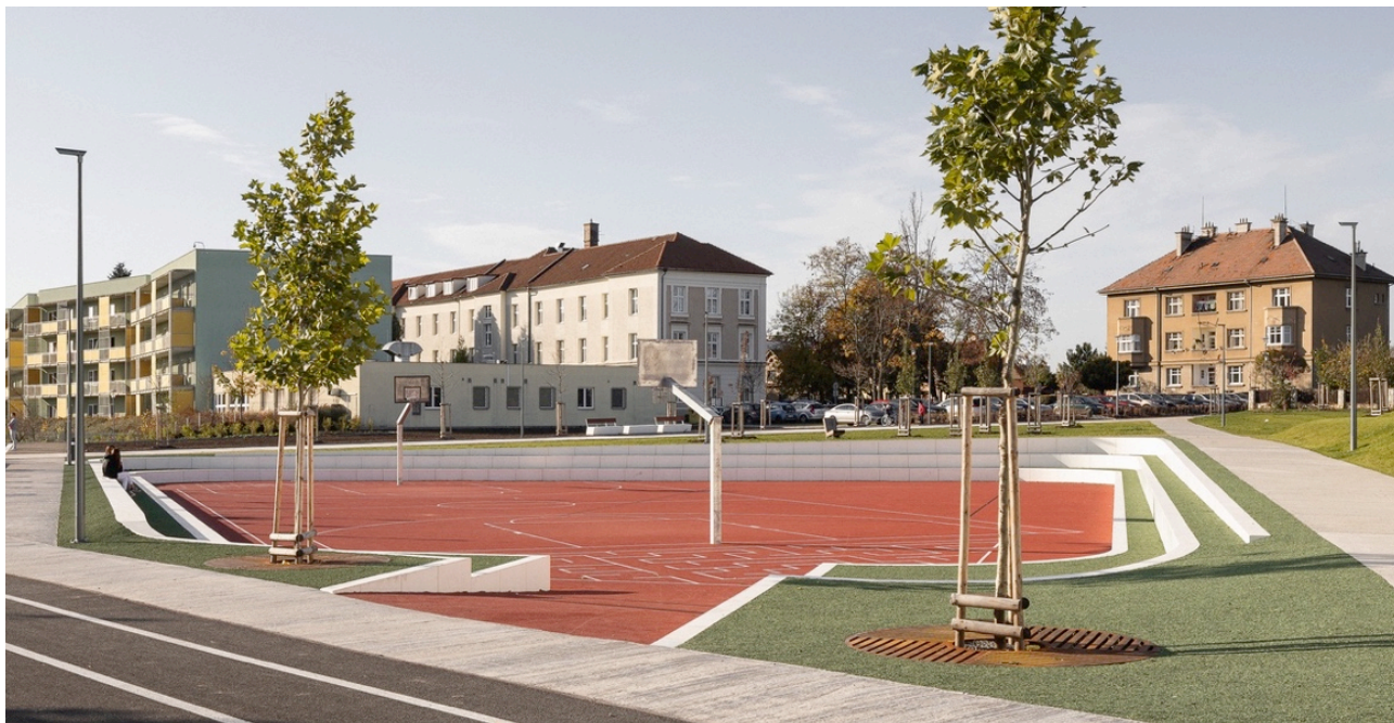
Ryc. 10: boiska rekreacyjne – rozwiązanie referencyjne / Park w miejscowości Vysoké Mýto, Czechy; projekt: Buoy, 2022; reprodukcja za : archdaily.com
