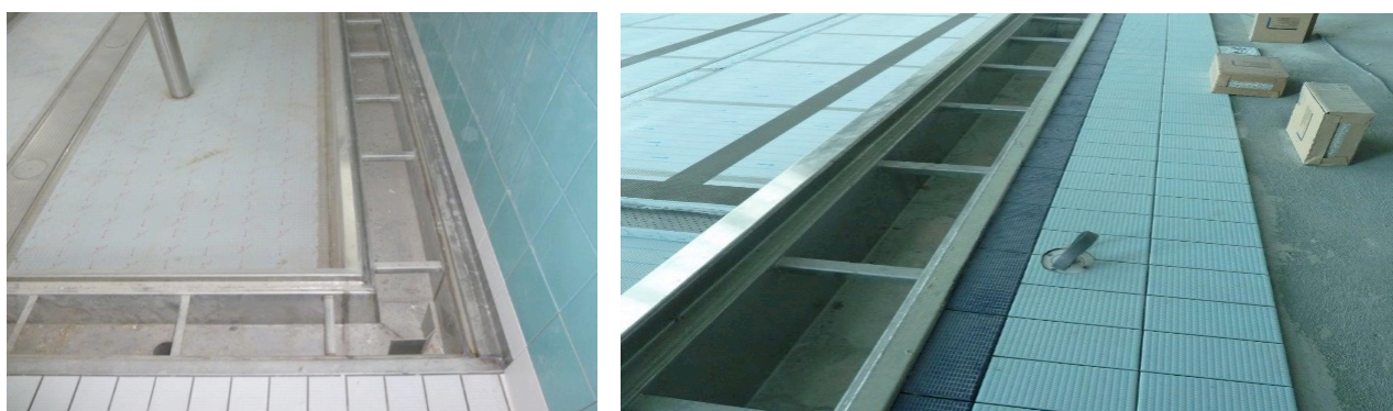
Ryc. 62: sposób wykonania rynny przelewowej
