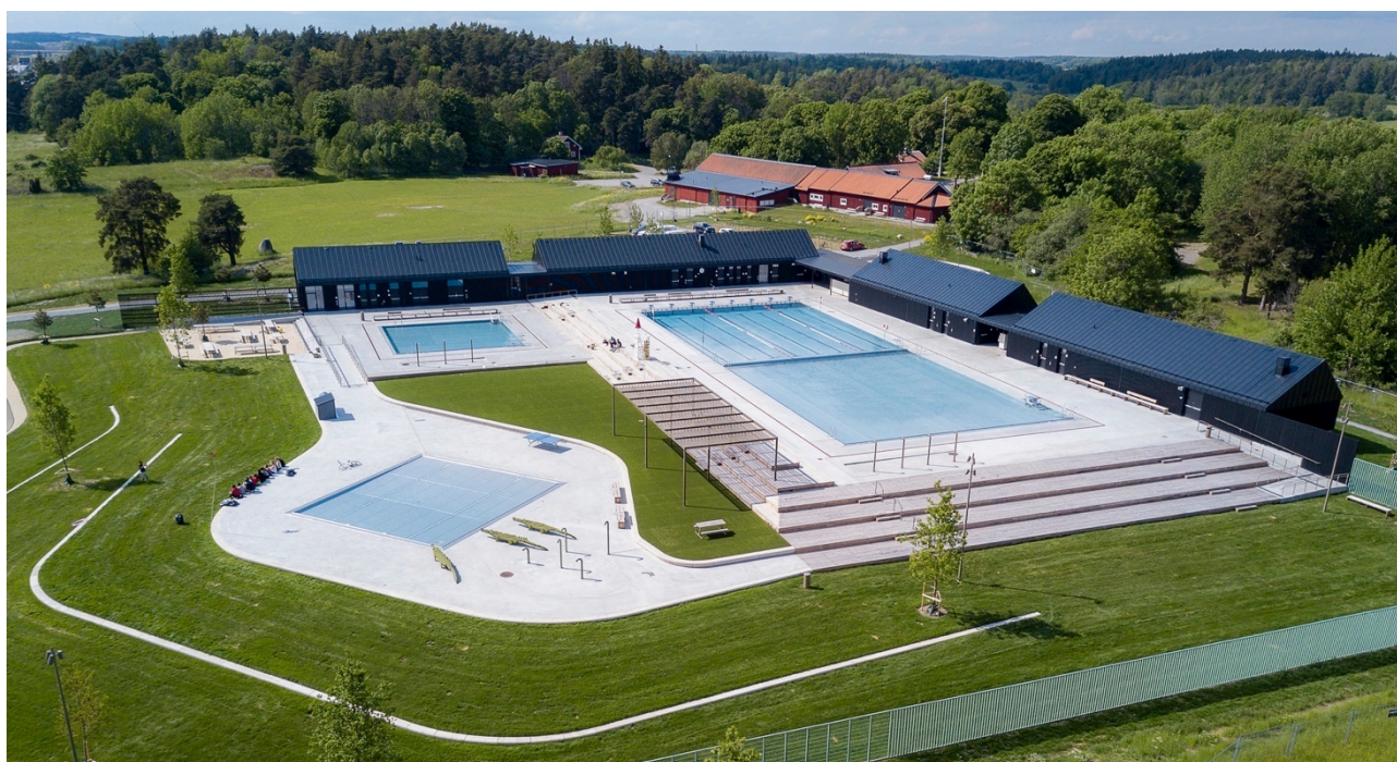
Ryc. 6: zespół basenów zewnętrznych – przykładowe rozwiązanie referencyjne / baseny Järvabadet w Sztokholmie, Szwecja; projekt Richard Kavall, Valentino Barbu, Mirja Henriksson, Tomas Rosén, Klara Dagnäs 2020; reprodukcja za : www.archdaily.com
