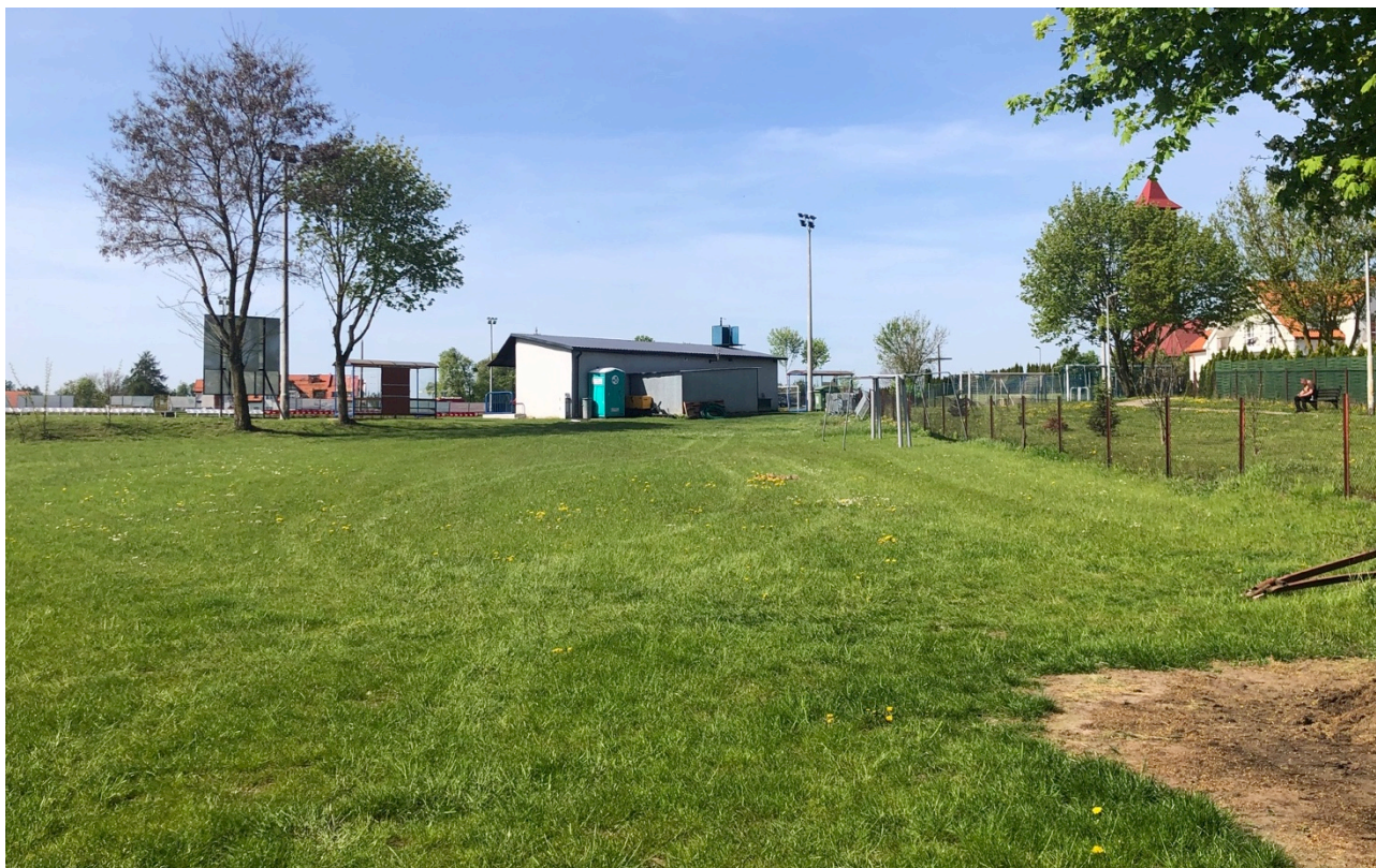
Ryc. 4: stan istniejący zagospodarowania terenu, widoczne obiekty pomocnicze – magazynowe stadionu przewidziane do rozbiórki w ramach inwestycji / fotografia ACAKA 05.2024
