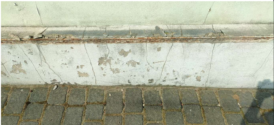
Fot.12 Budynek B1 strefa cokołowa
