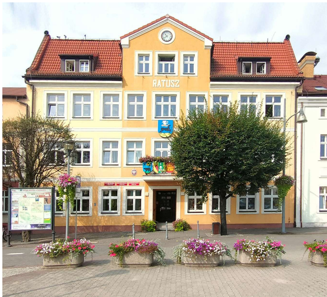
Fot.2 Budynek A,B widok od strony wschodniej
