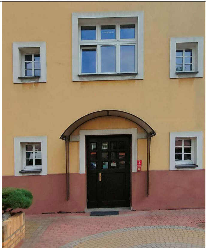
Fot.20 Budynek A Wejście od placu parkingowego
