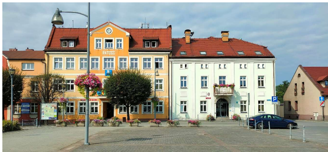
Fot.1 Budynek A,B widok od strony wschodniej
