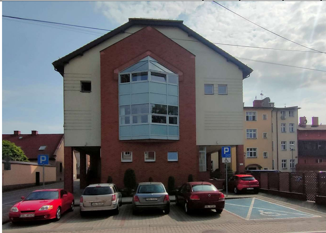
Fot. 17 Budynek B2 widok od strony zachodniej
