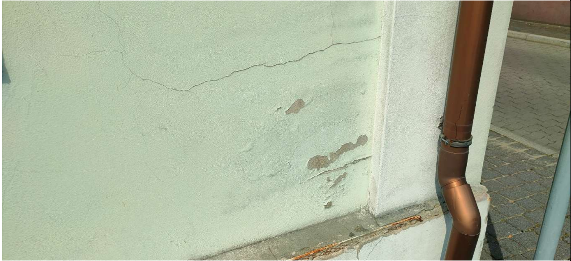
Fot.11 Budynek B1 strefa cokołowa
