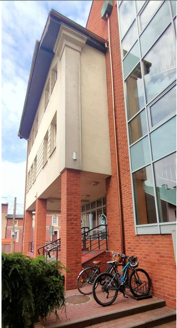
Fot.23 Budynek B2 Widok od strony południowej
