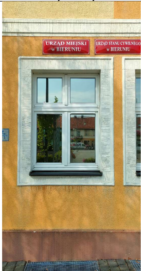
Fot.4 Budynek A okno elewacji frontowej
