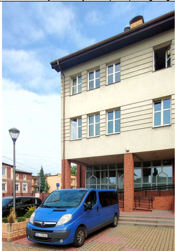
Fot.21 Budynek B2 Widok od strony południowej
