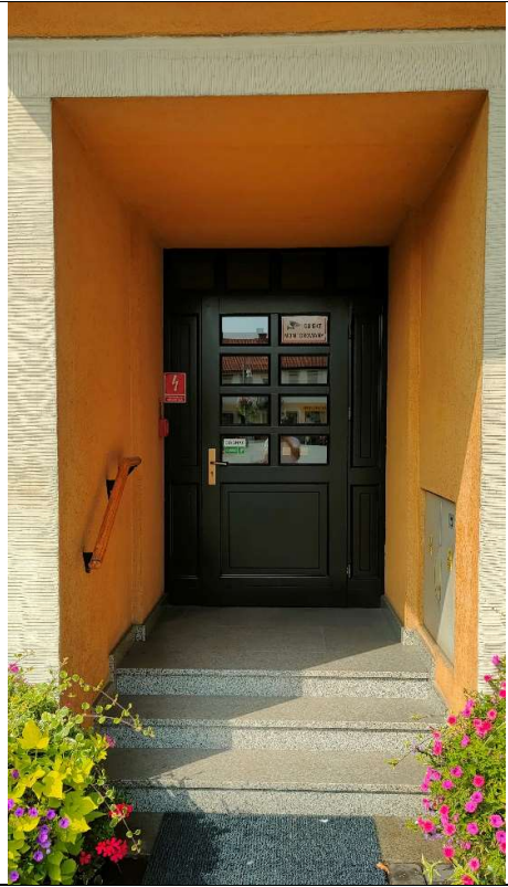
Fot.3 Budynek A wejście frontowe
