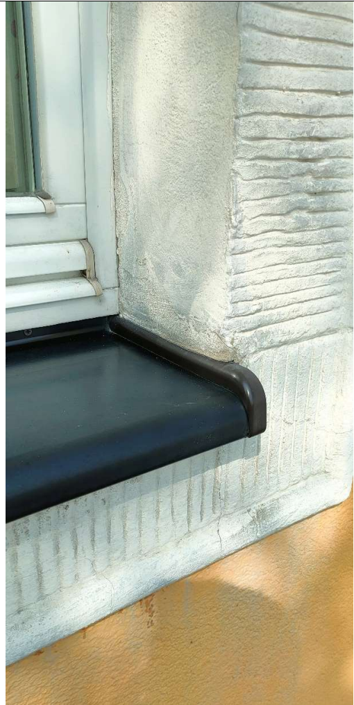
Fot.5 Budynek A elewacja frontowa
