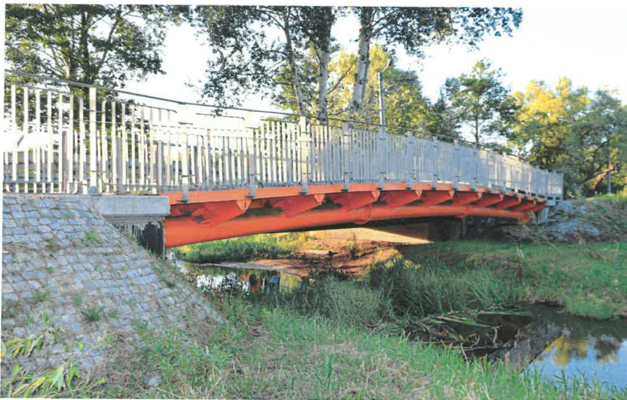
Widok ogólny obiektu mostowego
