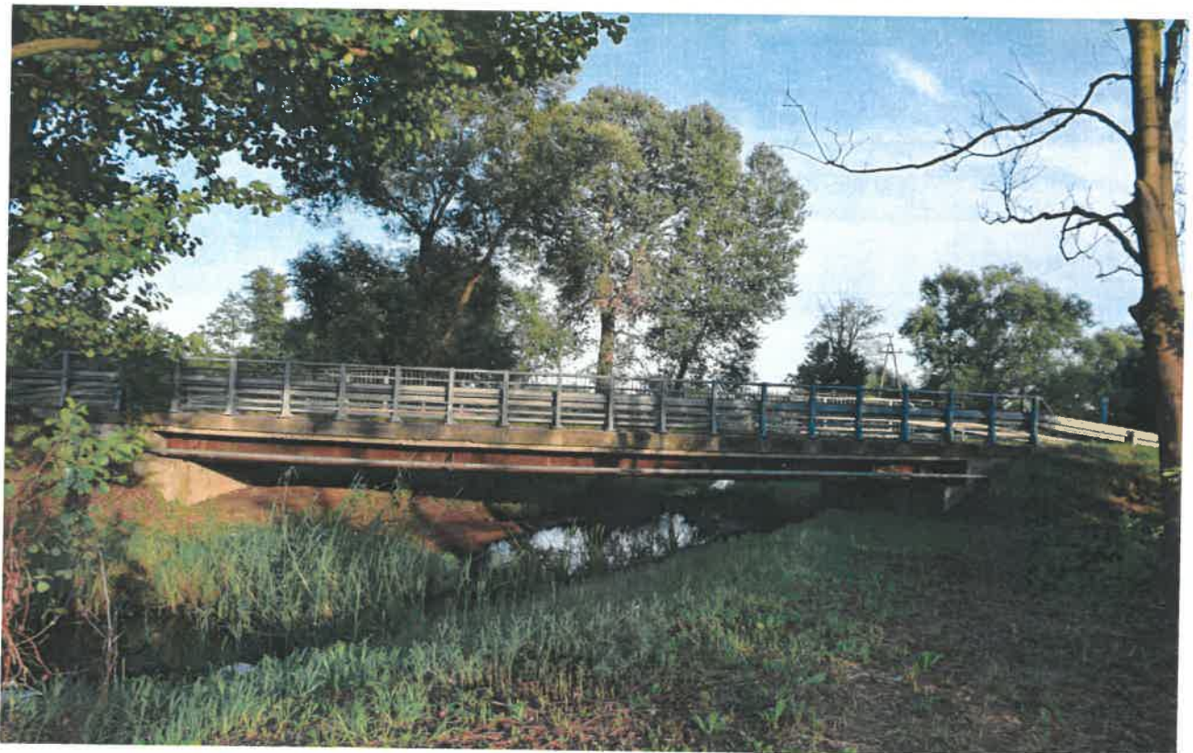
Widok ogólny obiektu mostowego
