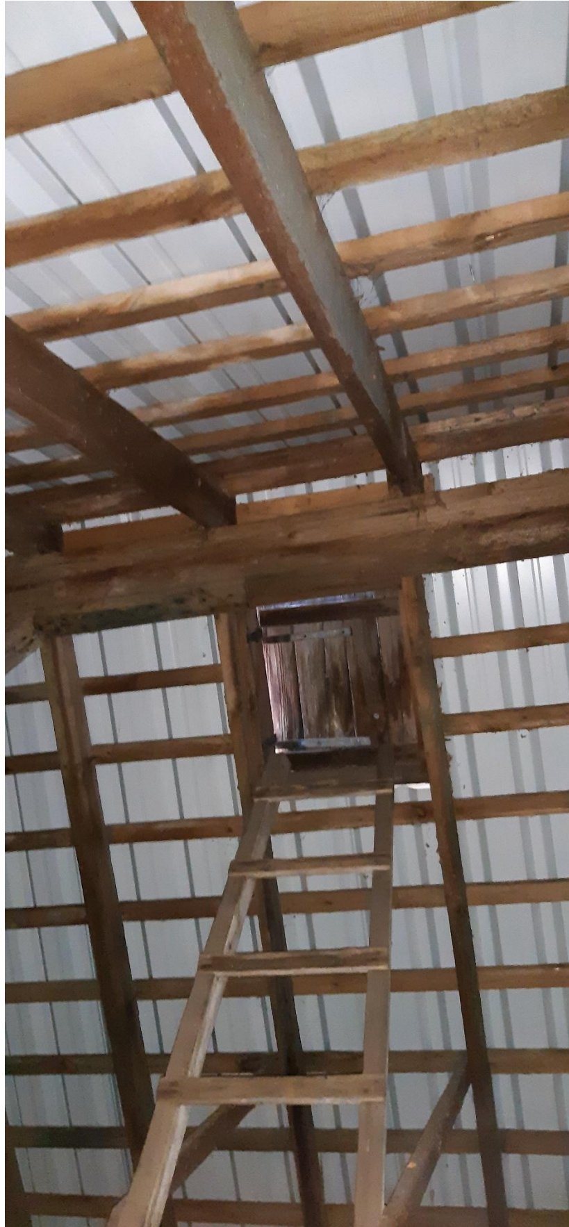
fot.25 Widok więźby dachowej oraz wyłazu na dach.
