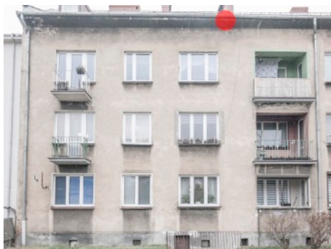
Fot. 8. Budynek ul. Tysiąclecia 2, 4, 6 w Tarnowskich Górach Zaznaczono potencjalne siedlisko lęgowe jerzyka - czerwony punkt.
