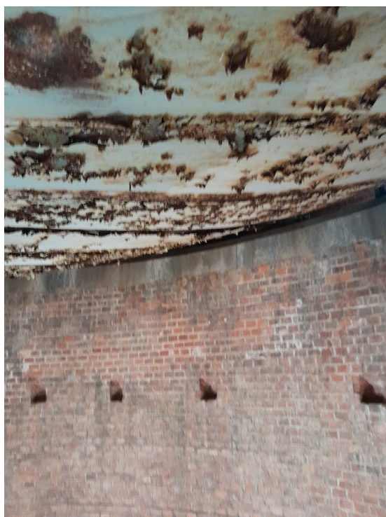
RYSUNEK 31 STAN DNA ZBIORNIKA W WIEZY CIŚNIEŃ
