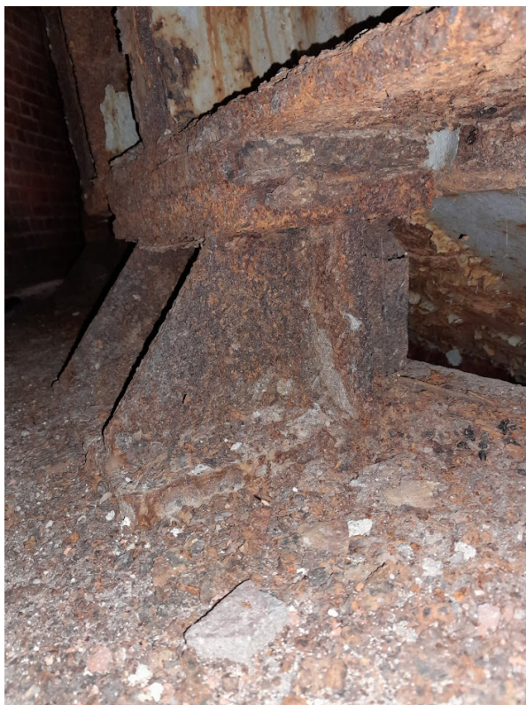
RYSUNEK 29 STAN PODPÓR ZBIORNIKA W WIEŻY CISNIENI
