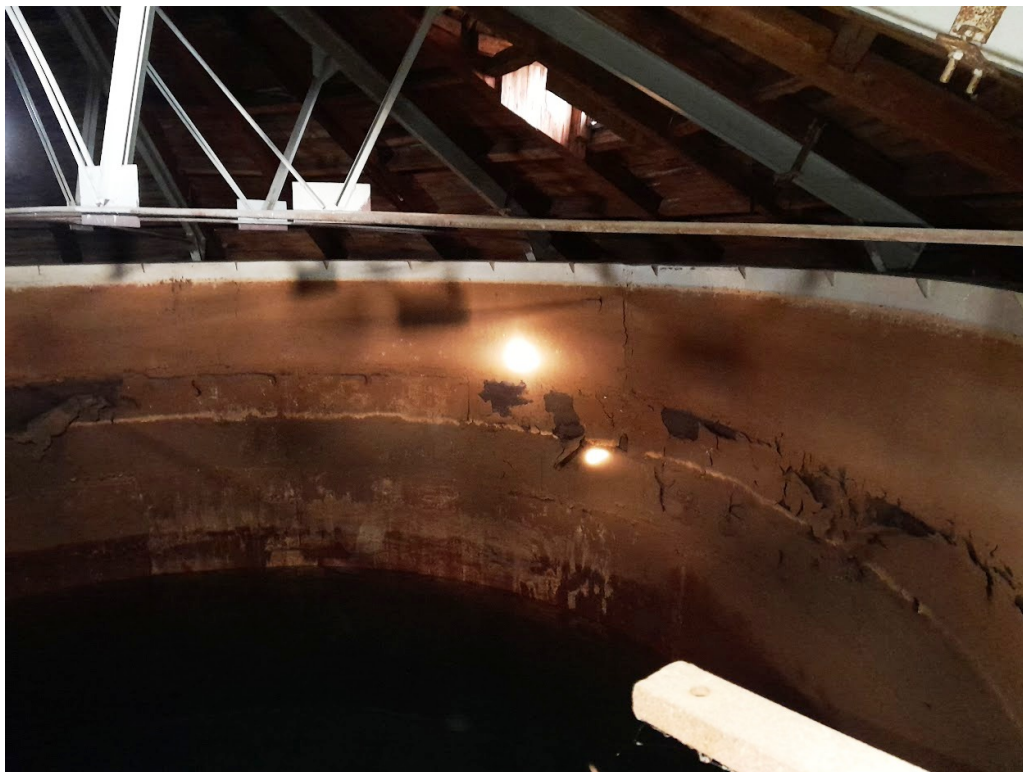
RYSUNEK 28 WNĘTRZE ZBIORNIKA W WIEŻY CISNIENI
