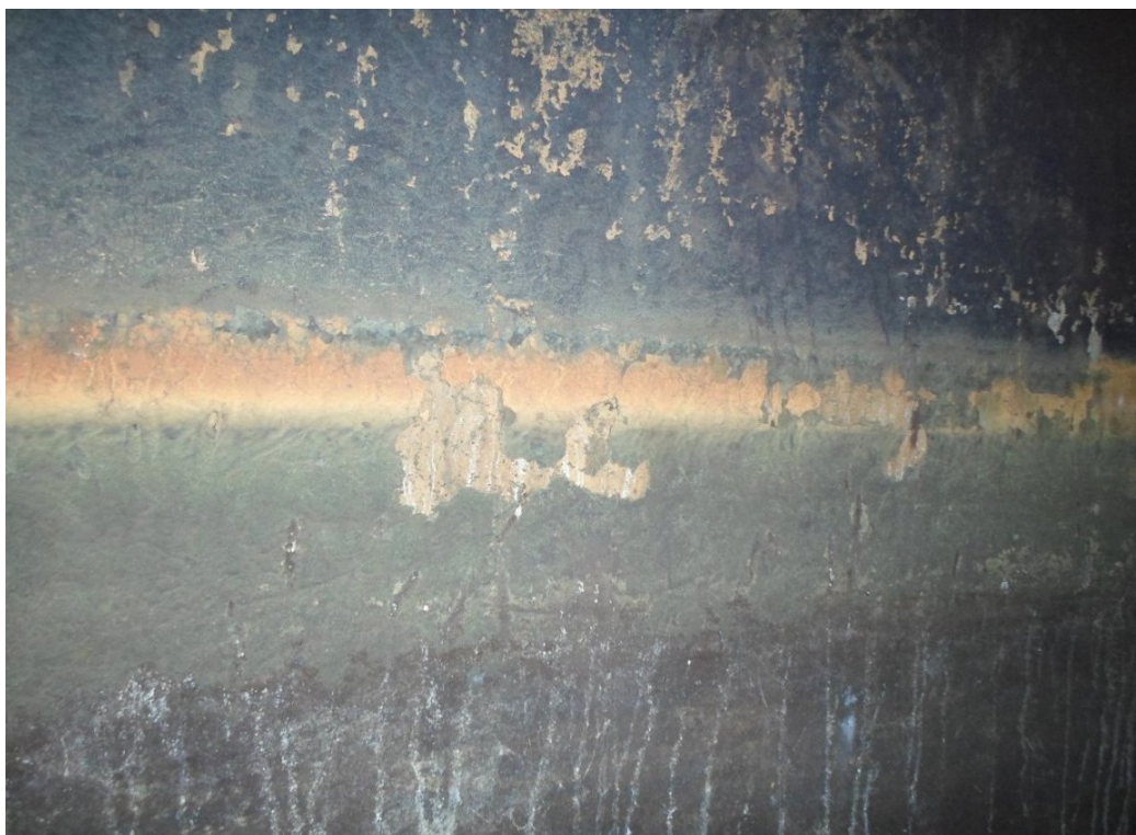
RYSUNEK 22 STAN ŚCIAN KOMORY FILTRACYJNEJ
