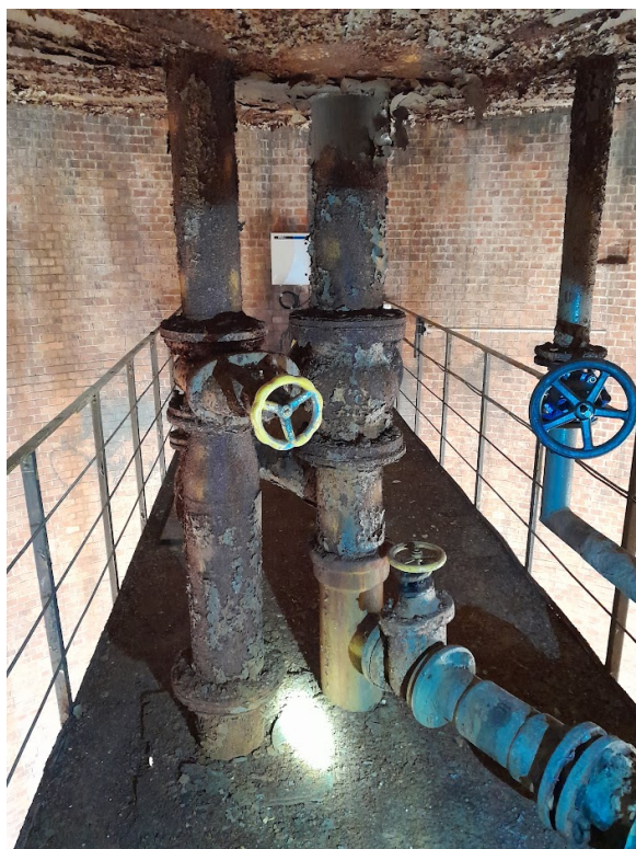
RYСУNEK 27 ZASUWY ODCINAJĄCE ZBIORNIK W WIEŻY CIŚNIEŃ
