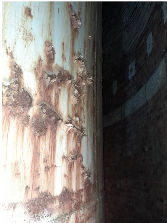
RYSUNEK 30 STAN ZEWNĘTRZNEJ STRONY ZBIORNIKA W WIEZY CIŚNIEŃ
