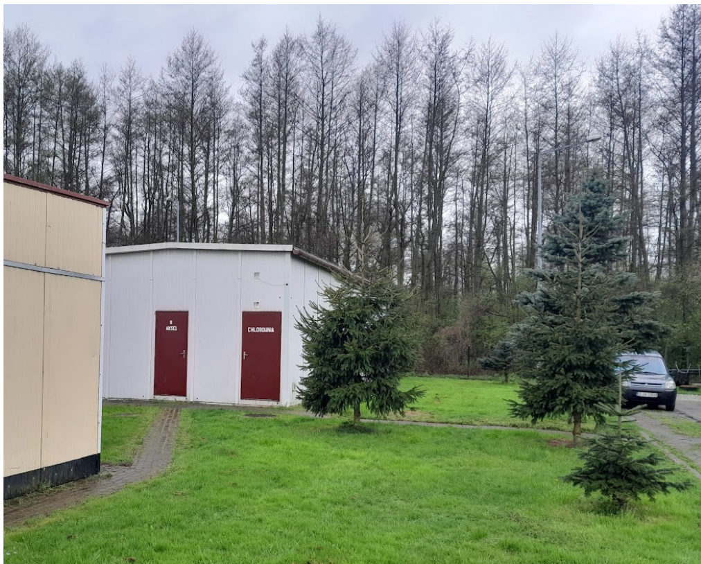
RYSUNEK 9 – BUDYNEK STACJI UZDATNIANIA NR 1
