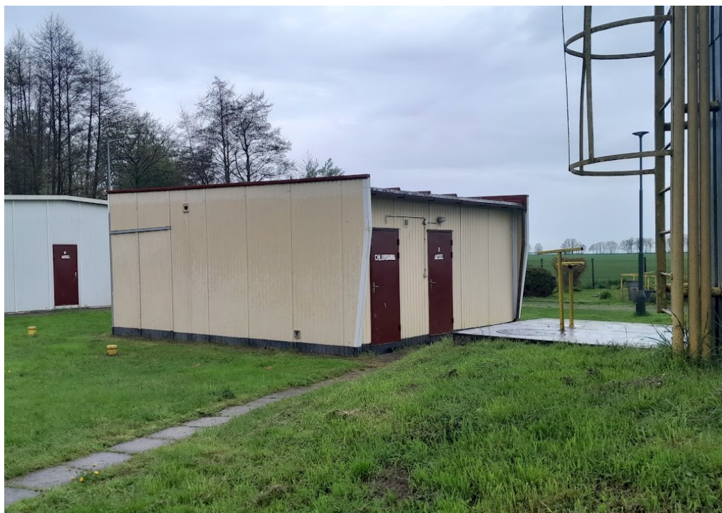
RYSUNEK 10 – BUDYNEK STACJI UZDATNIANIA NR 2
