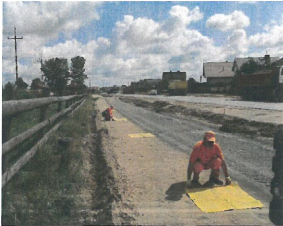
Rozmieszczenie tacek pomiarowych
