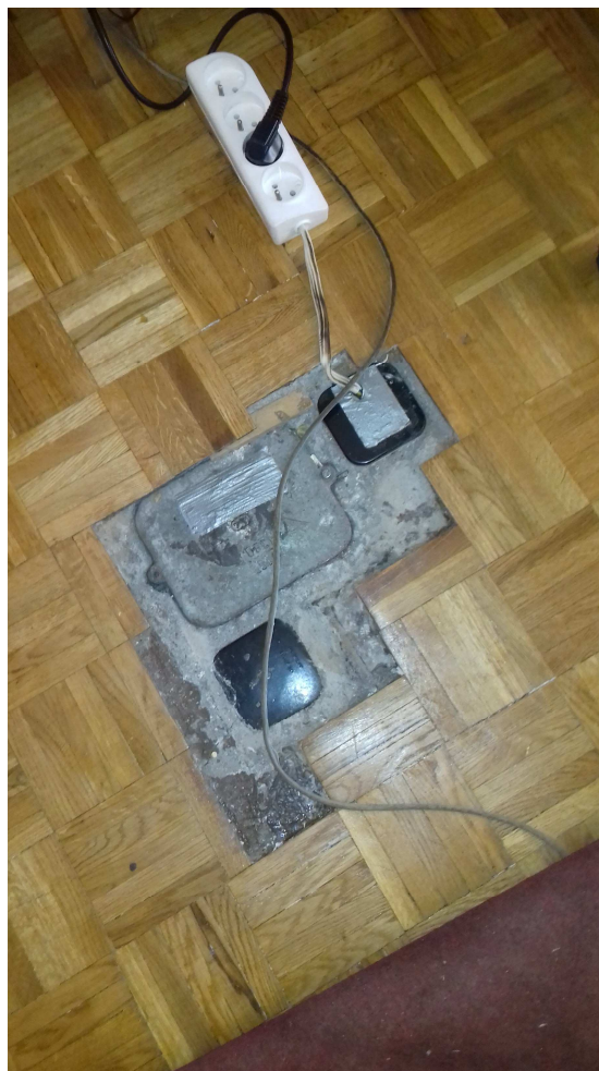
Fotografia ukazująca puszki elektryczne podłogowe do demontażu, usuniecia.
