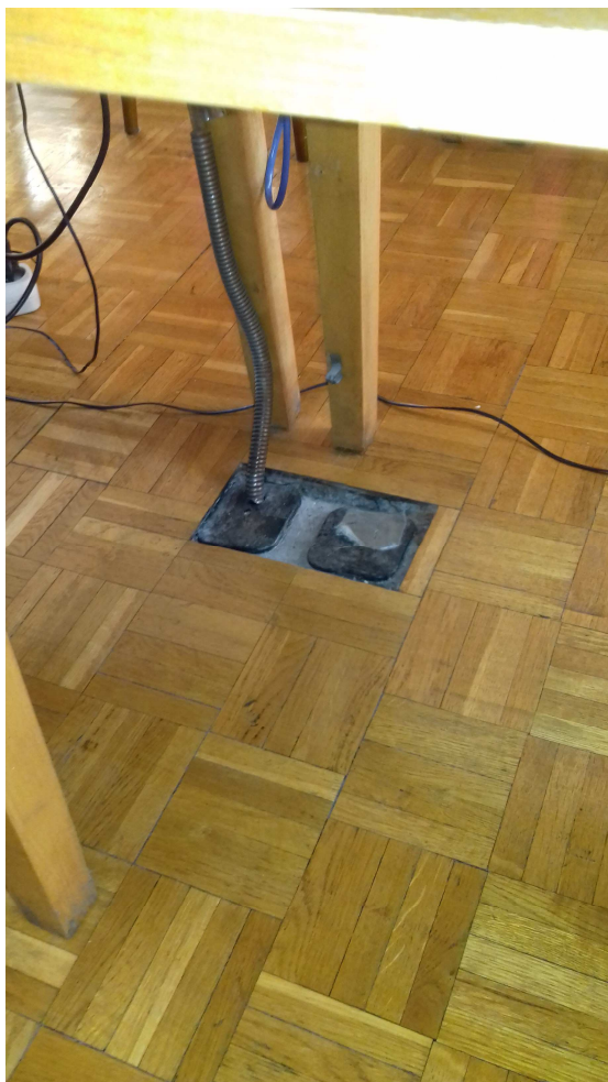
Fotografia ukazująca puszki elektryczne podłogowe do demontażu, usuniecia.
